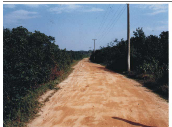
Visão da estrada de acesso ao condomínio que cortou o manguezal da Ilha do Jorge.
