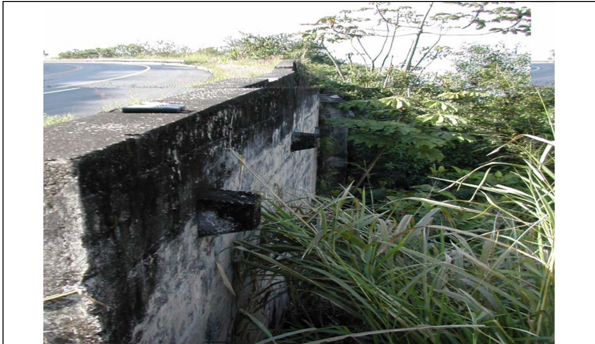
Figura 114 – Cortina à jusante da BR-101.
