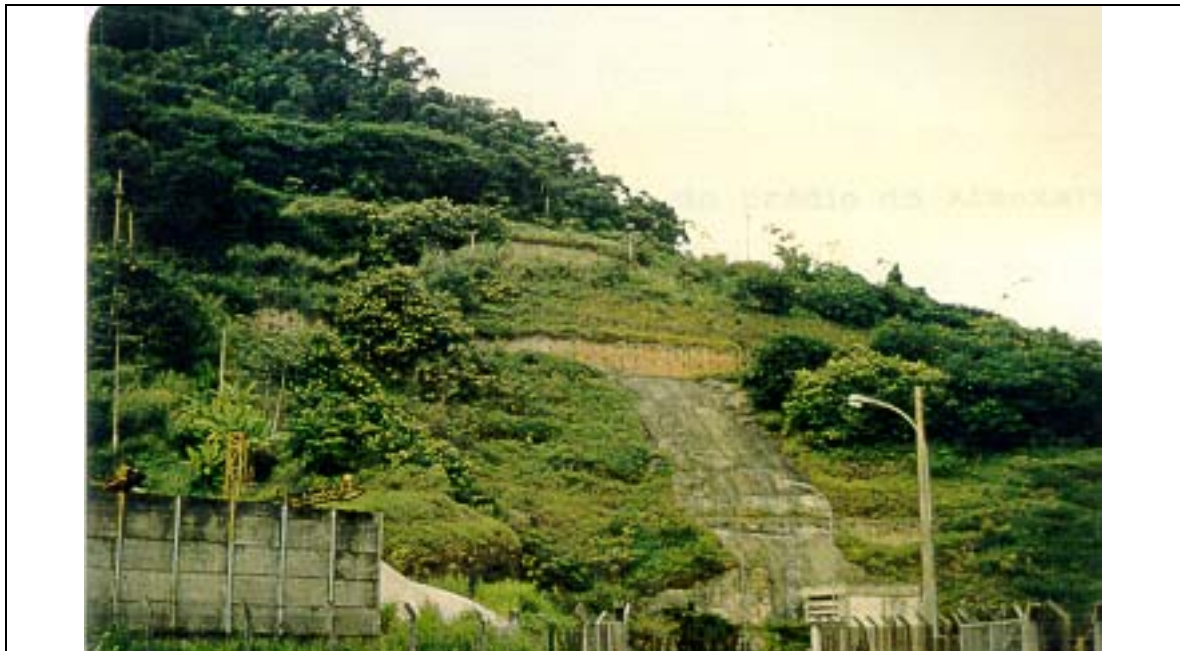
Figura 132 – Obra de contenção com duas cortinas atirantadas, e talude com concreto projetado.
