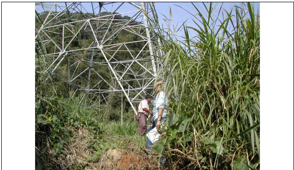
Figura 126 – A base de apoio da torre próxima à encosta.
