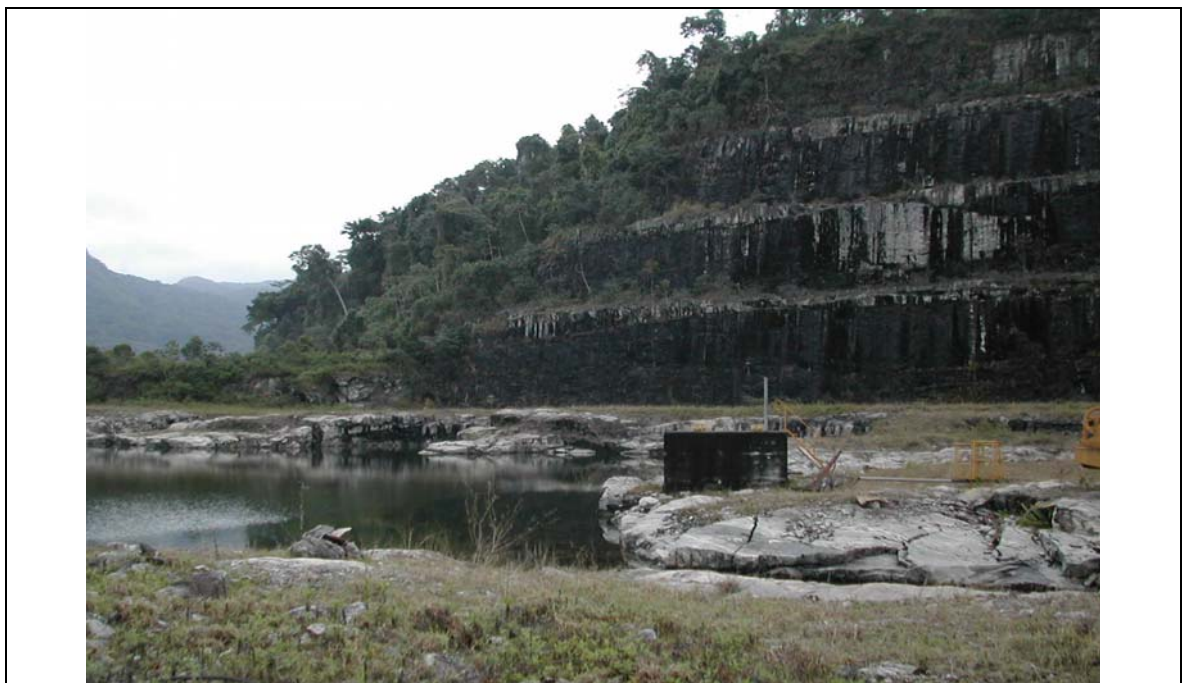
Figura 119 – Área de construção da Usina Nuclear de Angra 3.
