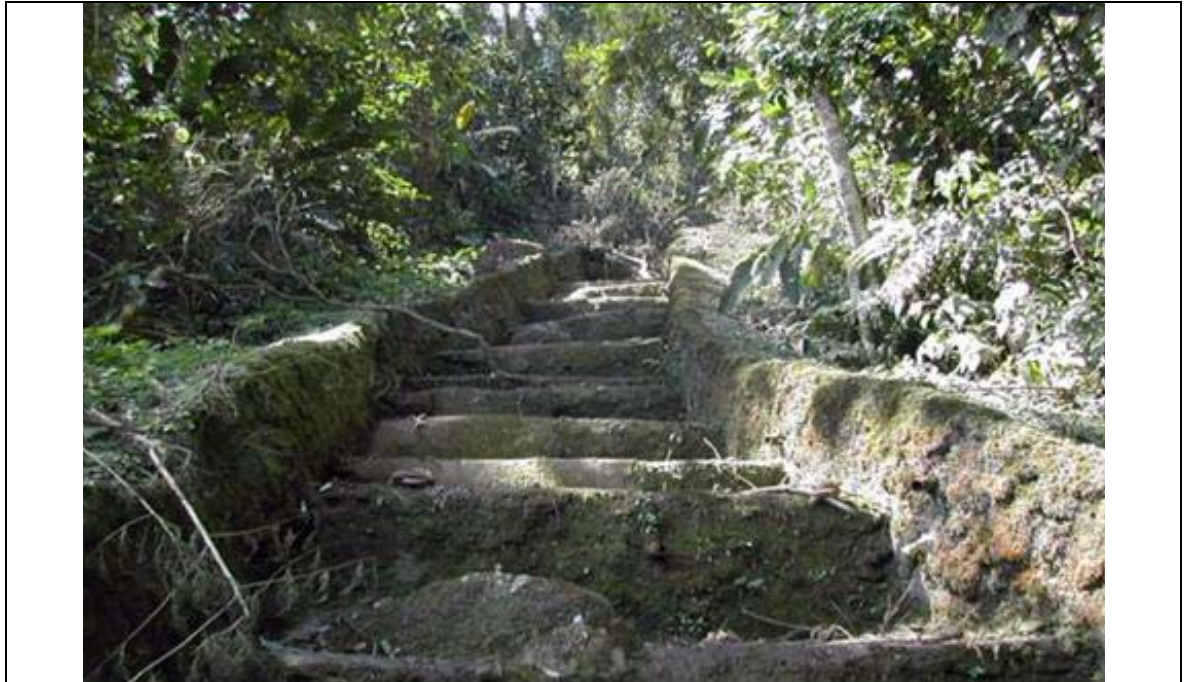
Figura 130 – Foto calha em degraus de concreto do ponto 3 da folha 3.
