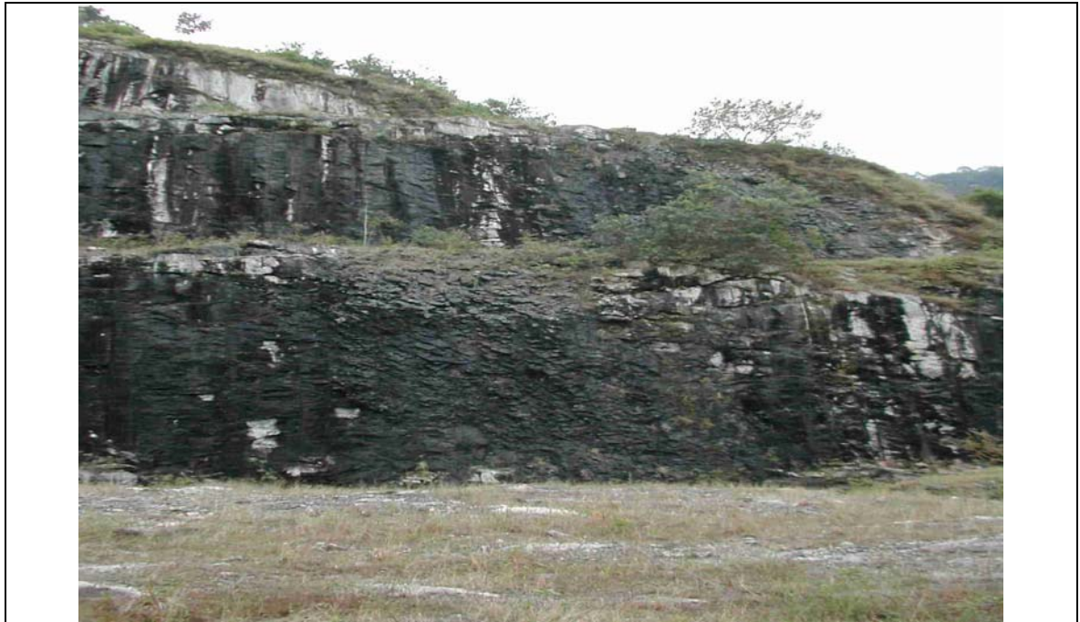
Figura 118 – Foliação gnaissica do maciço rochoso na área de construção de Angra 3.
