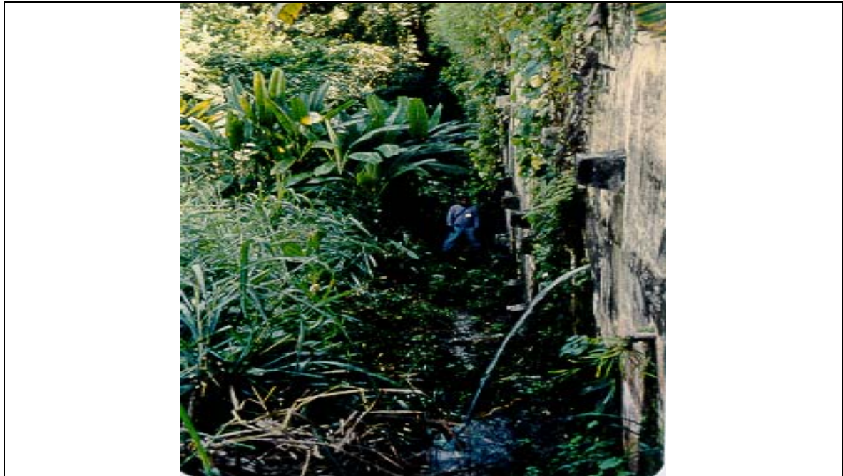
Figura 123 – Cortina em área de escorregamento antigo.
