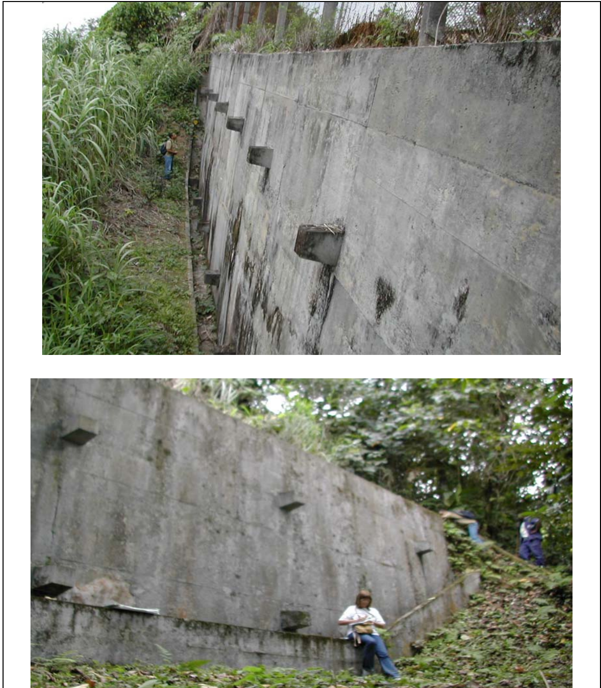
Figura 113 – Cortinas à jusante da estrada do Centro de Informações.
