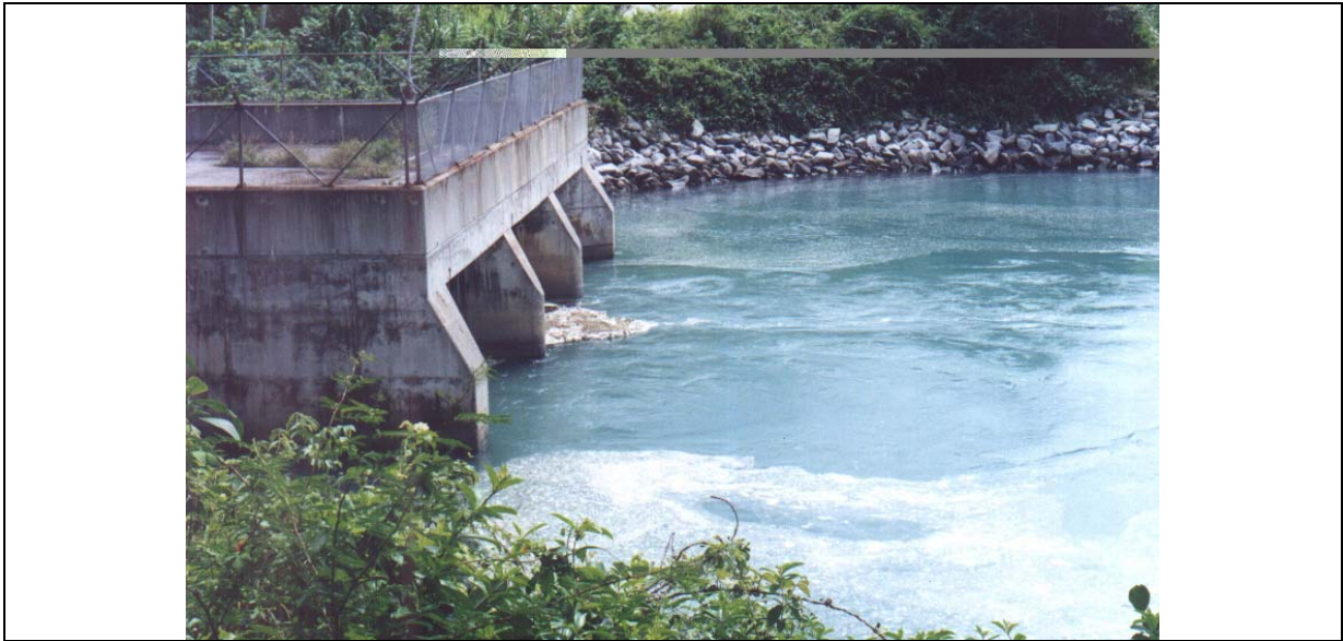
Figura 25 – Vista da estrutura de descarga da água de resfriamento das usinas da CNAAA, no Saco Piraquara de Fora.
