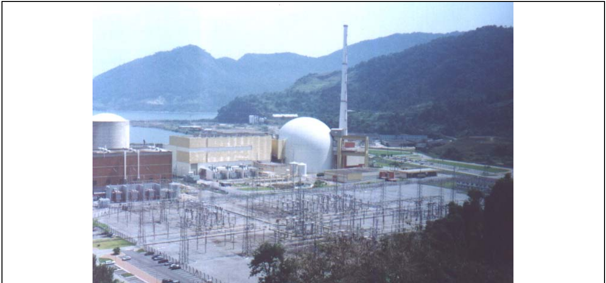
Figura 24 – Vista da subestação principal da CNAAA. Ao fundo as usinas de Angra 1 e 2.
