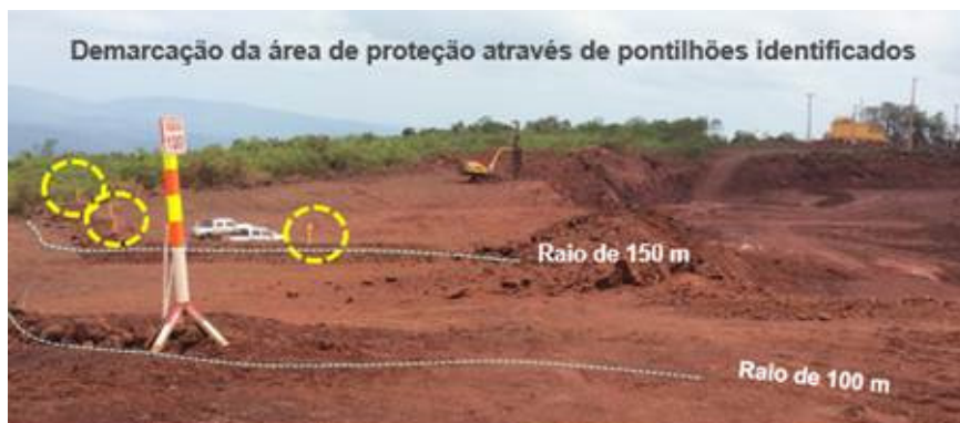
Sinalização de uma cavidade com impacto até 50m em área licenciada
