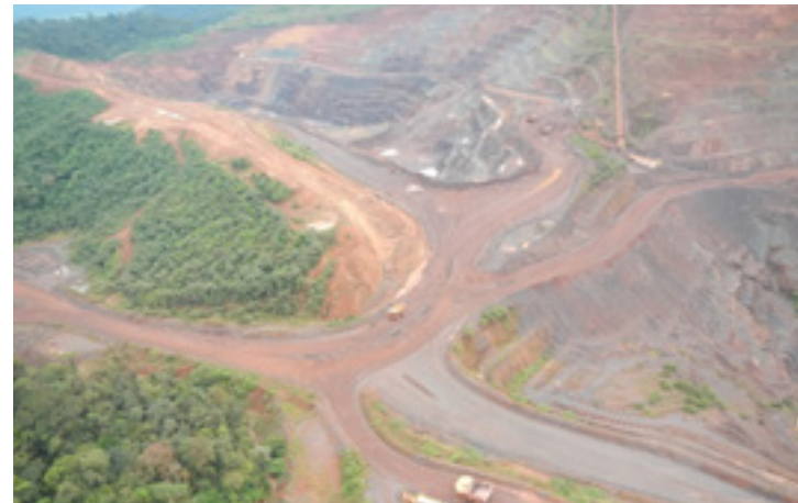
Encaixe de acessos operacionais nas áreas das minas Fonte: Arquivo Vale
