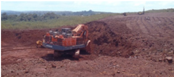
Terraplenagem e implantação de acesso Fonte: Arquivo Vale
