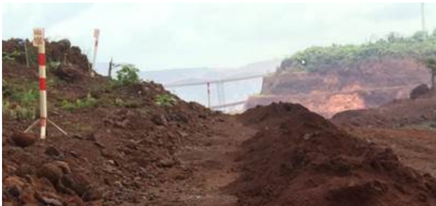
Sinalização das áreas de cavidades
