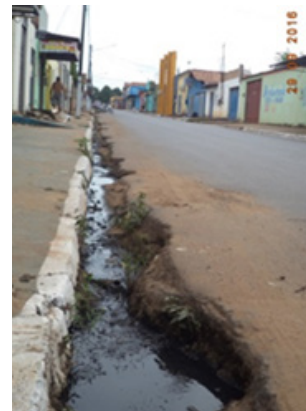
Esgoto à céu aberto correndo nas vias públicas.
