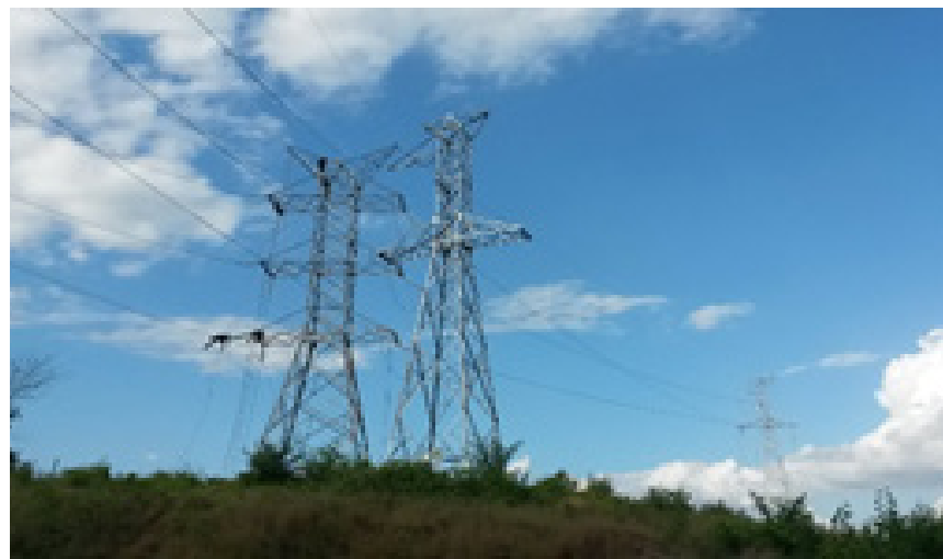
Atividades de implantação da Linha de Transmissão
