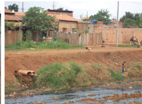
Lançamento de esgoto sem tratamento em poço de água.
