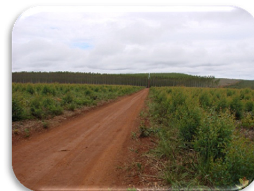
Área onde será implantada a usina de beneficiamento.
