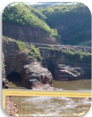
Vale do rio Jequitinhonha na área da Represa de Irapé, no trecho inicial da adutora.
