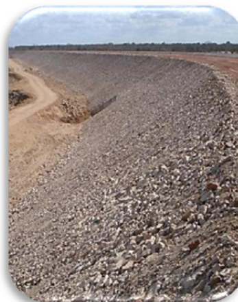
Exemplo de talude.
