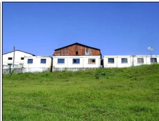
Foto 4 - Instalações para processamento de cacau, no bloco M4.
