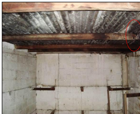
Foto 185 - Casa que servia de abrigo a G. soricina e A. caudifer no ponto 3 da área M3. No detalhe é possível observar um morcego glossófago voando.
