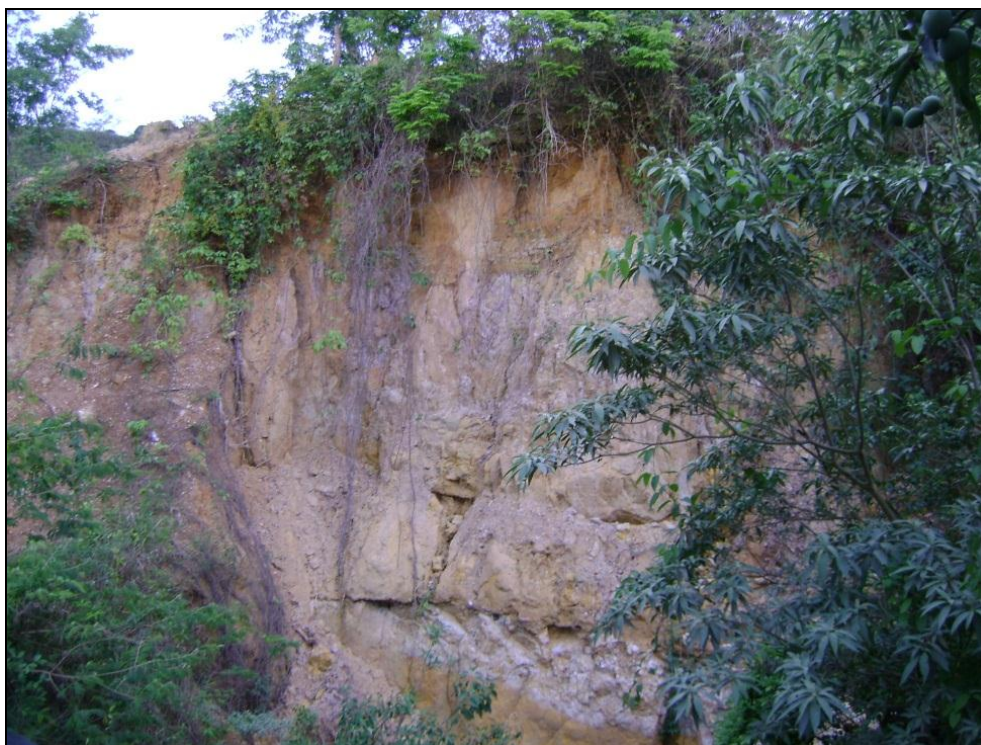
Foto 12 - Área com solo exposto e focos erosivos.
