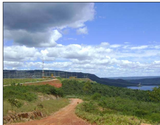
Foto 9 - Instalações da usina de Irapé
