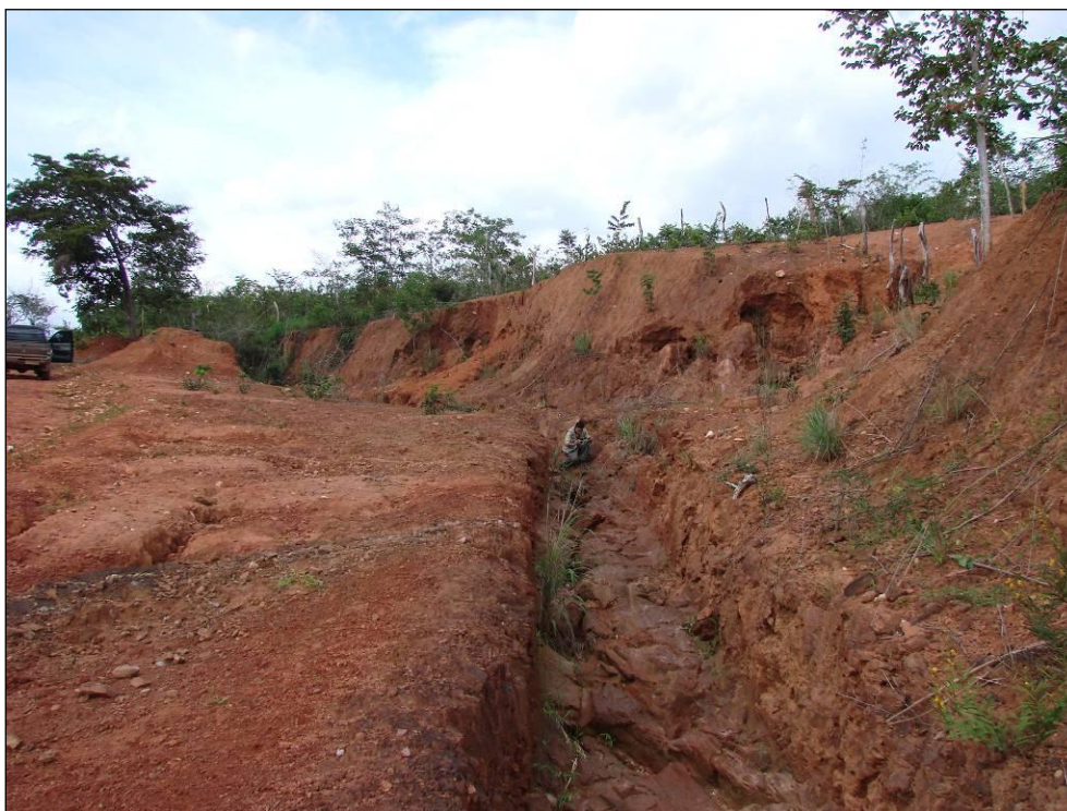
Foto 10.56 - Sulcos e ravinas provocados por abertura de estrada vicinal após o córrego bebedouro, no município de Novorizonte - 785.337E / 8.225.838N - 23K.
