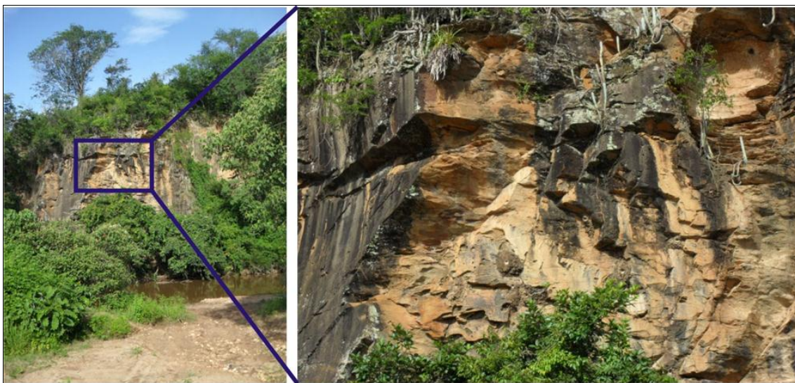
Foto 7.9 - Afloramento de quartzito da Formação Nova Aurora. À esquerda, visão geral do perfil de quartzito exposto às margens do rio Vacaria e, à direita, detalhes dos planos de fraturas e foliação.
