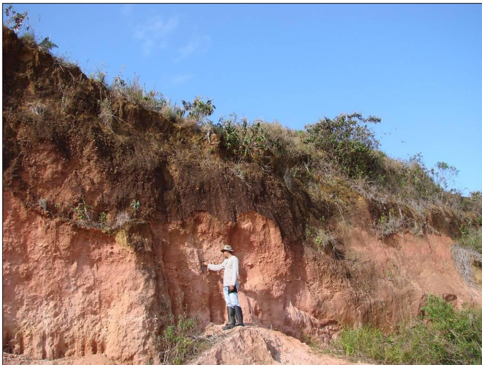
Foto 10.69 - Desmoronamento de talude em solo formado pela alteração do Grupo Barreiras, na sub-bacia do rio Tiriri, a oeste da estação de desaguamento - 486.052E / 8.374.191N - 24L.
