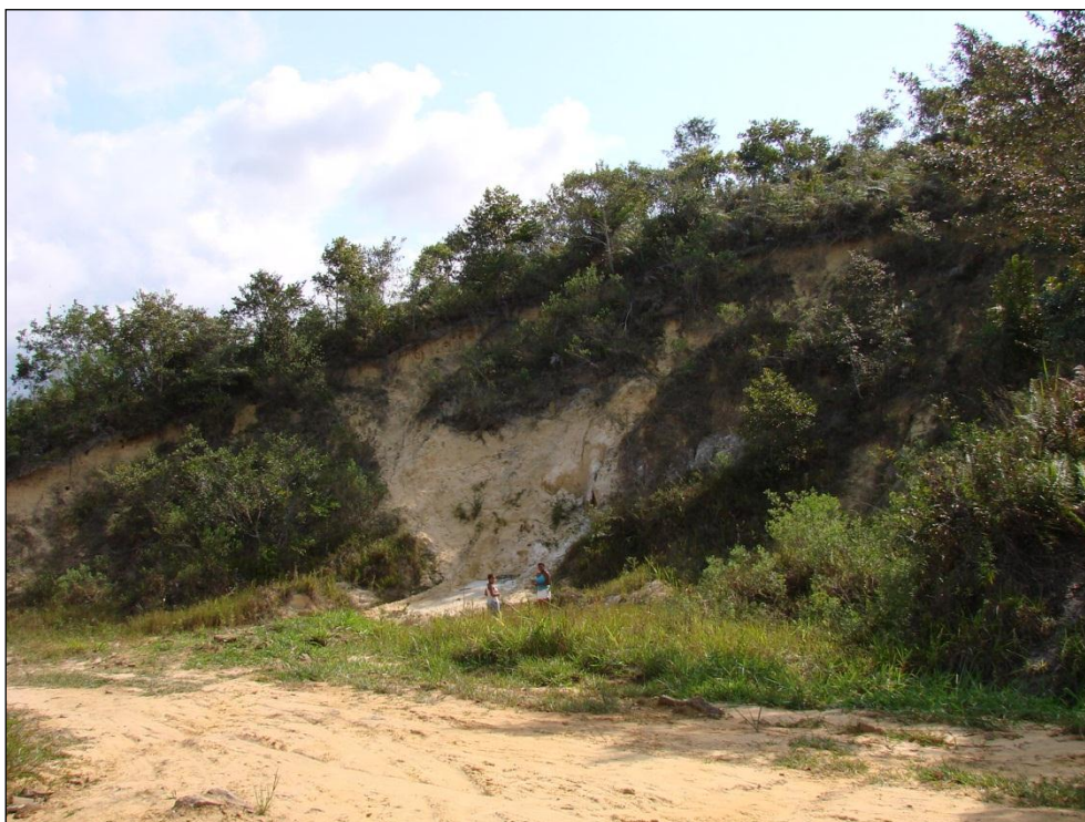
Foto 8.33 - Escorregamentos na encosta dos relevos tabuliformes. Fragilidade do terreno provavelmente facilitada pela abertura da estrada.
