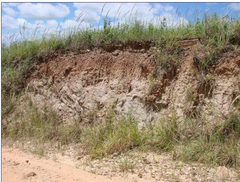
Foto 10.66 - Deslizamento em estrada vicinal em Itapetinga.
