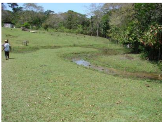
Foto 12.37 - Canais de drenagem de fundo chato colmatado e com trechos sinuosos.
