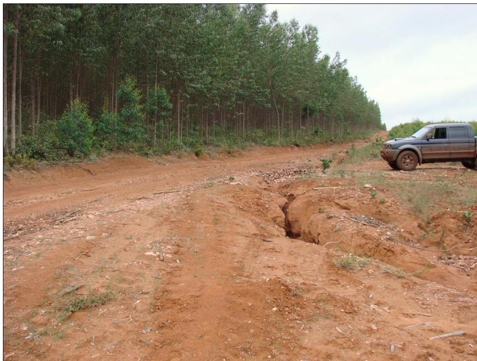
Foto 10.2 - Sulco instalado imediatamente a jusante do traçado do Mineroduto, ainda dentro da área do futuro Complexo Minerário (737.809/8.201.585 - 23K).
