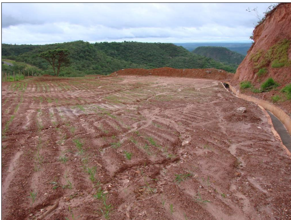
Foto 10.55 - Estrada de Fruta de Leite, mostrando superfície desnuda na área de servidão da estrada, com presença de sulcos - 760.174E / 8.211.888N - 23K.
