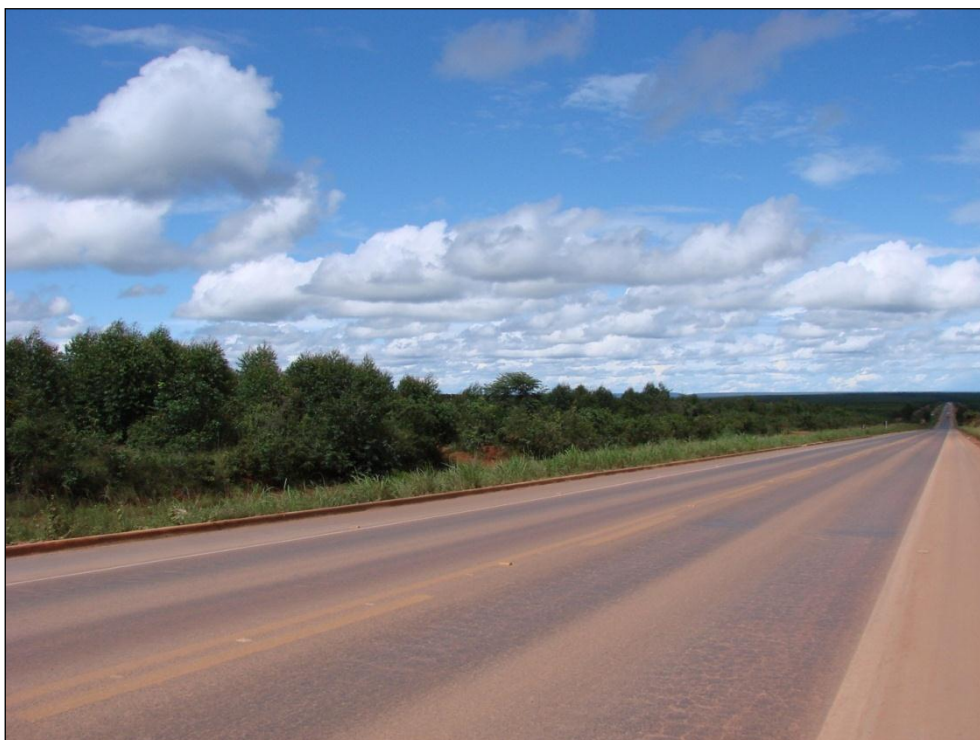
Foto 12.2 - Segmento no qual o mineroduto passa junto aos divisores de águas locais, sobre platôs, às margens da BR-251.
