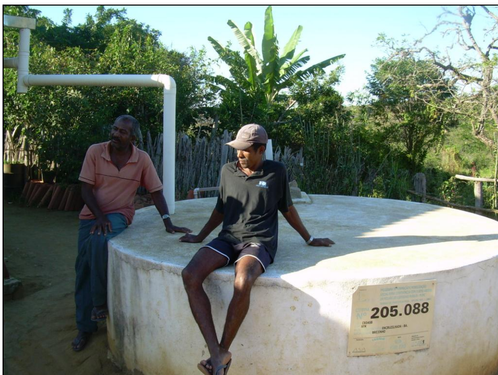
Foto 9 - Cisterna construída recentemente na casa de Sr. Nelson Oliveira. A instalação das cisternas proporcionou melhorias na qualidade de vida da população de Brejinho, que até então buscava água no rio Pardo, distante sete quilômetros.
