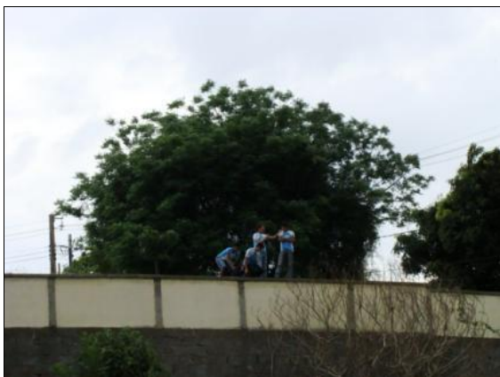
Foto 5.17 - Vista parcial do muro de uma das escolas do município.
