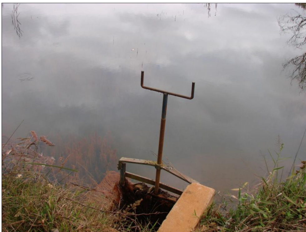
Foto 9.6 - Captação de água direta em curso d'água - Salinas.
