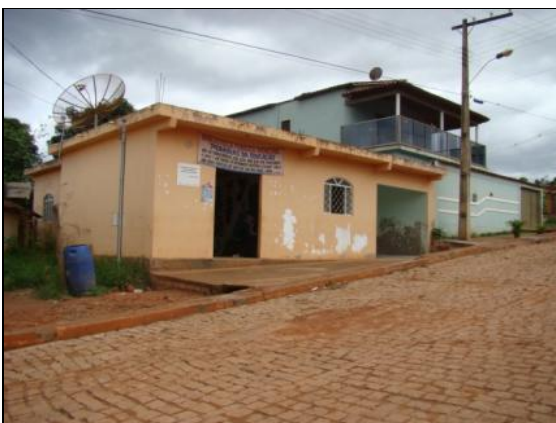
Foto 5.30 - Edificação onde funciona, provisoriamente, a biblioteca do município.
