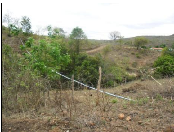
Foto 6.6 - Cano de distribuição de água para irrigação em São Francisco.
