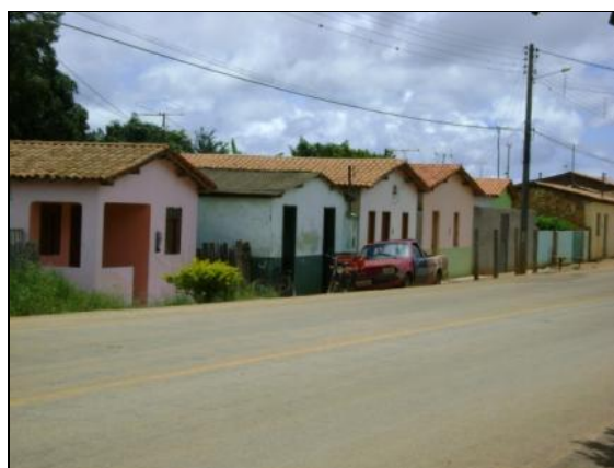
Foto 5.36 - Padrão construtivo das edificações
