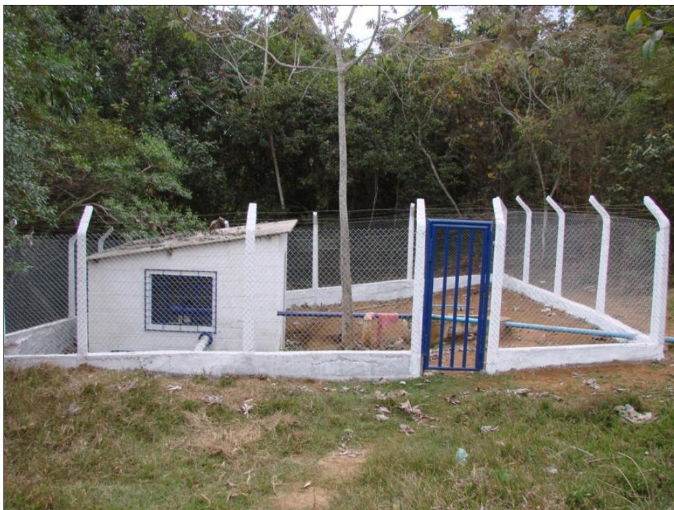
Foto 9.5 - Maquinário para captação de água no córrego Batalha
