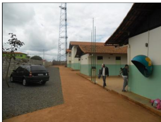
Foto 8.15 - Entrada da escola, detalhe para o telefone público à direita e o estacionamento para carros.
