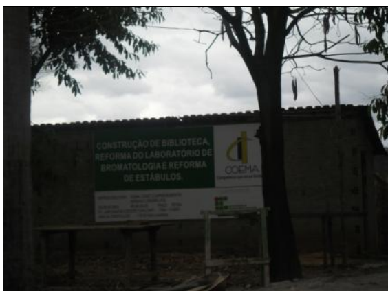
Foto 8.20 - Construção da Biblioteca e reforma do Laboratório de Bromatologia e estâbulos.
