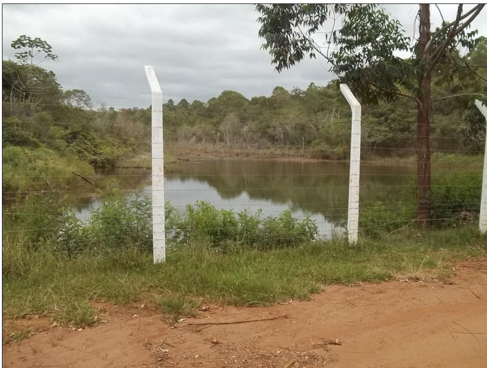
Foto 6.1 - Córrego Batalha - barragem que serve para captação de água para o Vale das Cancelas
