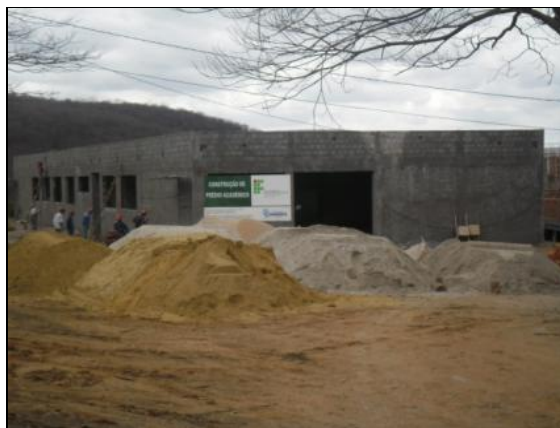
Foto 8.21 - Construção do pavilhão de aulas.
