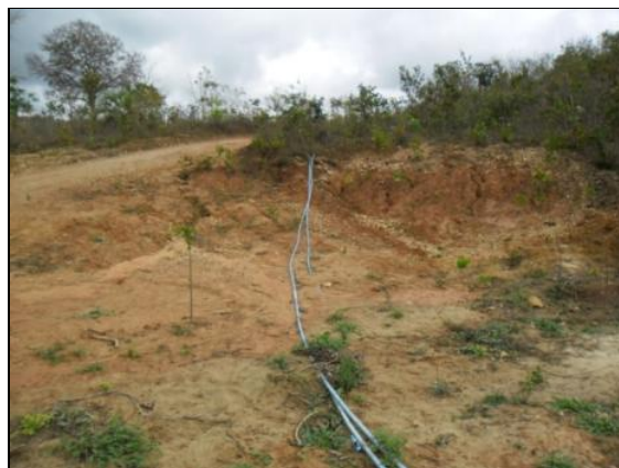
Foto 6.4 - Cano de distribuição de água para abastecimento da comunidade: Córrego Lamarão.
