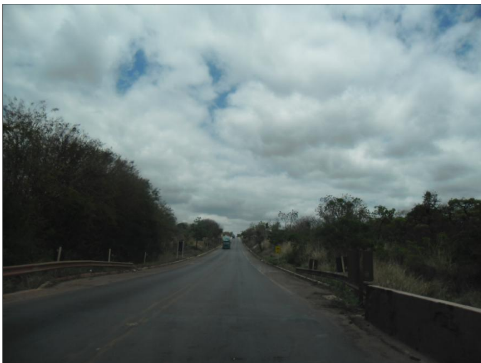
Foto 9.1 - Rodovia BR251 próximo ao Vale das Cancelas
