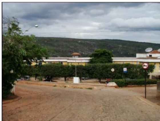
Foto 5.14 - Ao fundo, prédio do Hospital de Grão Mogol.
