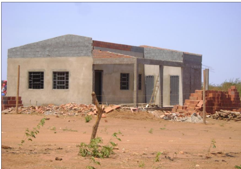
Foto 10.11 - Obra do posto Policial em construção no Vale das Cancelas
