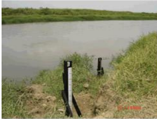
Figura 3: Estação de Réguas Linimétricas.
