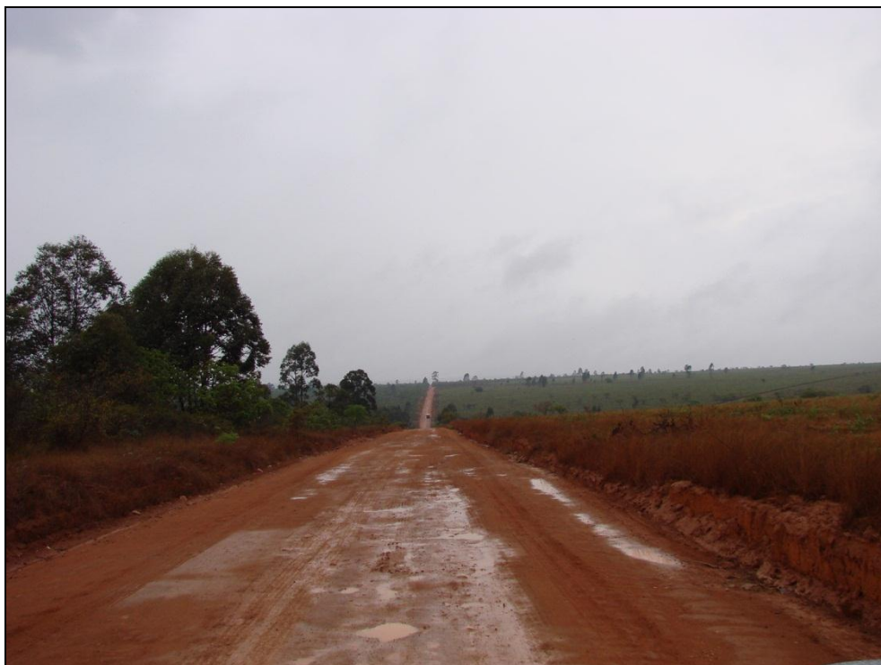
Foto 8.37 - Estrada que segue em direção à cidade de Josenópolis e a represa de Irapé, ponto onde a adutora passará à direita (oeste). Notar pequeno declive do terreno ao fundo.
