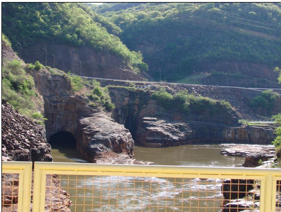
Foto 8.47 - Vale do rio Jequitinhonha na área da Represa de Irapé, no trecho inicial da adutora. O encaixe do rio Jequitinhonha é incisivo na área.
