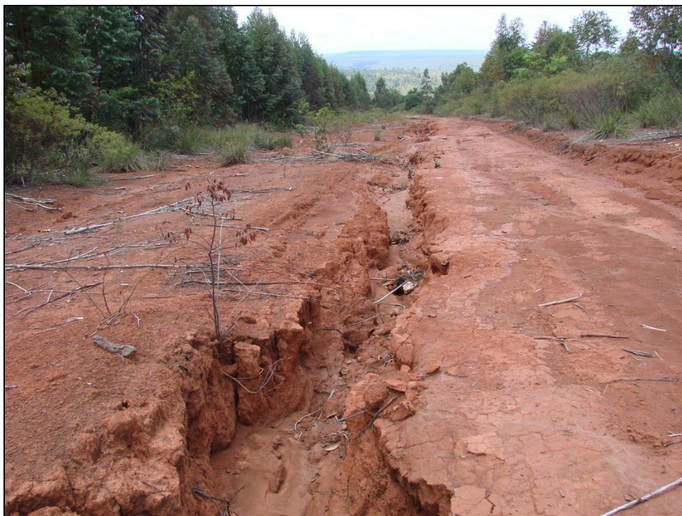
Foto 8.45 - Ravina em estrada que limita eucaliptal, aproximadamente no meio do trecho do traçado.
