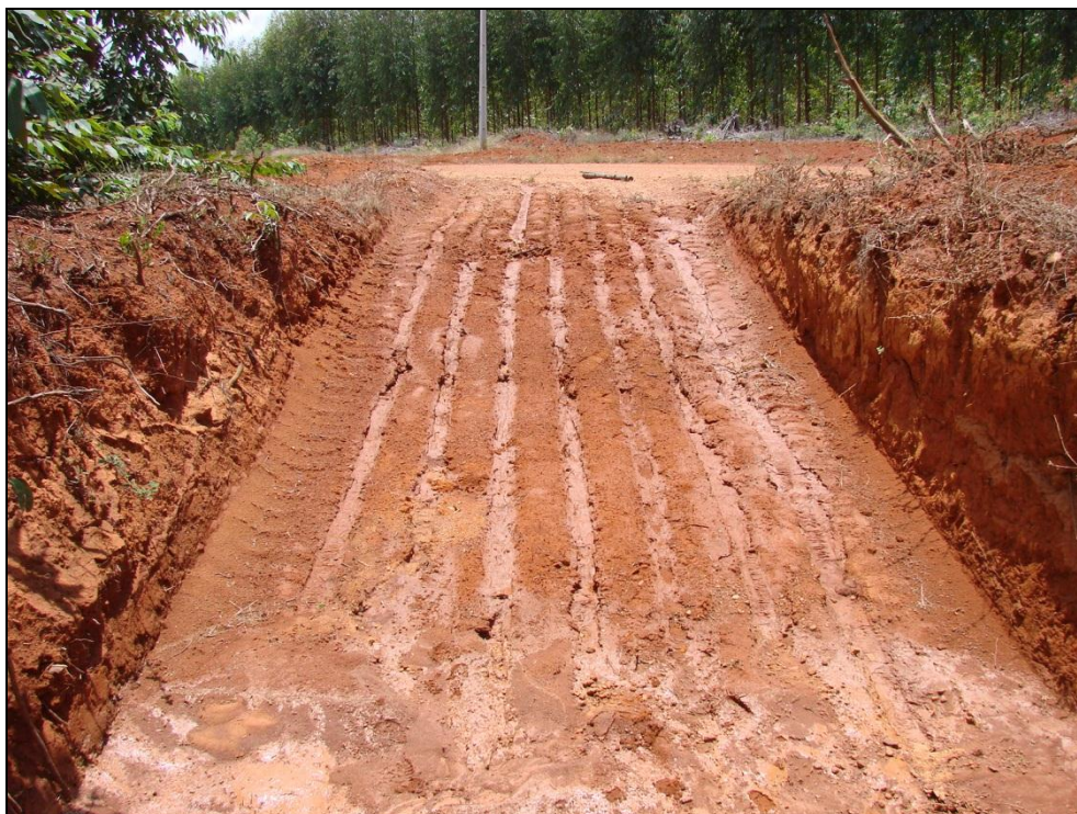
Foto 8.44 - Bacia para contenção do fluxo da água das chuvas, numa gleba onde é realizado o plantio de eucalipto.
