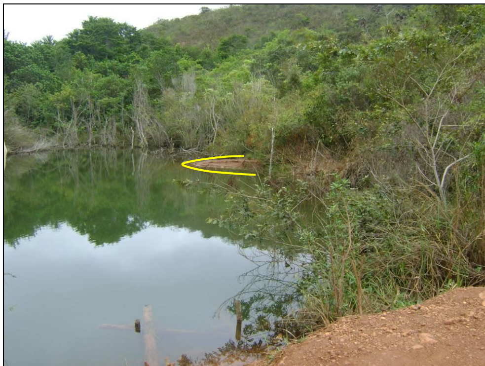
Foto 10.24 - Área assoreada na barragem situada na cabeceira do córrego Mundo Novo, local da futura barragem de rejeitos (738.742/8.203.635)
