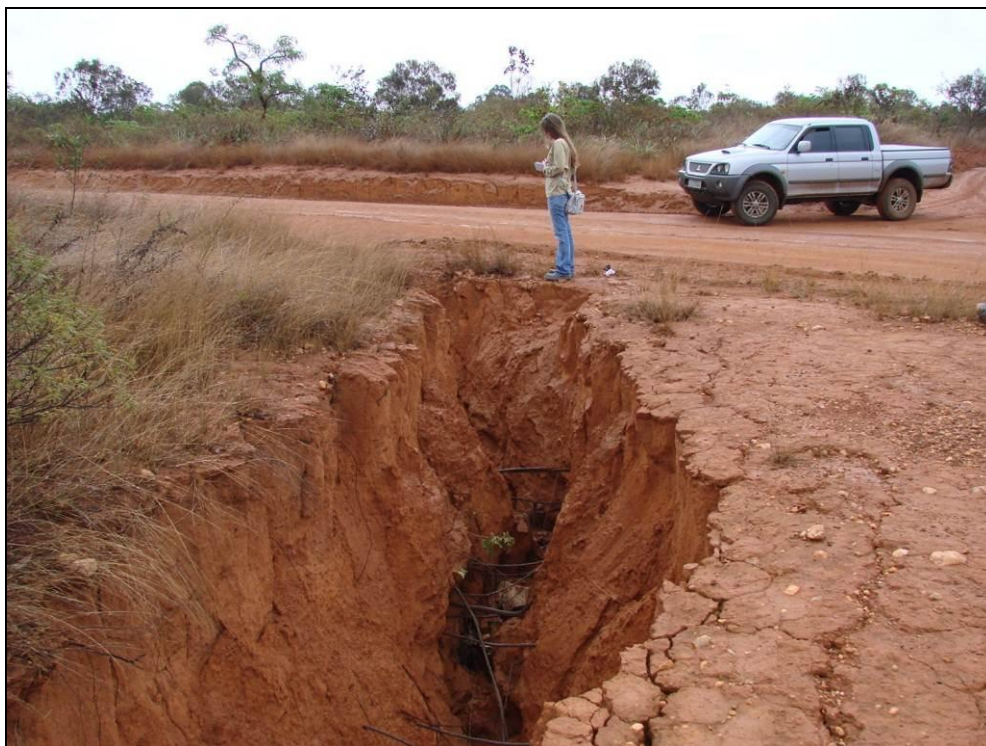
Foto 10.38 - Ravina evoluindo para voçoroca próxima a faixa de servidão da adutora, desenvolvida sobre Latossolo Vermelho-amarelo.
