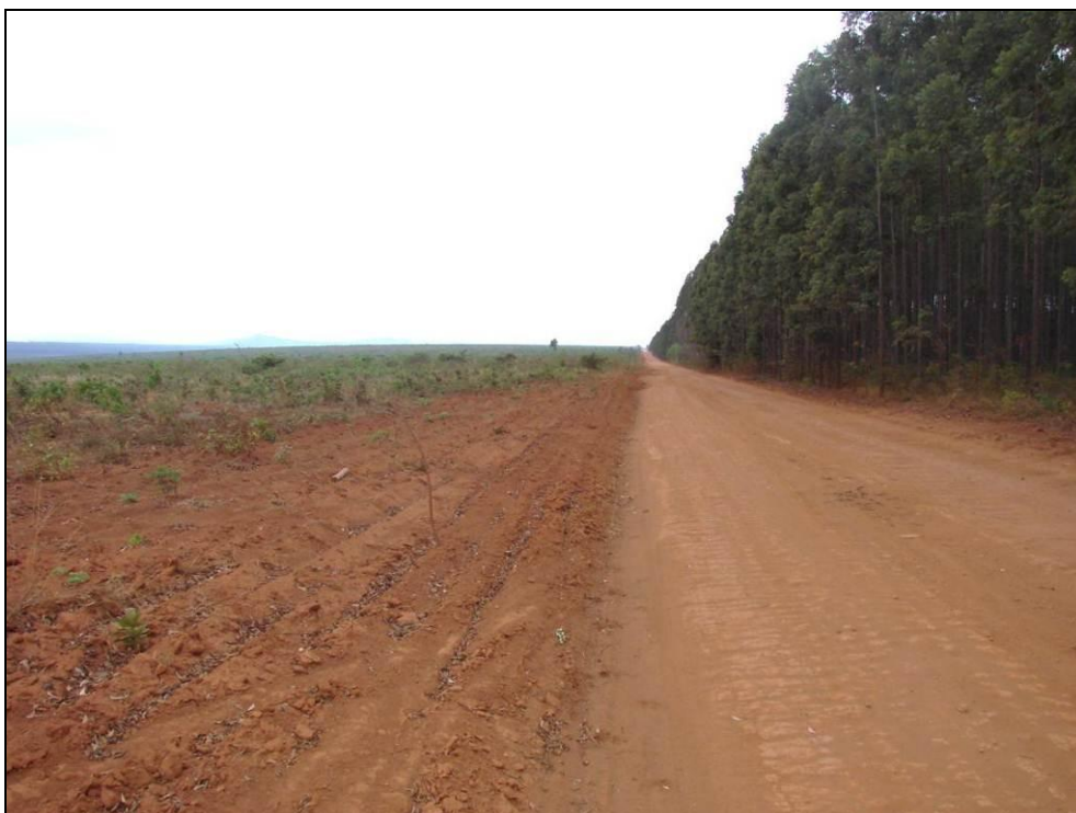
Foto 12.45 - Estrada que servirá de acesso principal ao complexo minerário, situada nas cercanias do divisor de águas.
