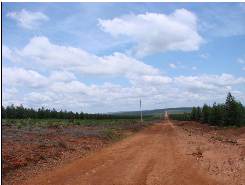
Foto 8.35 - Topo de extenso platô por onde a adutora seguirá em seu médio percurso. Vista de norte para sul, aproximadamente.
