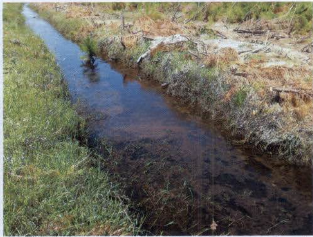
Figura 20. Detalhe de um canal de drenagem na área da FLOPAL.
