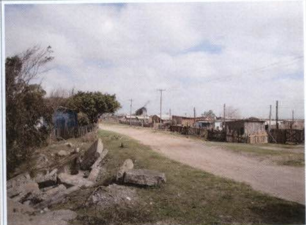
Figura 06: Ocupação desordenada nas proximidades da área do traçado do mineroduto.
