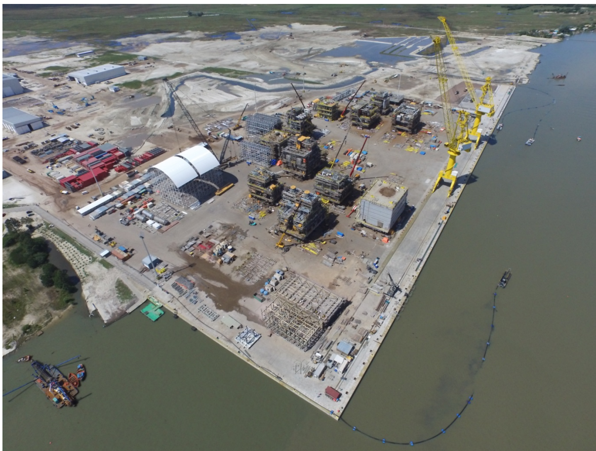
Figura 5.6 - Estaleiro EBR em São José do Norte - 2015
