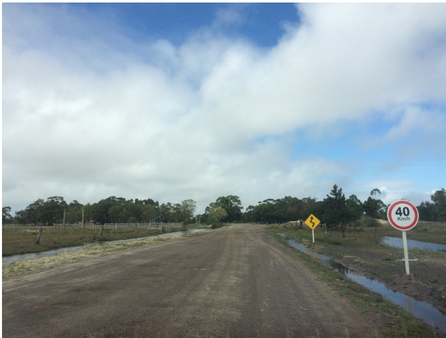
Figura 5.3 – Avenida Perimetral – Foto: 2015
