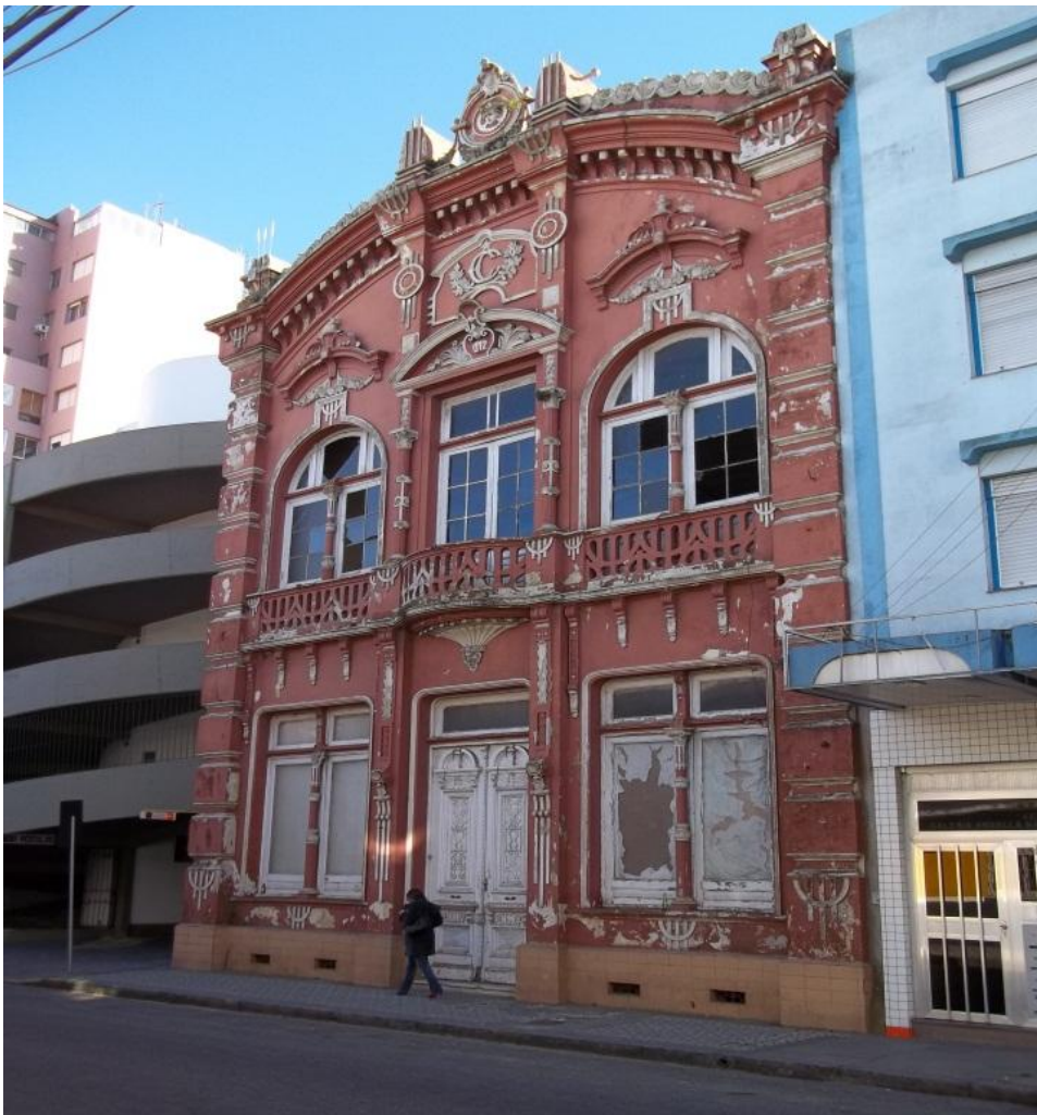
FIGURA 6.4.3.2.1-4. Sobrado de Macega
