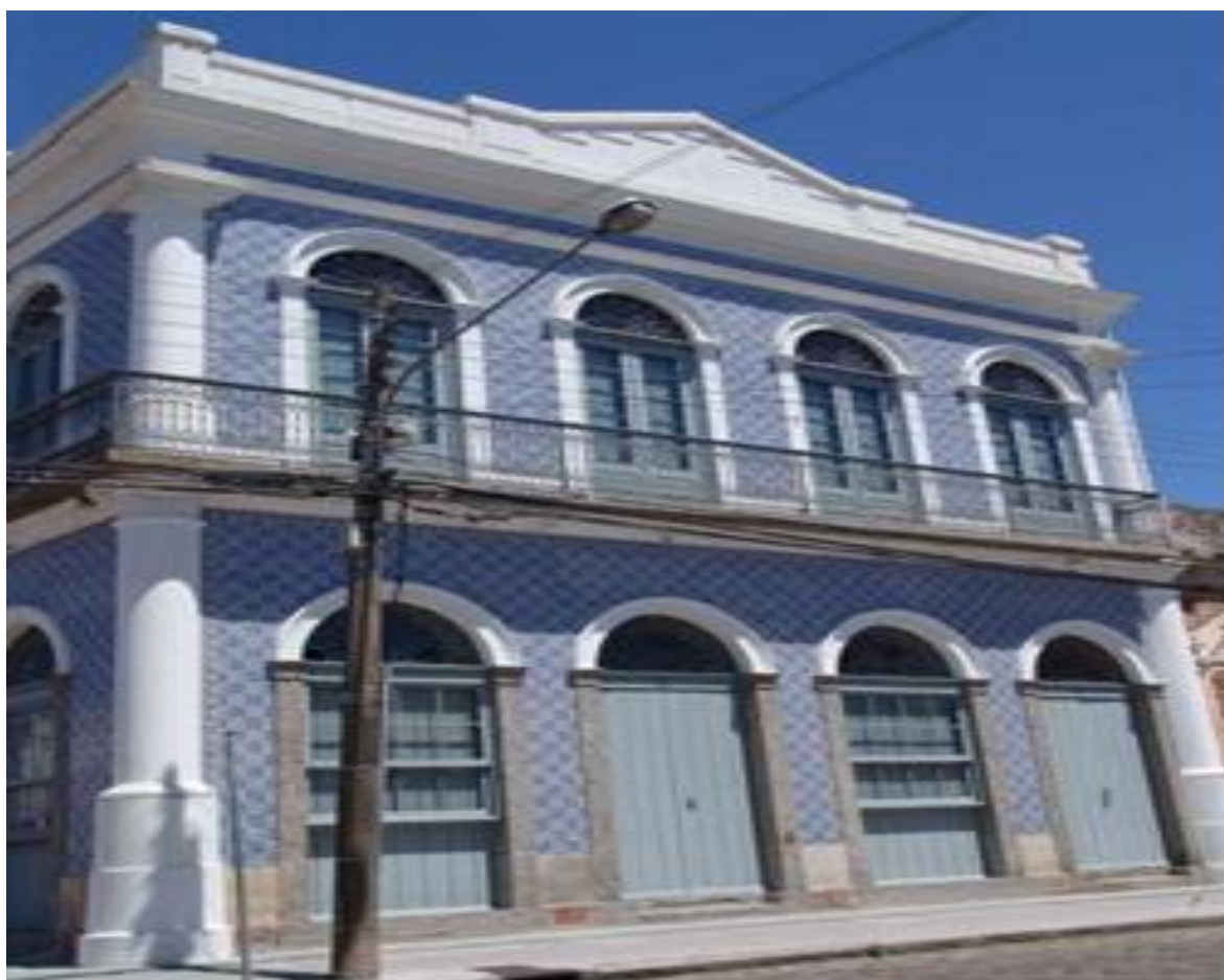
FIGURA 6.4.3.2.1-2. Sobrado dos Azulejos
