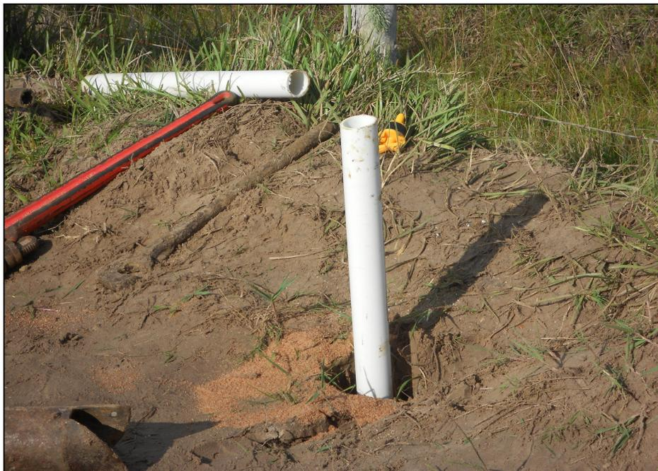
Figura 2- Instalação do tubo geomecânico.
