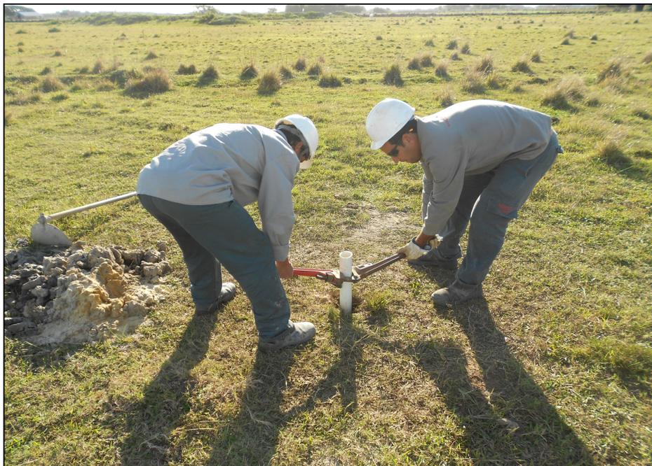
Figura 12 - Desmobilização dos poços de monitoramento provisórios.
