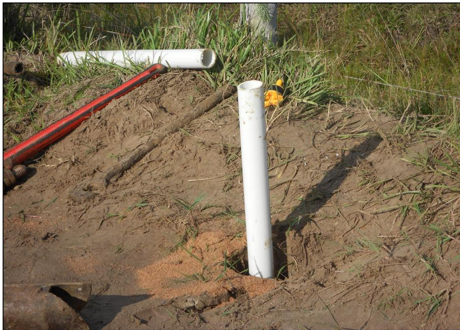
Figura 2- Instalação do tubo geomecânico.
