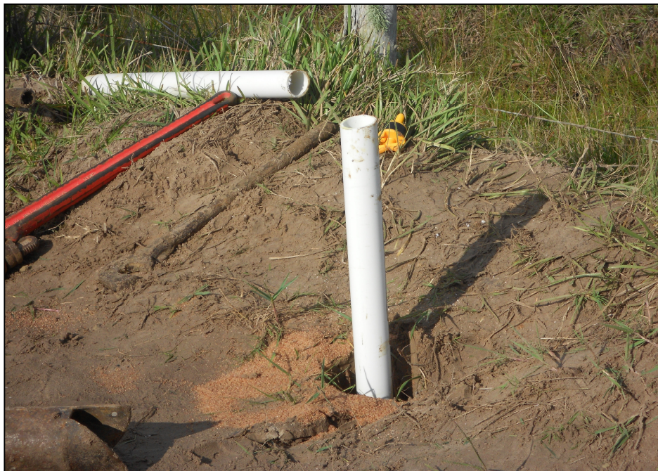
Figura 2- Instalação do tubo geomecânico.
