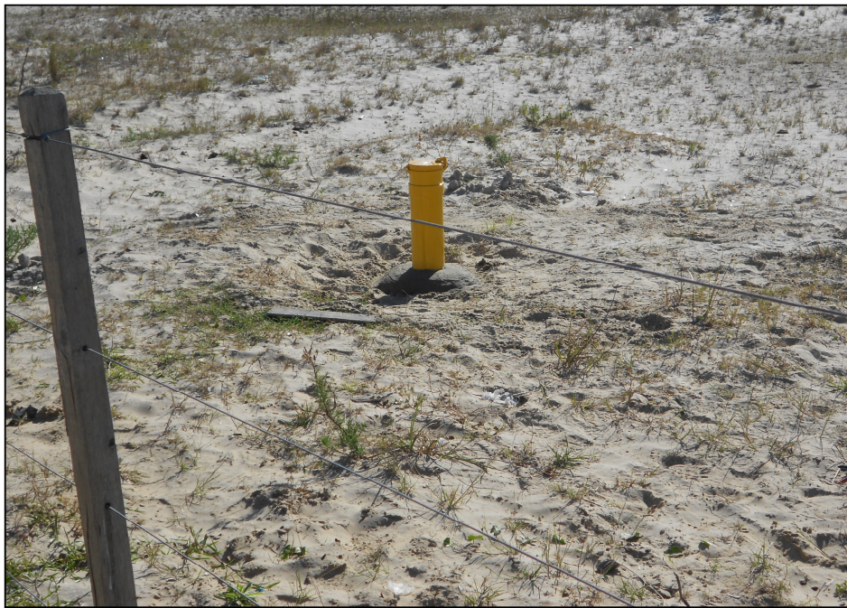
Figura 3 - Poço de monitoramento finalizado.
