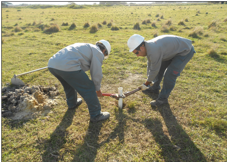
Figura 12 - Desmobilização dos poços de monitoramento provisórios.
