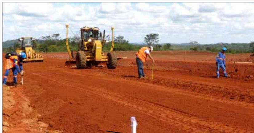
O nível do terreno é medido com estacas no método convencional de terraplanagem
