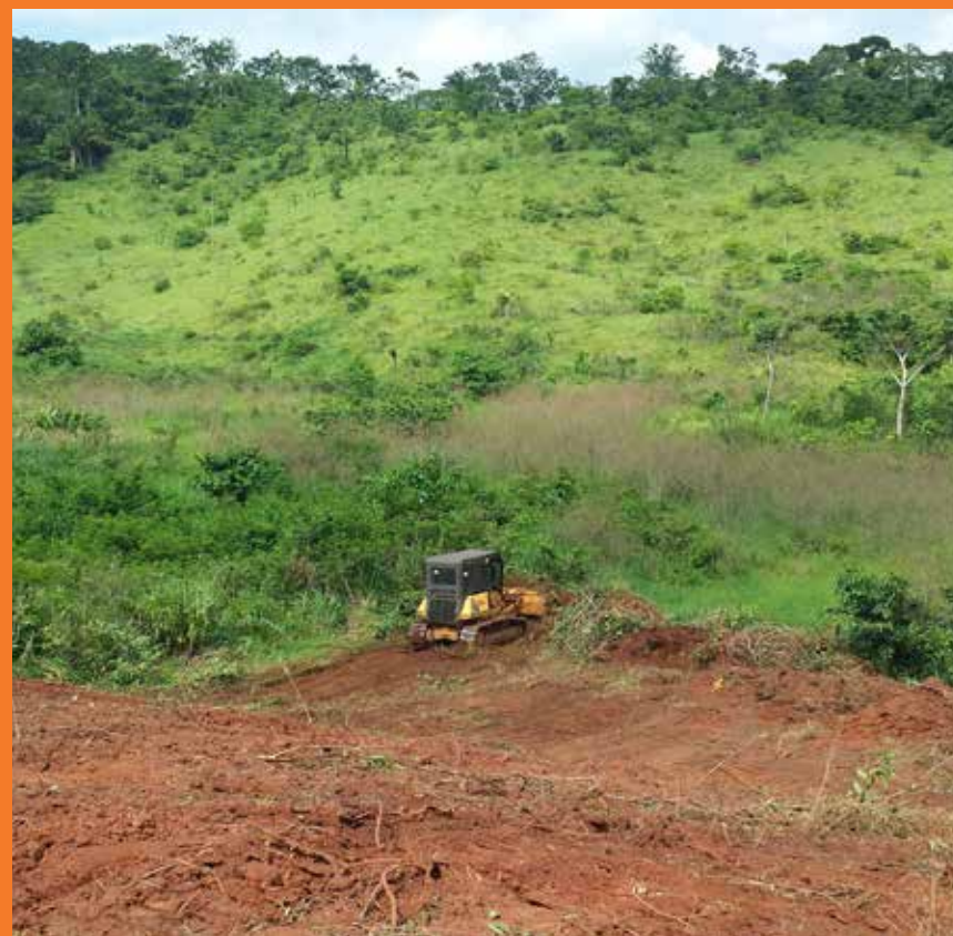
Máquinas fazem a retirada da camada mais superficial do solo
