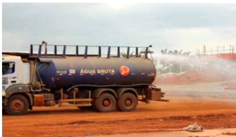
Água e resíduo são reaproveitados nas obras da Usina
