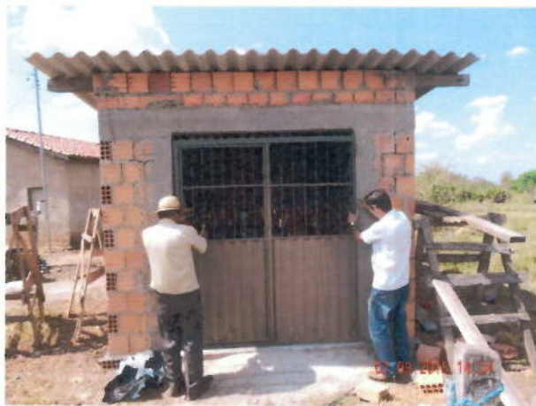
Foto 05: Finalização do Abrigo – PA Carajás 2
