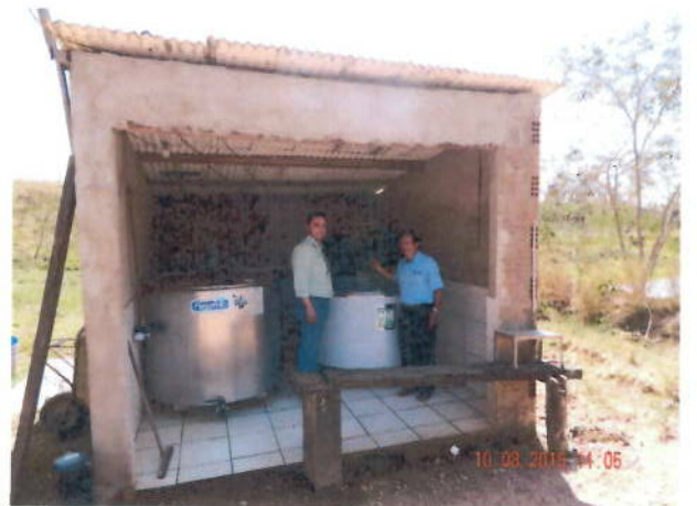
Foto 04: Substituição dos Tanques de Resfriamento – PA Carajás 2
