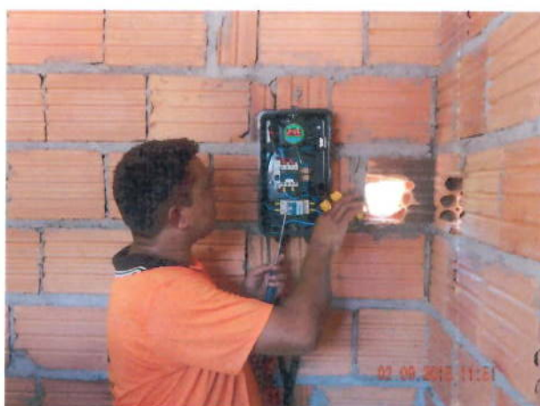
Foto 08: Instalação do tanque – PA Carajás 2
