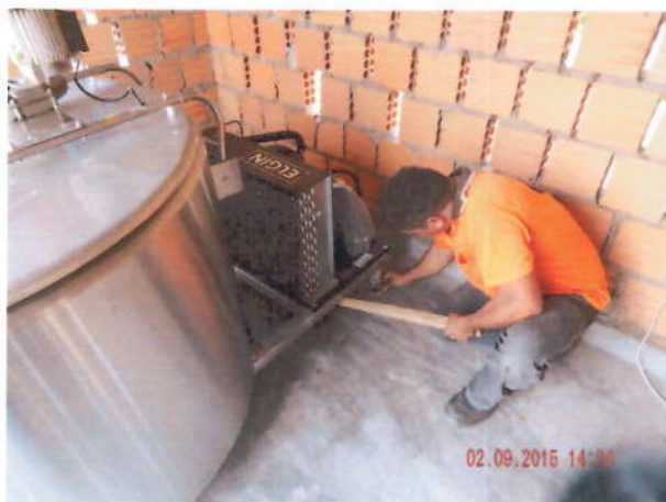
Foto 07: Instalação do tanque – PA Carajás 2
