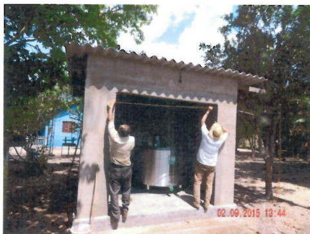
Foto 06: Finalização do Abrigo – PA Carajás 2
