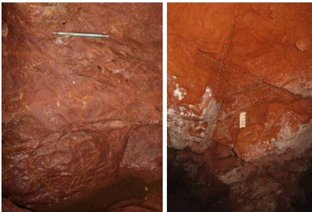
Figura 45. Conjunto de fraturas com frentes de maior alteração em rocha máfica saprolítica; à esquerda, na caverna CAV-35 (linhas mais amareladas); à direita, planos de fratura (linhas pontilhadas) na caverna S11D-47.
