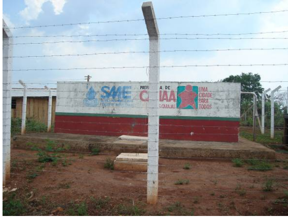
FOTO 01 – Ponto MU-35- reservatório de água –1ª campanha.
