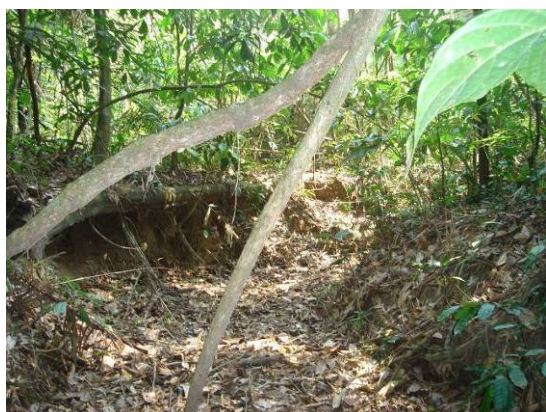
FOTO 03 – Drenagem seca - jusante– 1ª campanha.
