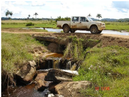
FOTO 03 – Ponte sobre o rio sossego- a montante represamento da água – período chuvoso.
