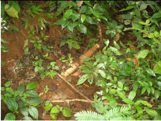
FOTO 05- canalização doada pela Vale.
