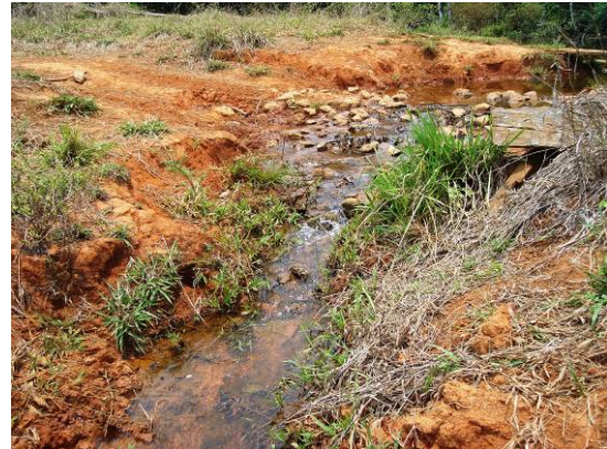
FOTO 04 – Drenagem - jusante– 2ª campanha.
