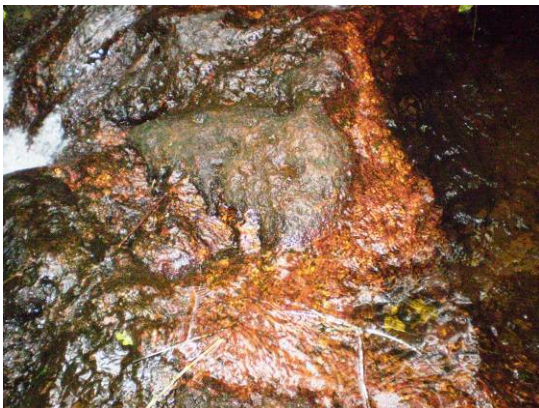
FOTO 05– Leito de drenagem - 2ª campanha.
