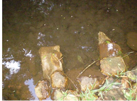
FOTO 11- Canos com tela de proteção.
