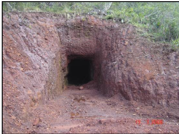
FOTO 6.1.5.40 – Boca da galeria de pesquisa, escavada em formação ferrífera laterizada (canga)
