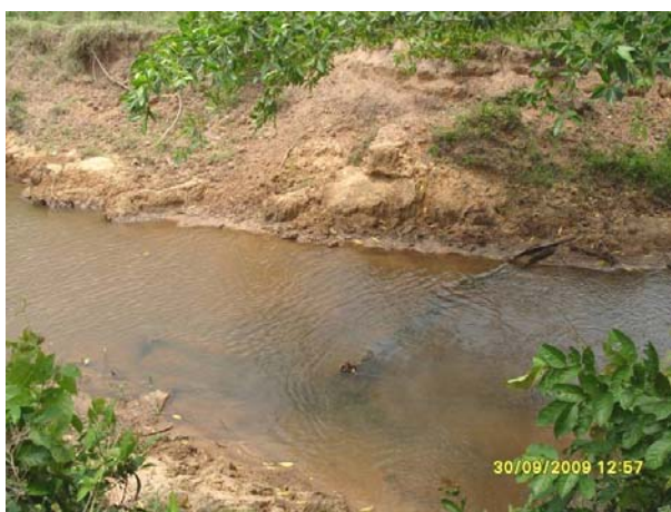
FOTO 6.1.8.113 - Detalhe do igarapé Pacu, com destaque para erosão da calha em segmento de solo arenoso.
