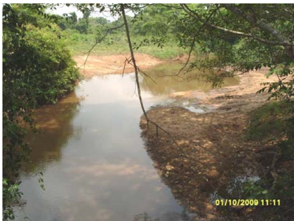
FOTO 6.1.8.114 - Detalhe do igarapé Pacu, em seu baixo curso, com destaque para a formação de bancos de assoreamento, causada pela redução de velocidade junto à aproximação de travessia sob ponte rodoviária. Notar presença de carga de material sólido em suspensão.
