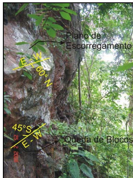
FOTO 6.1.5.48 – Escarpa da formação Carajás com planos de fraturas onde houve escorregamento planar (Fr 9 - EW/60°N) e destacamento de bloco (Fr 10 - EW/45°S) que formam provavelmente formam par associado devido ao sistema imbricado de deformação (E=580.471 / N=9.288.247)
