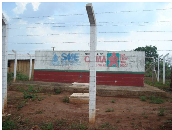
FOTO 6.1.8.121 - Reservatório de Água de Mozartinópolis.
