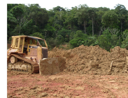
EXEMPLO DE REMOÇÃO DE SOLO, GERANDO ÁREAS DE SOLO EXPOSTO
