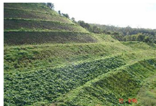
EXEMPLO DE TALUDE (CORTE E ATERRO) RECUPERADO COM VEGETAÇÃO E DISPOSITIVOS DE DRENAGEM PLUVIAL EVITANDO EROSÃO E POEIRA
