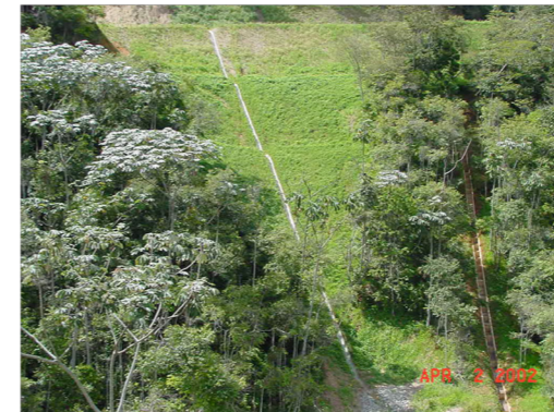
EXEMPLO DE CALHA IMPLANTADA PARA ADEQUAÇÃO DE DRENAGEM
