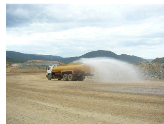
EXEMPLO DE UMECTAÇÃO DE ESTRADAS DE TERRA DIMINUINDO A POEIRA
