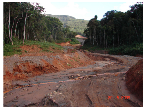
EXEMPLO DE ÁREA ERODIDA PELA CONCENTRAÇÃO DE ÁGUAS DE CHUVAS
