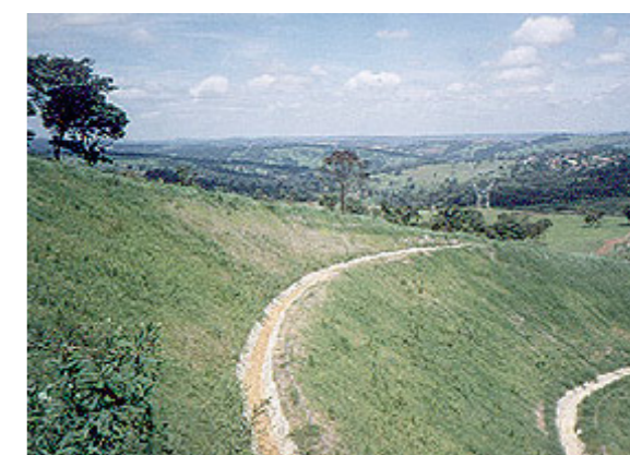
EXEMPLO DE TALUDE (CORTE E ATERRO) RECUPERADO COM VEGETAÇÃO EVITANDO EROSÃO E POEIRA
