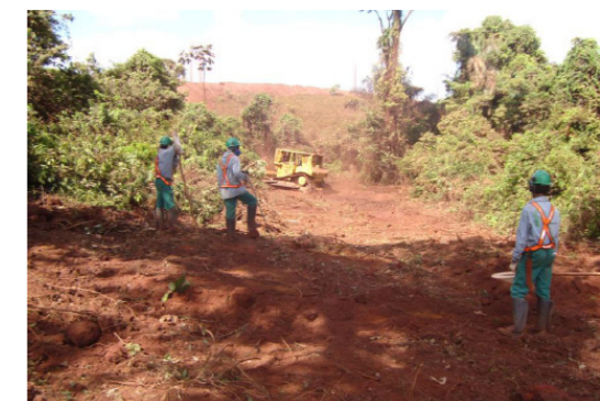
EXEMPLO DE RETIRADA DA COBERTURA VEGETAL E REMOÇÃO DE SOLO
