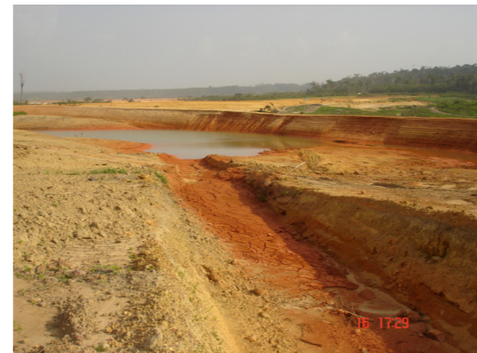
EXEMPLO DE DIQUE DE CONTENÇÃO DE SEDIMENTOS
