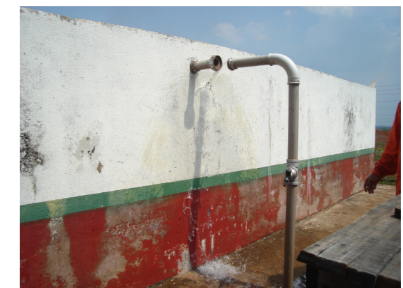
CAIXA DE ÁGUA – VILA MOZARTINÓPOLIS
