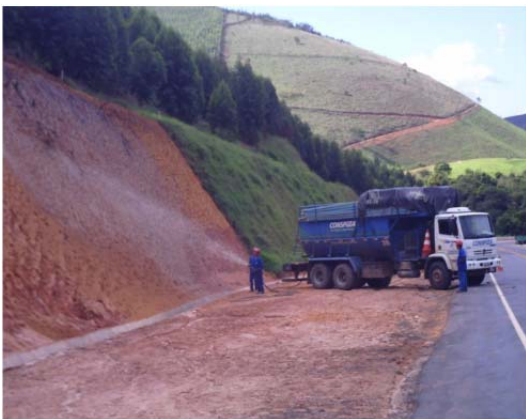
Foto 03 Exemplo de hidrossemeadura em talude
