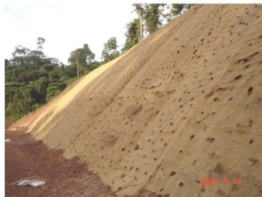
Foto 07 Exemplo da utilização de tela vegetal em talude de corte
