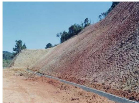
Foto 04 Exemplo de semeadura manual em talude
