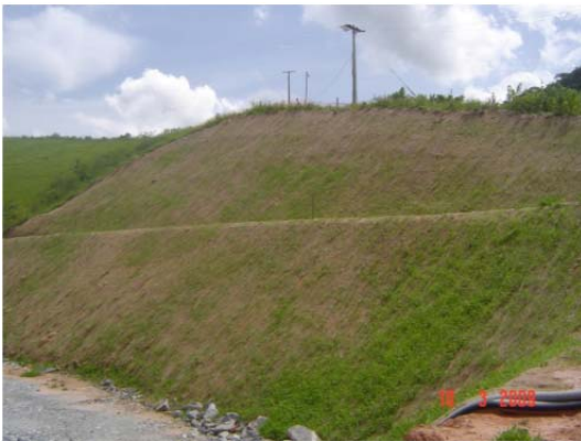
Foto 06 Exemplo da utilização de tela vegetal em talude de corte
