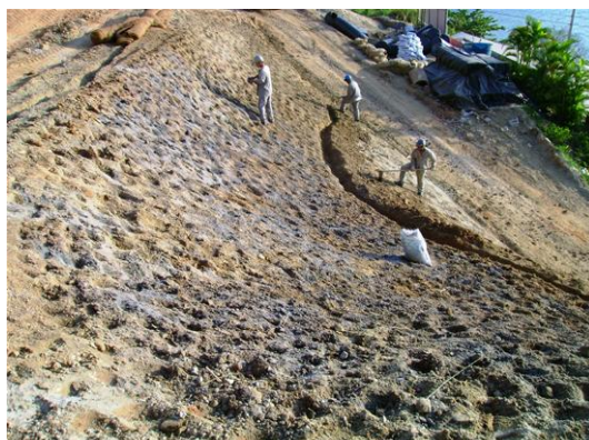
Foto 05 Exemplo de abertura de covas para plantios em taludes
