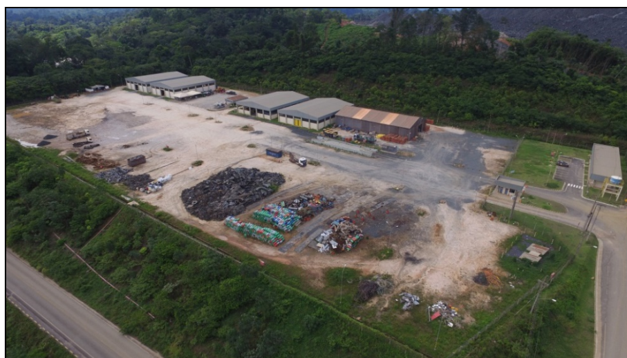
Figura 04 Central de Materiais Descartáveis - CMD do CMS
