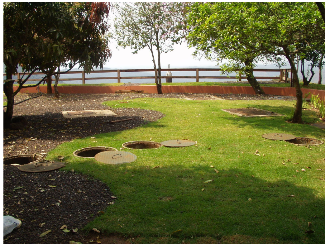
ETE – Vistal Geral
