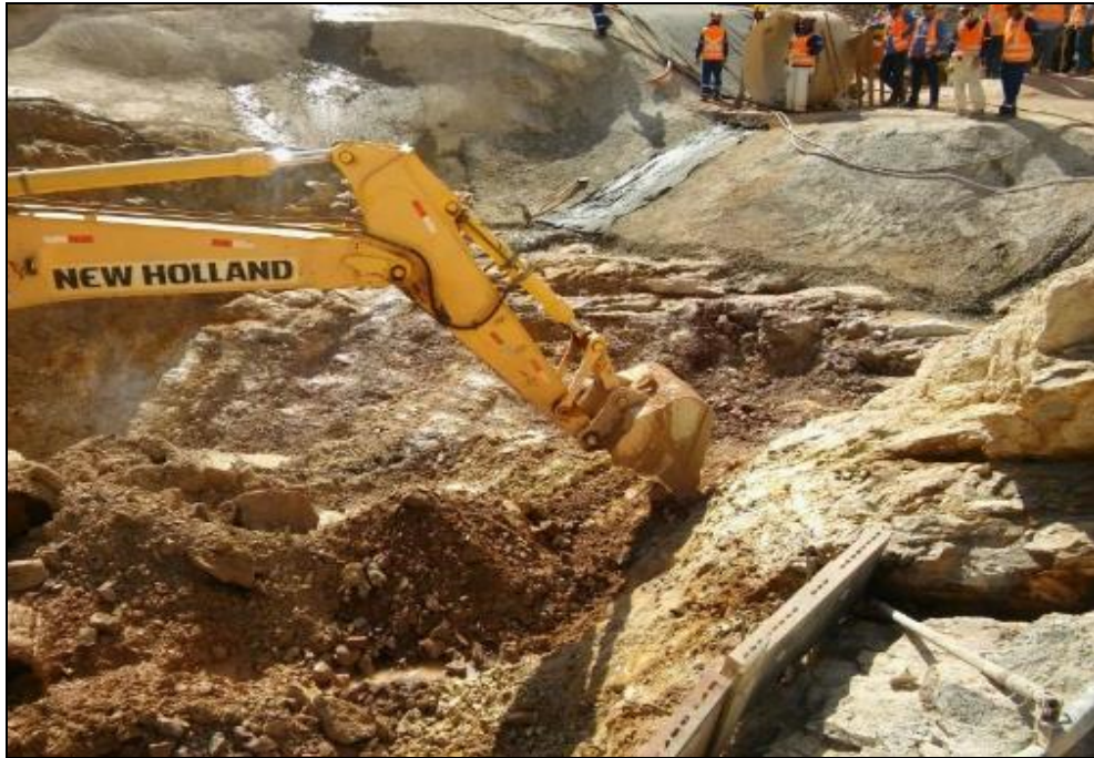
Foto 7-23: Remoção de material de baixa resistência na fundação do núcleo argiloso
