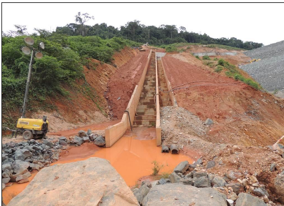
Foto 6-15: Vista frontal da descida d'água, com parte do reaterro lateral executado
