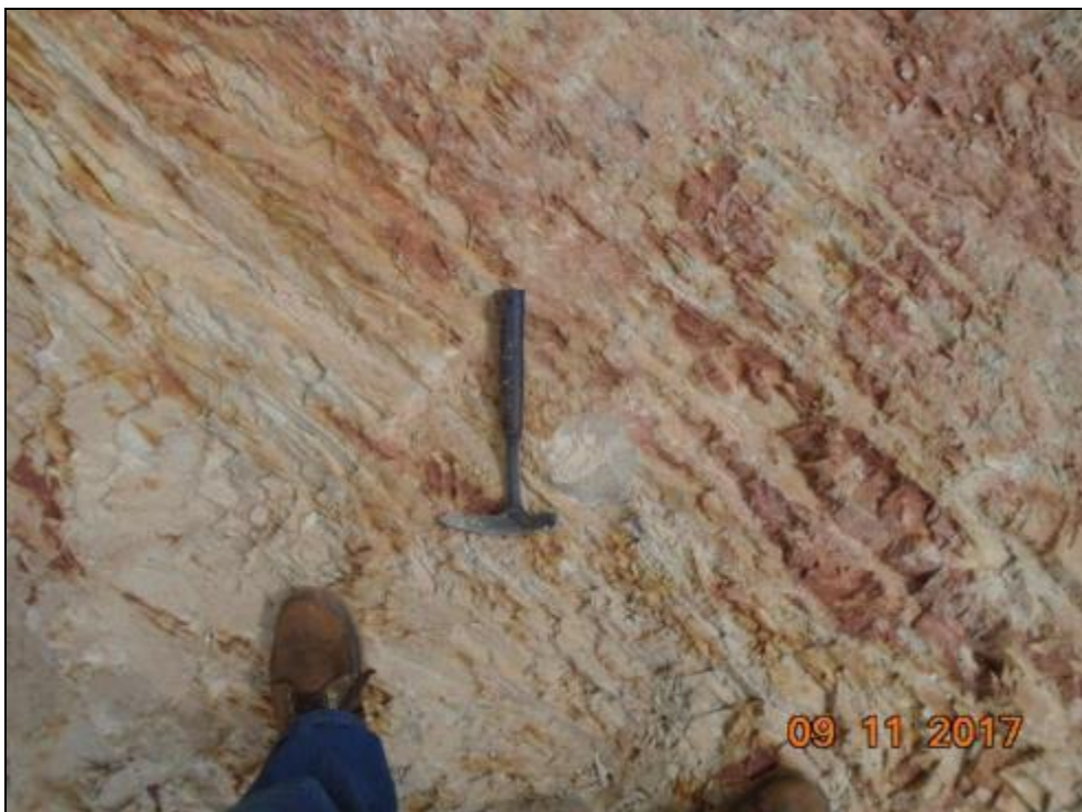
Foto 7-17: Detalhe do quartzito medianamente resistente (A3, R3) da região do núcleo da barragem. Ao lado do martelo furo preenchido com calda de cimento após injeção.
