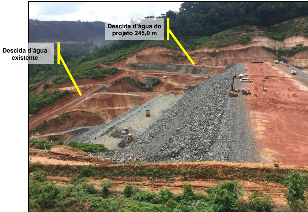
Foto 6-14: Vista da ombreira direita, talude de jusante, da barragem do Mirim. Destaque para o sistema extravasor, existente e em implantação
