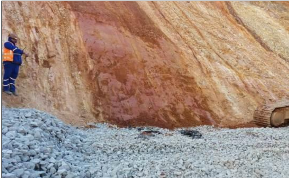
Foto 7-19: Detalhe do milonito da ombreira direita, mostrado na foto anterior
