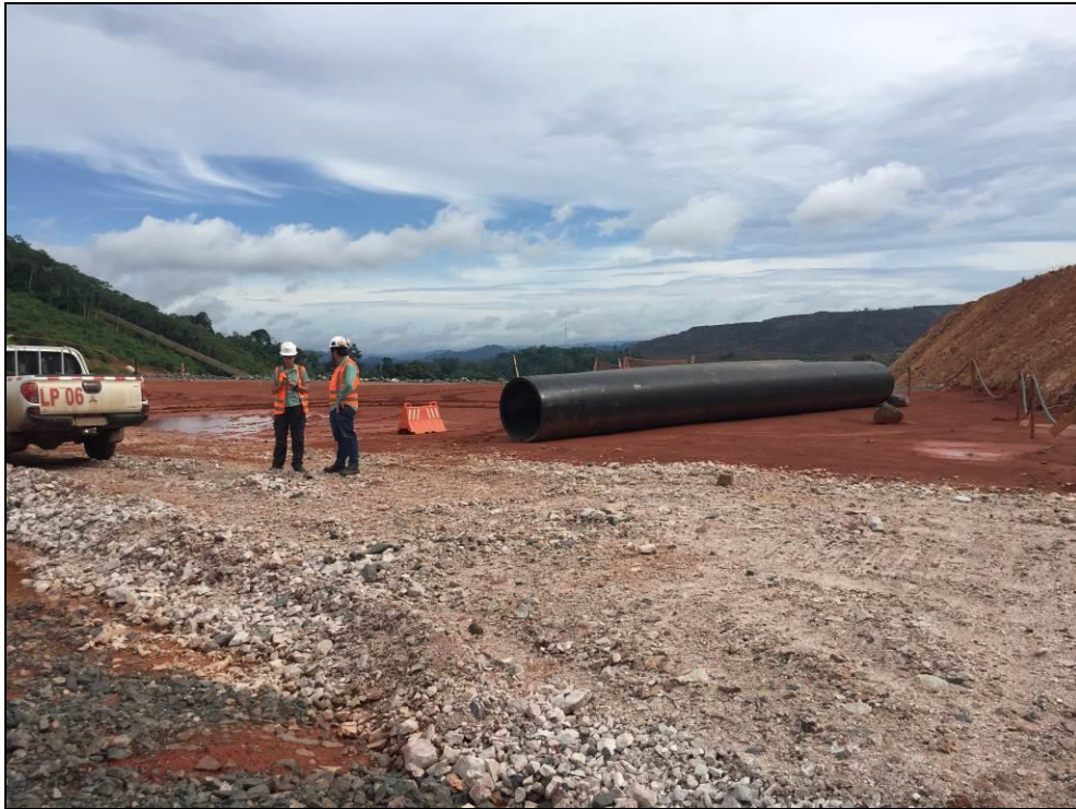
Foto 6-12: Tubulação de PEAD posicionada próximo ao traçado do vertedor projetado
