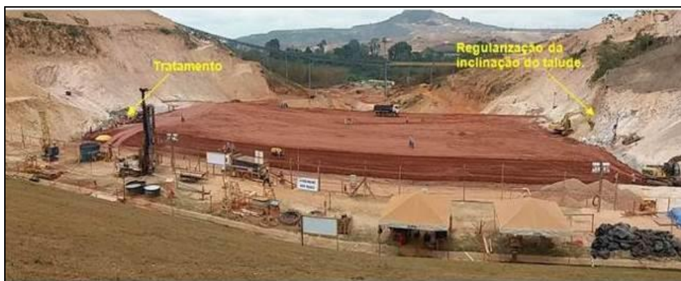
Foto 7-12: Vista geral montante-jusante da limpeza e tratamento das ombreiras e avanço do aterro
