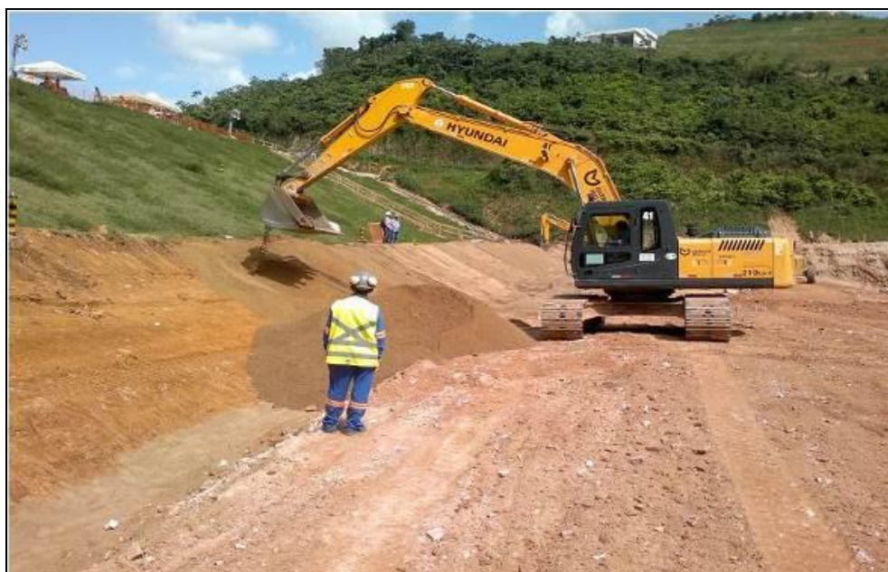
Foto 7-7: Lançamento da camada de areia
