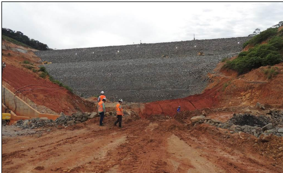
Foto 6-2: Vista de jusante da barragem
