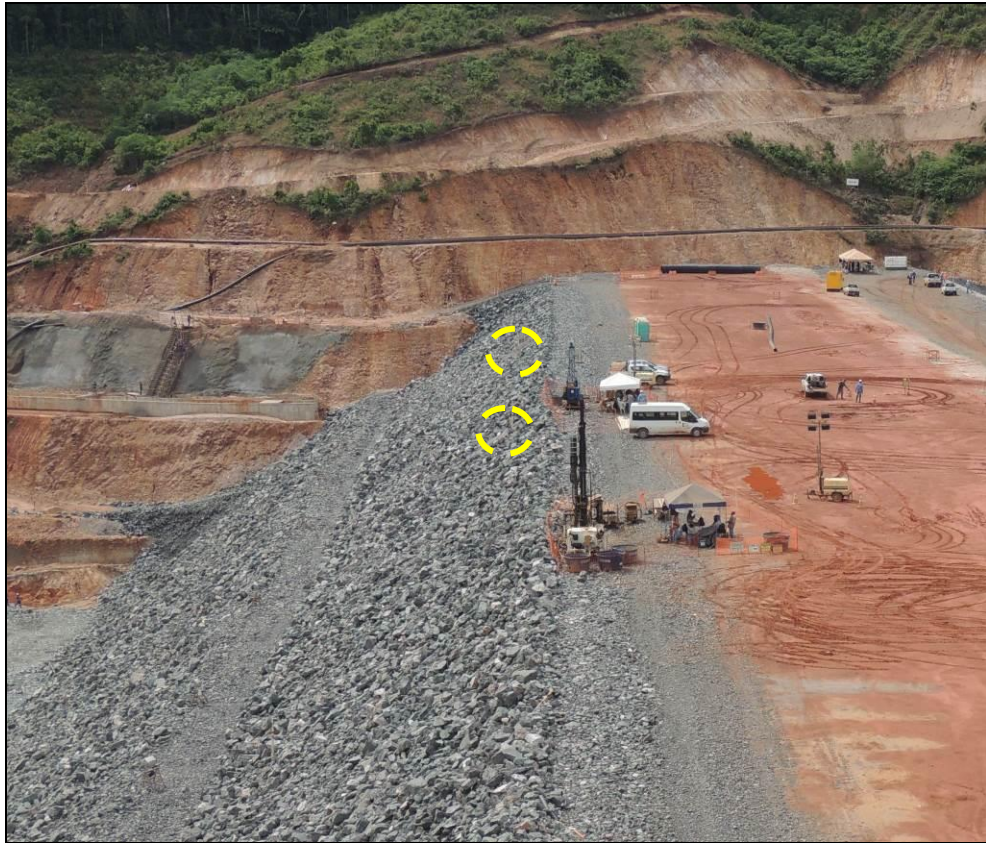
Foto 6-9: Indicação de instrumentos de difícil acesso para realização de leituras
