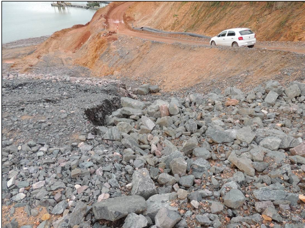
Foto 6-7: Recomposição da erosão na barragem no encontro com a ombreira esquerda
