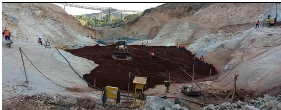
Foto 7-11: Aterro na elevação 181 m
