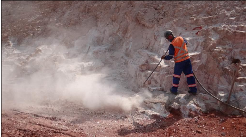
Foto 7-29: Limpeza da fundação com jato de ar comprimido na região do núcleo argiloso
