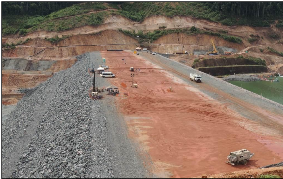
Foto 6-3: Vista geral da crista da Barragem e da ombreira direita
