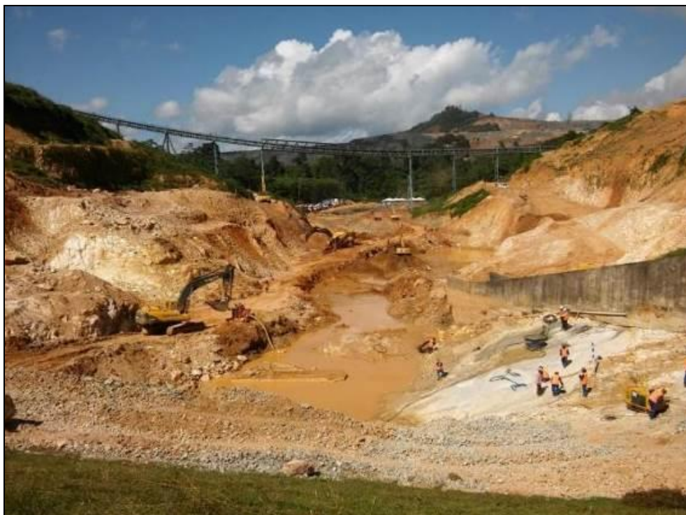
Foto 7-10: Início da escavação da fundação da barragem na região do fundo do vale
