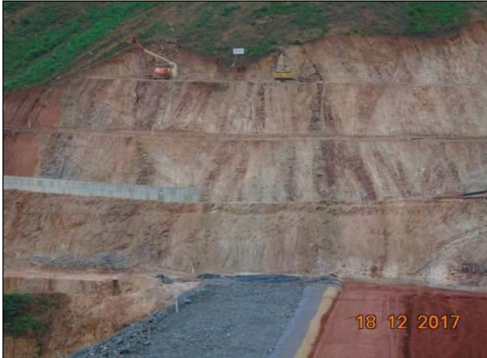
Foto 7-16: Vista geral do quartzito medianamente resistente/alterado e muito fraturado da ombreira direita.
