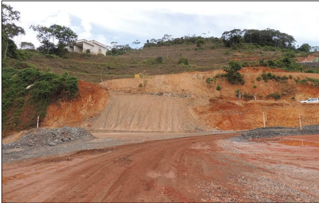
Foto 6-6: Modificação do acesso provisório com o devido caimento do acesso para que as águas pluviais sejam corretamente direcionadas
