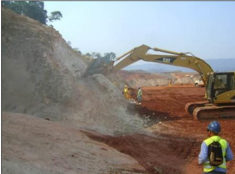
Foto 7-3: Regularização do ângulo de inclinação do maciço rochoso.
