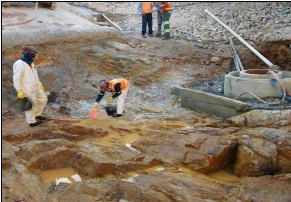
Foto 7-22: Trecho de fundação da laje de injeção após remoção de material de baixa resistência. A direita observa-se poço de bombeamento para o controle das surgências de água na fundação da barragem.
