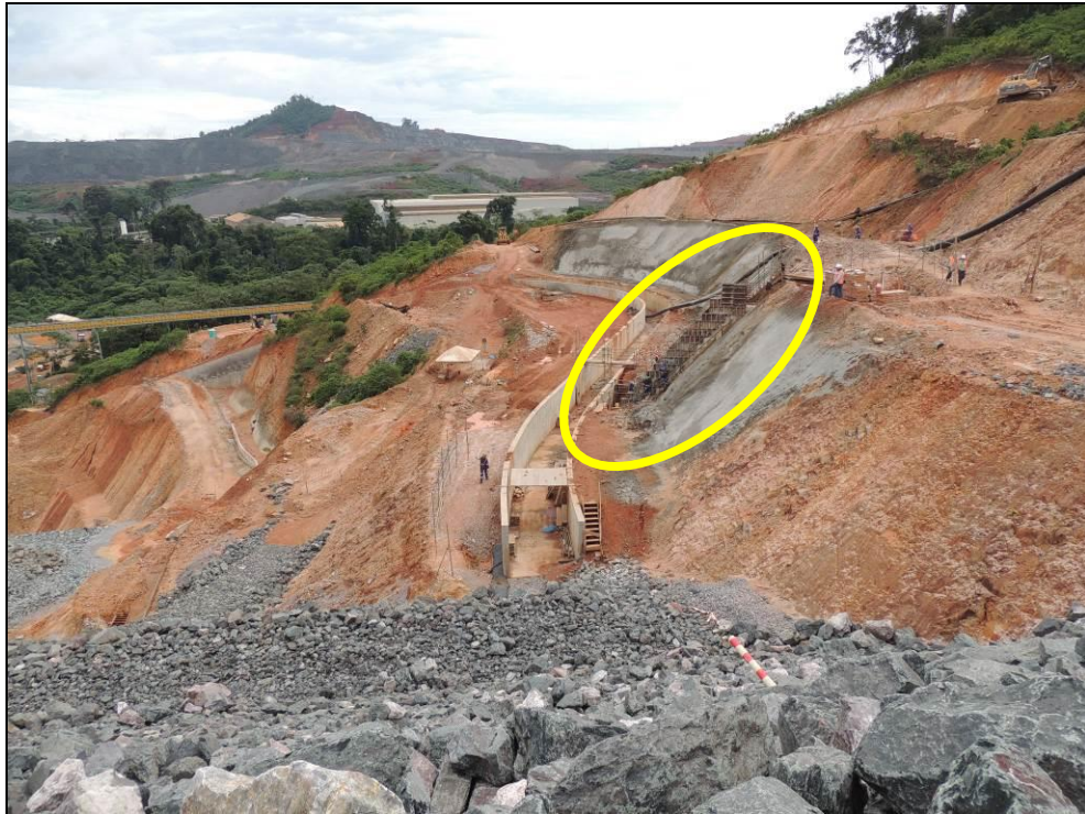
Foto 6-10: Vista para jusante do sistema extravasor. Destaque para a escada hidráulica em implantação, que deságua no trecho do extravasor existente
