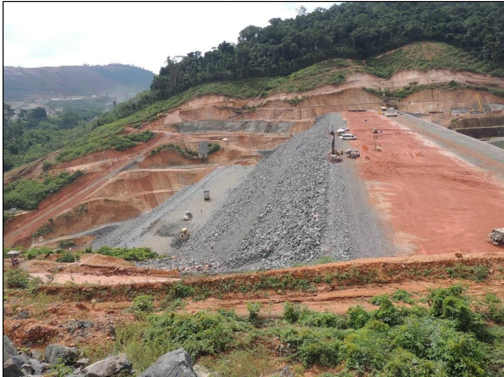
Foto 6-1: Vista geral da barragem
