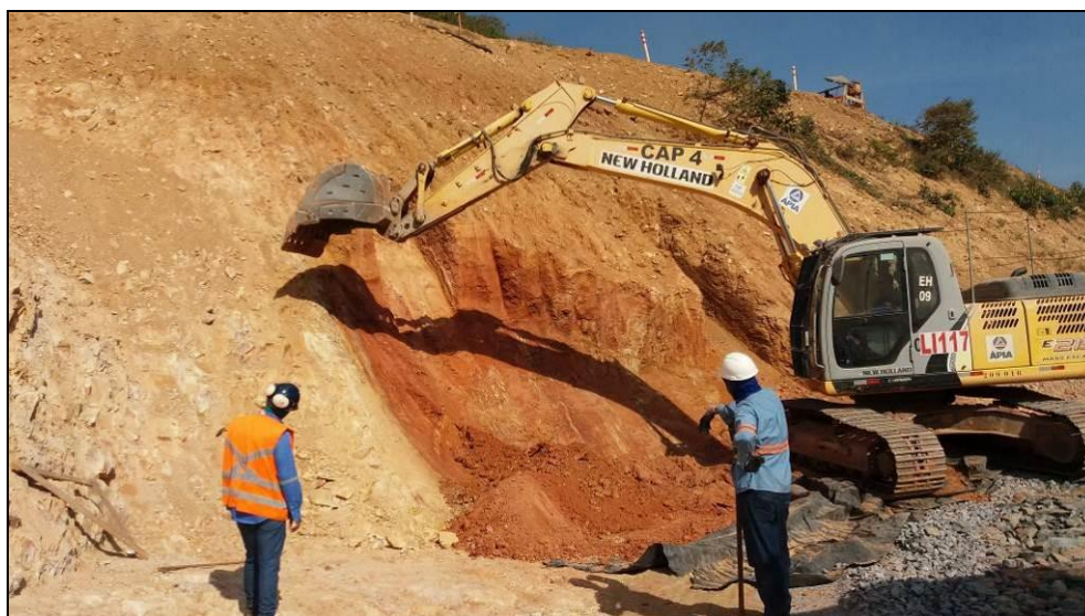
Foto 7-28: Escavação para remoção de solos com resistência menor que a prevista em projeto para o suporte da fundação.
