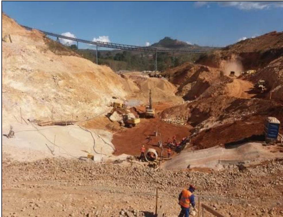
Foto 7-14: Vista de Montante para jusante da fundação da Barragem com as ombreias de quartzito (A4, R2+, F4).
