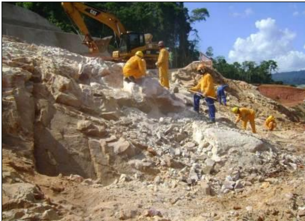
Foto 7-4: Remoção de saliências no maciço rochoso da zona de montante.
