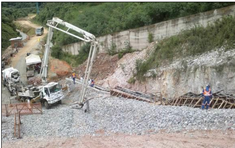
Foto 7-8: Continuação da implantação do canal periférico DA-02
