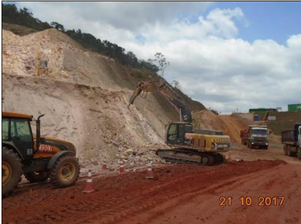
Foto 7-25: Correção nos ângulos dos taludes na ombreira direita
