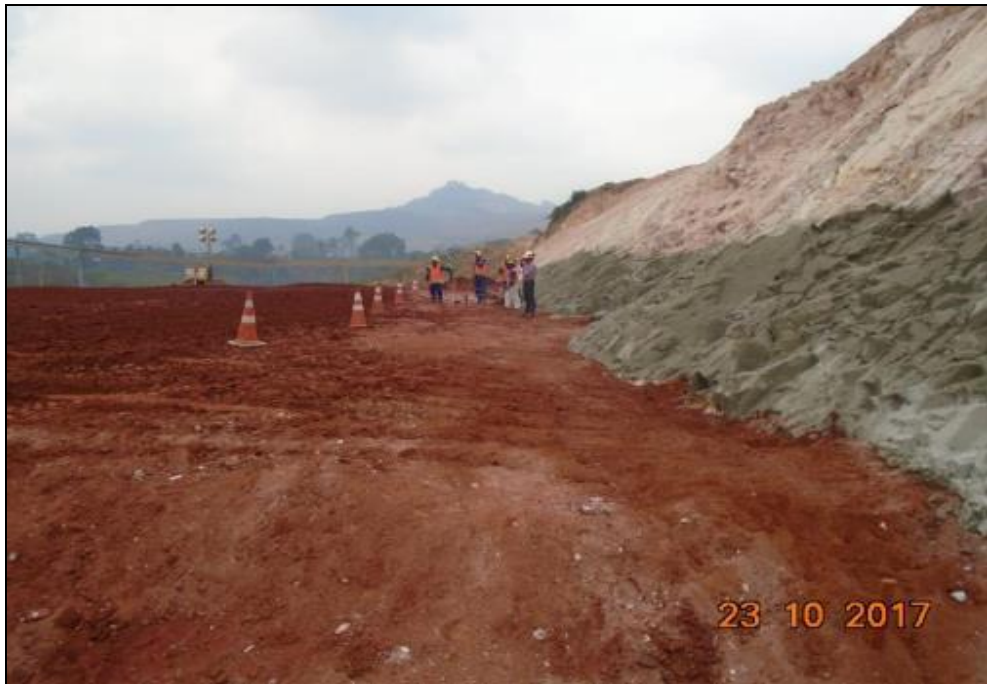
Foto 7-24: Tratamento com concreto dental e slush grouting , região da ombreira direita
