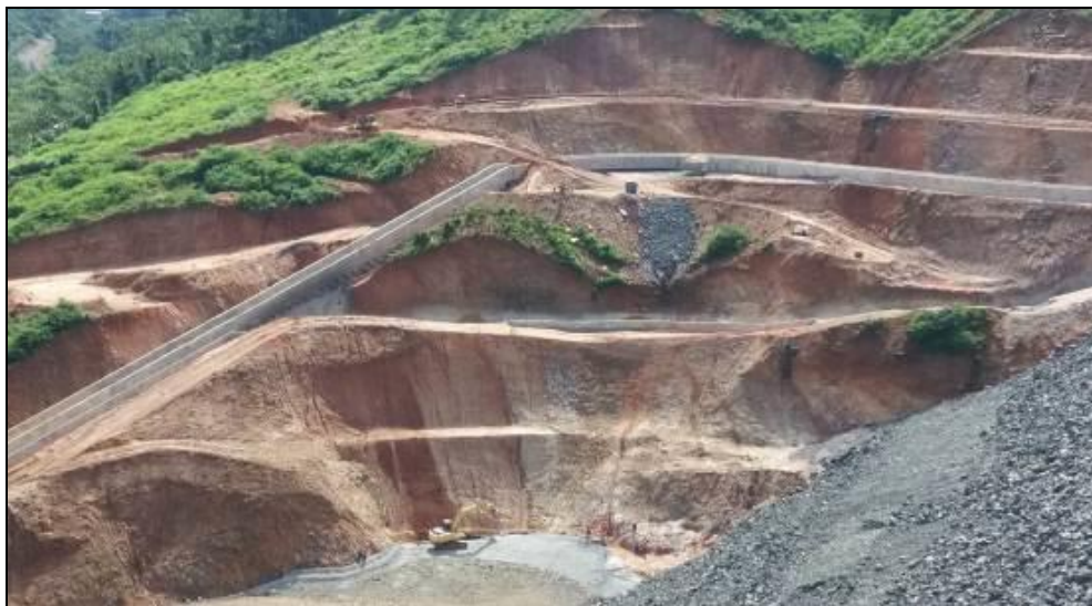
Foto 7-18: Vista da ombreira direita da fundação da Barragem do Mirim, de faixas de milonitos subverticais cortando do quartzito resistente e pouco alterado
