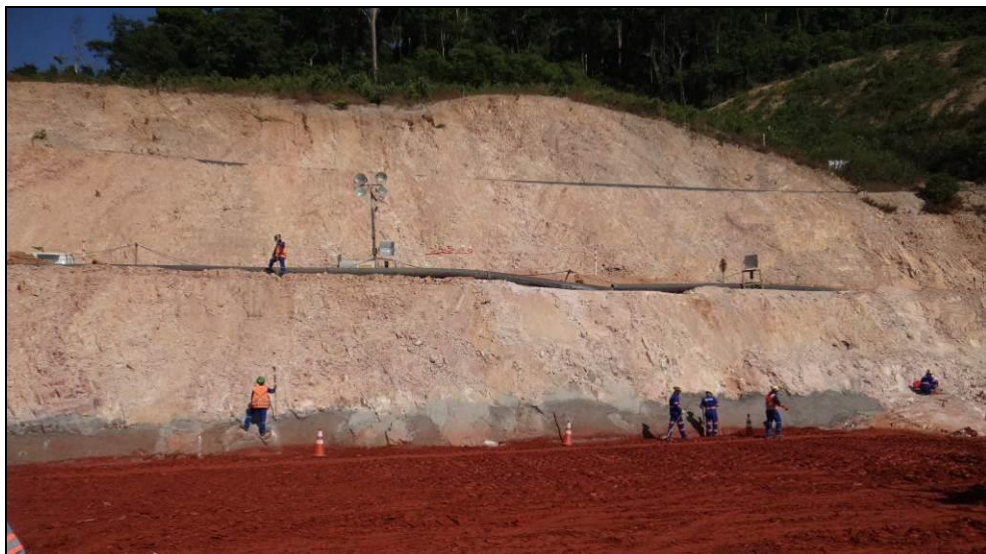
Foto 7-30: Ombreira liberada para o lançamento do aterro argiloso após a execução de escavação, limpeza manual e com ar comprimido e tratamento com slush grout e concreto dental
