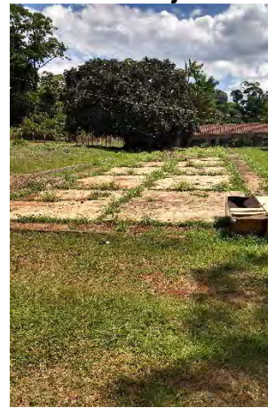
Foto 10 – Platô do Alojamento das empreiteiras, onde anteriormente existiram blocos habitacionais. Detalhe da base de um dos blocos antigos já demolido
