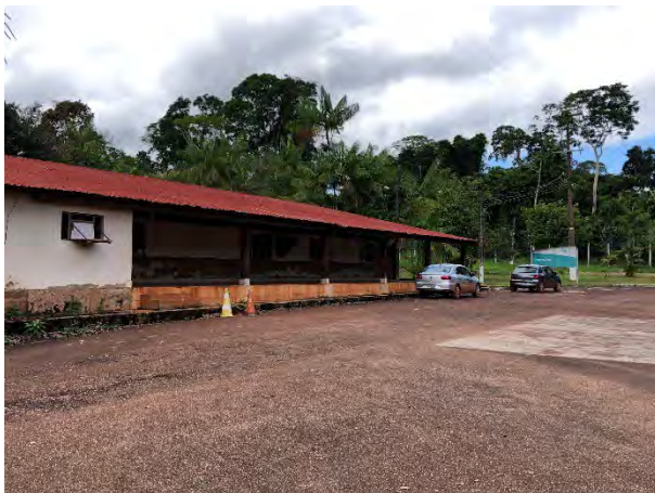
Foto 17 – Restaurante a ser parcialmente mantido /reformado
