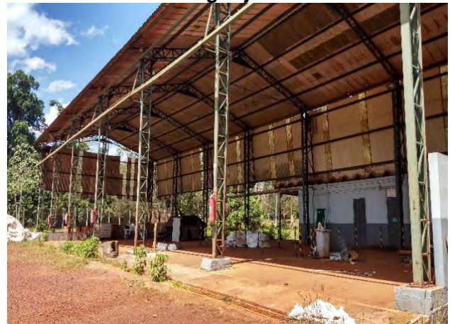
Foto 12 – Antiga rodoviária do alojamento das contratadas, desativada e demolida em 2021
