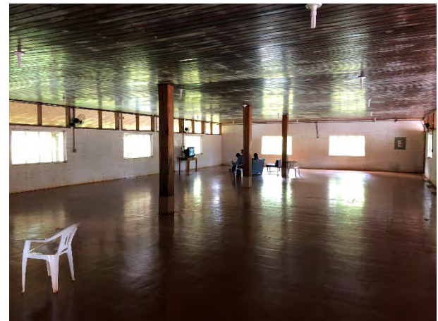
Foto 18 – Vista do salão do restaurante a ser parcialmente mantido/reformado
