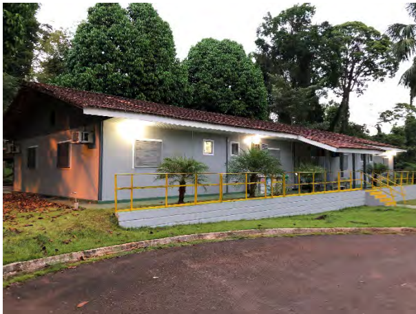
Foto 13 – Bloco habitacional a ser mantido/reformado
