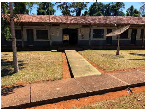
Foto 5 – Módulo habitacional do Alojamento da Vale (existente, em funcionamento)
