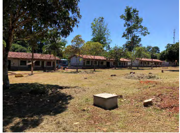
Foto 8 – Platô do Alojamento da Vale
