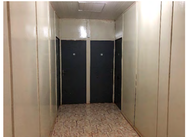
Foto 14 – Vista do interior do bloco habitacional a ser mantido/reformado
