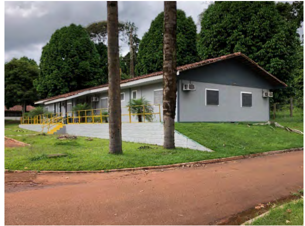
Foto 2 – Módulo habitacional do Alojamento da Vale (existente, em funcionamento)
