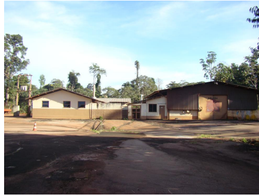
Foto 10 – Laboratório e galpão na mina do Igarapé Bahia - Parauapebas (PA) Acervo Scientia
