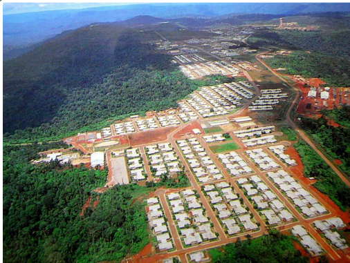
Foto 3 – Núcleo Urbano de Carajás – Parauapebas (PA) Vale
