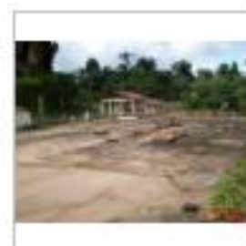
30a - Almojarifado externo.JPG
