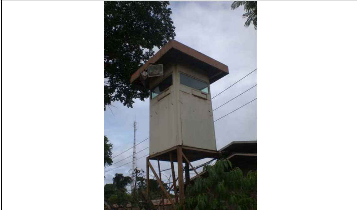
Descrição: Cabine blindada
