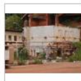
07 - Caixa de Água Incêndio.JPG
