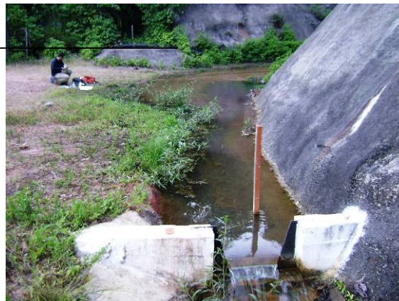
FOTO 01 – Ponto de coleta – vista montante.
