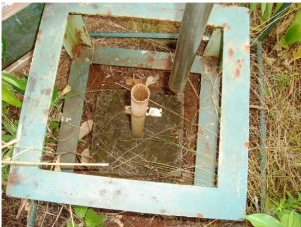
FOTO 03 E 04 - Estrutura do poço.
