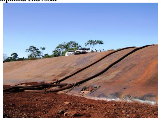
FOTO 06 – Membrana de revestimento.
