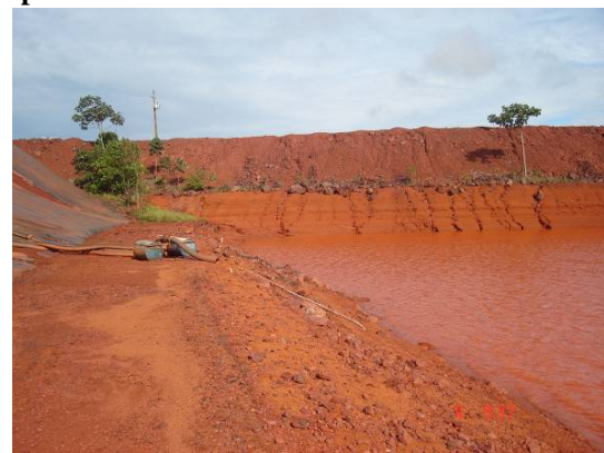
FOTO 04 – Borda do pond com acúmulo de água - campanha chuvosa.
