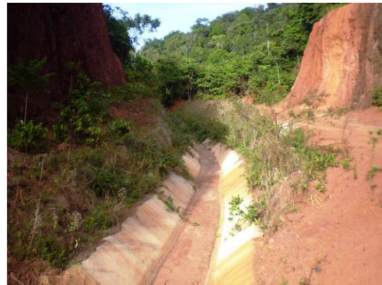
FOTO 04 – Saída do vertedouro seco - campanha de estiagem.
