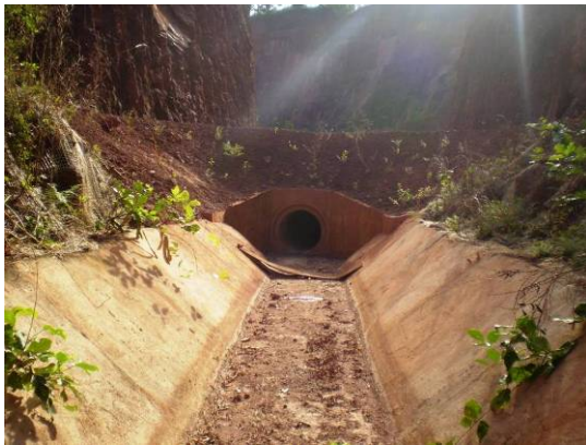
FOTO 03 – Vertedouro seco - campanha de estiagem.
