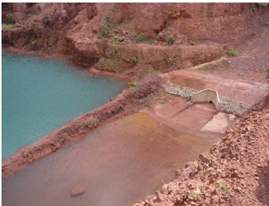
FOTO 03 – Vertedouro seco – campanha de estiagem.
