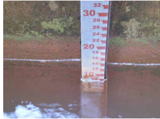
FOTO 01 – Leitura da régua localizada no vertedouro – campanha chuvosa.
