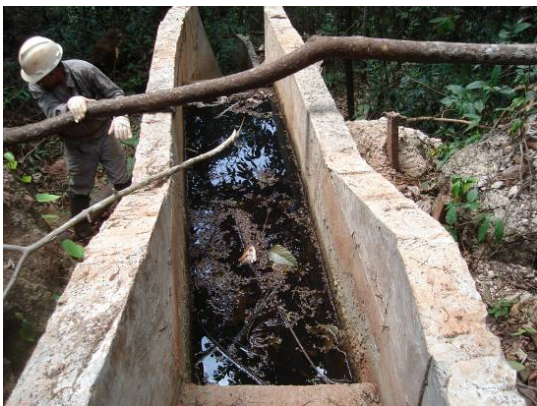
FOTO 01 – Jusante do vertedouro – campanha de estiagem.
