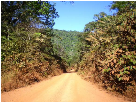
FOTO 05 – Estrada que dá acesso ao ponto localizado a jusante
