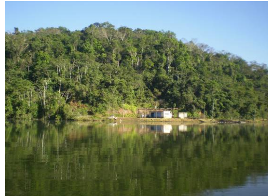
FOTO 02 – Reservatório de água bruta – estação de energia - campanha de estiagem.
