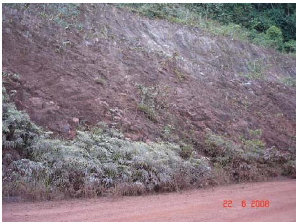
Foto 71– A- 58 - Talude com arenito fino, esbranquiçado, resistente. Sn: 100°/45°.
