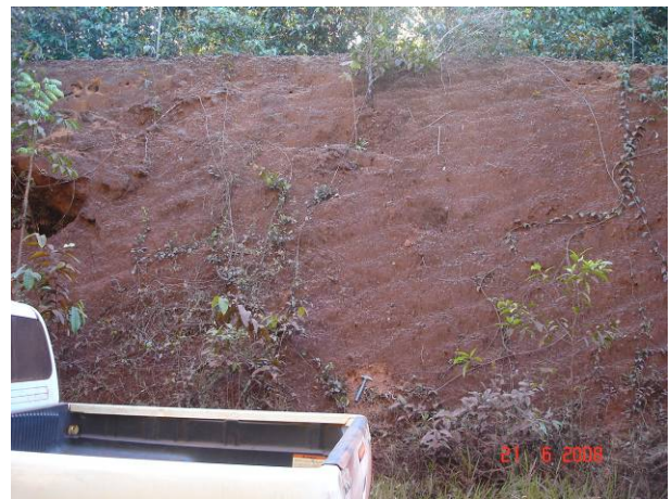
Foto 56 – A- 48 - Talude à direita, de 6m de altura, solo laterítico com fragmentos cm a dm.
