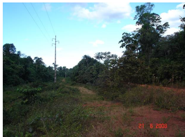
Foto 52 – A- 46 - Percebe-se que o solo na L.T. é arenoso, enquanto que o substrato da estrada é laterítico (aterro).
