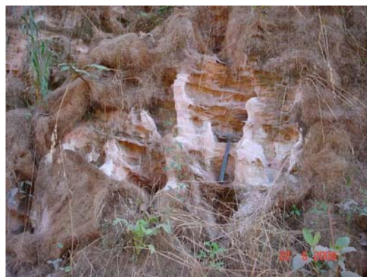
Foto 66 – A- 53 - Talude à esquerda, parte superior (3m) de solo laterítico e parte inferior (6m) de arenito friável (Sn: 095°/20°; 050°/20°).
