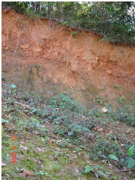
Foto 45 – A- 42 - Talude com 25m de altura de arenito friável e uma cobertura de 1,5m de solo laterítico avermelhado com pedregulhos.
