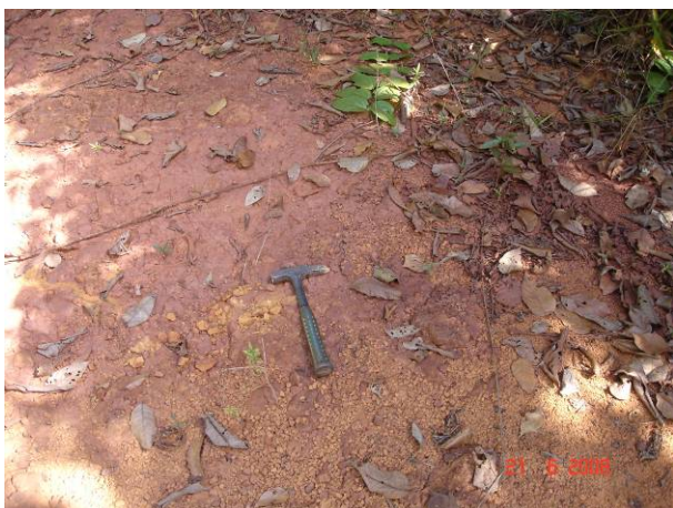
Foto 41 – A-37 - Trecho de aterro da estrada, feito com o mesmo solo laterítico.
