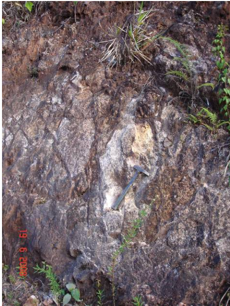
Foto 05 – A-03 - Rocha de coloração rosa avermelhada, silto argilosa, friável.
