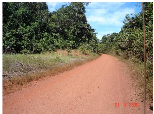
Foto 42 – A-39 - Área de empréstimo à esquerda e estrada em corte logo adiante.
