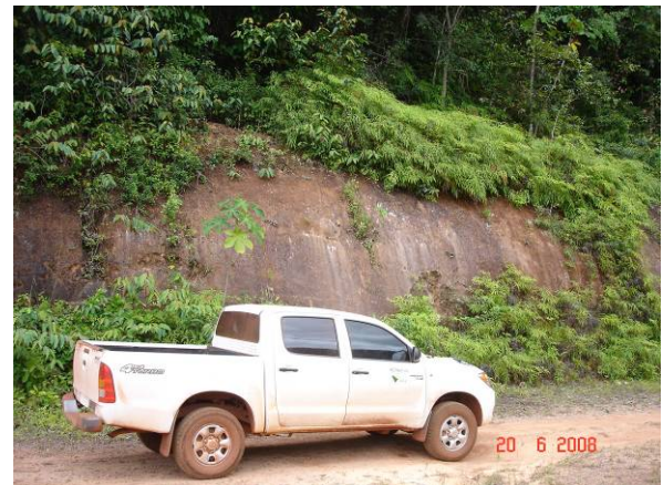
Foto 26 – A-20 - Arenito friável, próximo à adutora, margem esquerda da barragem.
