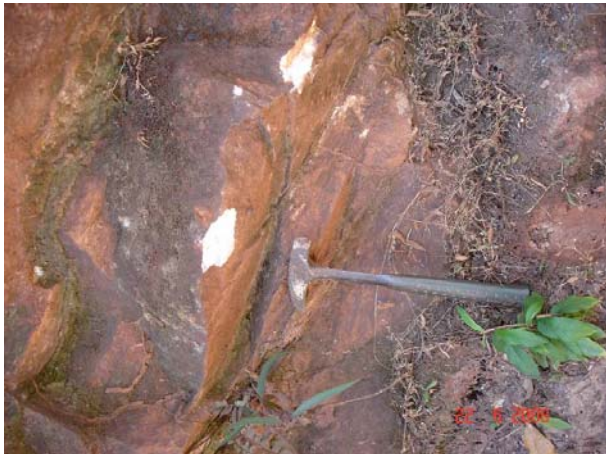
Foto 87– A- 70 - Talude à esquerda. Arenito esbranquiçado, medianamente resistente. Sn: 215°/40°; 230°/15°.
