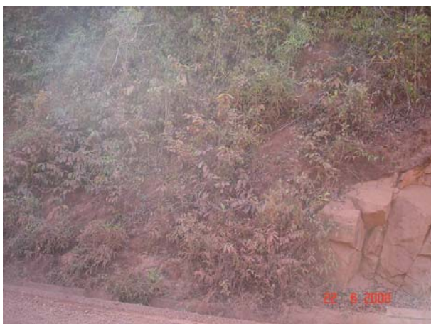
Foto 73 – A- 60 - Rocha extremamente resistente, recristalizada, com presença de sulfetos.
