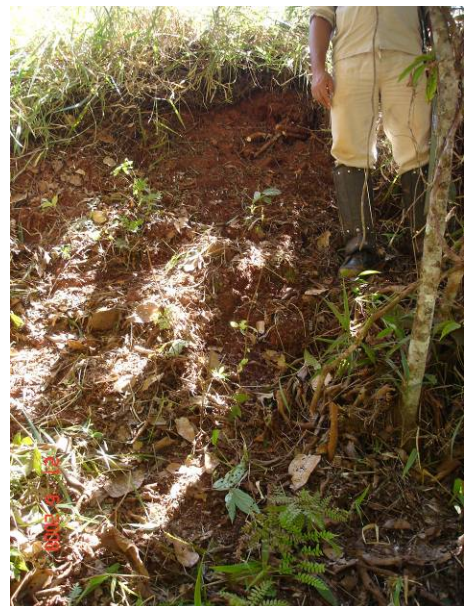
Foto 40 – A-37 - Trecho de aterro da estrada, feito com o mesmo solo laterítico.
