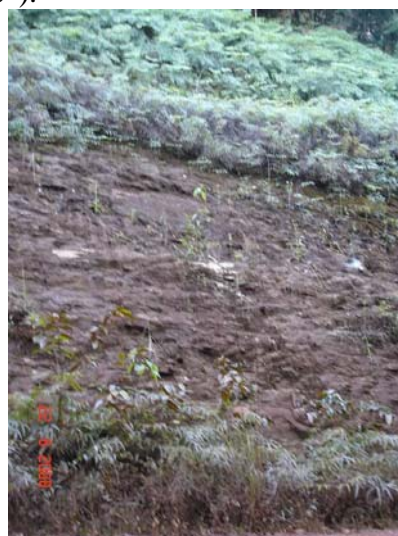
Foto 68 – A- 55 - Talude com 12m de altura, à esquerda, de arenito medianamente resistente.
