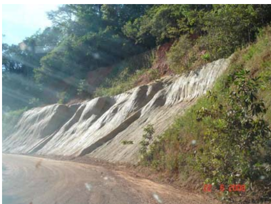
Foto 67 – A- 53 - Talude à esquerda, parte superior (3m) de solo laterítico e parte inferior (6m) de arenito friável (Sn: 095°/20°; 050°/20°).
