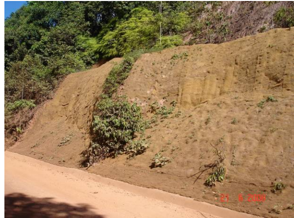
Foto 48 – A- 43 - Talude à direita em arenito friável de coloração esbranquiçada (Sn: 125°/15°; 155°/25°), com cerca de 20m de altura, parcialmente recuperado.
