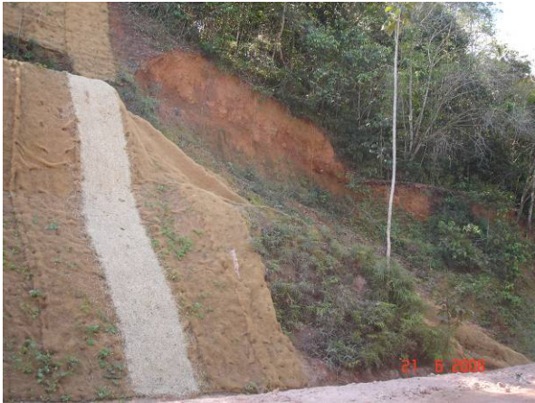
Foto 47 – A- 42 - Talude com tela vegetal.
