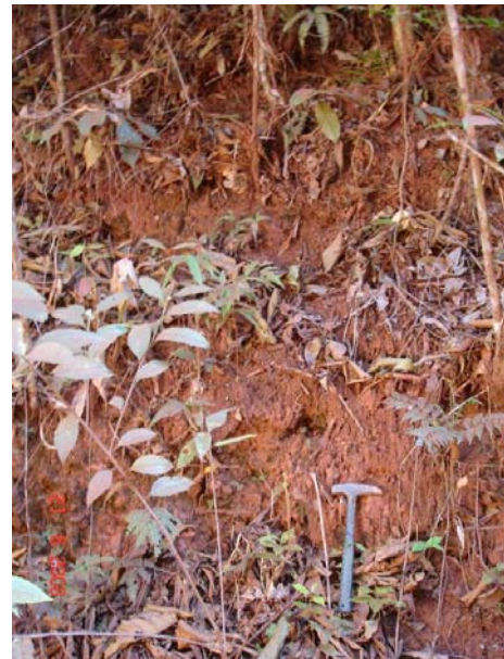
Foto 58 – A- 49 - Talude à direita, de 3m de altura.
