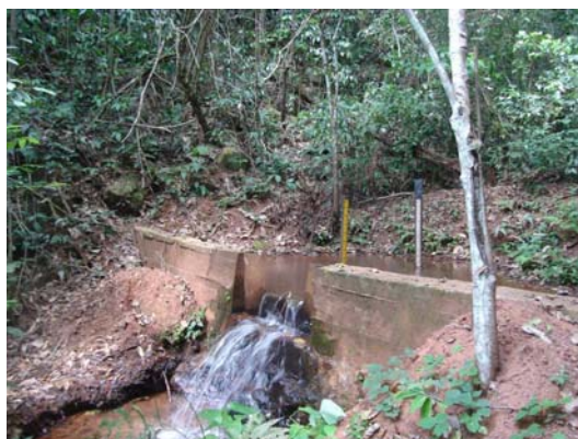
FOTO 16 – Vertedouro de monitoramento fluviométrico VT-02 – igarapé Galeria. (GOLDER, setembro de 2008).
