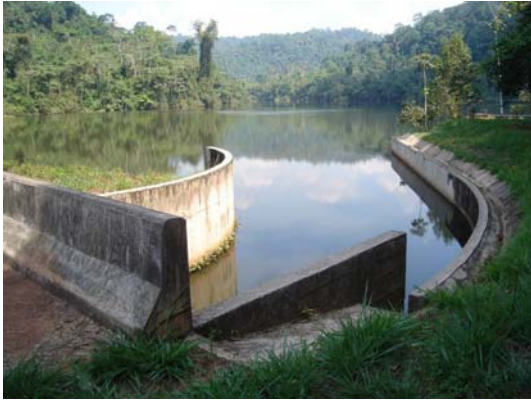
FOTO 25 – Canal de aproximação do vertedouro da barragem. (GOLDER, setembro de 2008).
