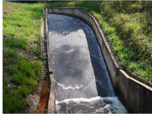
FOTO 26 – Rápido do vertedouro da barragem. (GOLDER, setembro de 2008).
