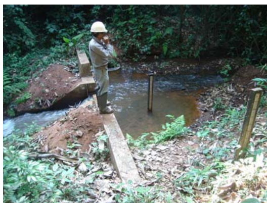
FOTO 18 – Vertedouro de monitoramento fluviométrico VT-07 – Igarapé Alemão. (GOLDER, setembro de 2008).
