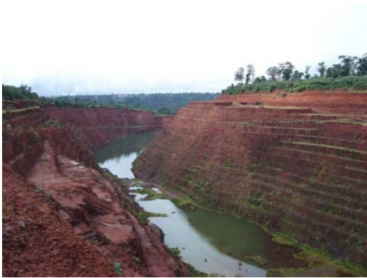
FOTO 31 – Cava Acampamento Sul da Mina Igarapé Bahia. (GOLDER, maio de 2008).
