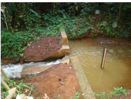
FOTO 17 – Vertedouro de monitoramento fluviométrico VT-07 – Igarapé Alemão. (GOLDER, maio de 2008).
