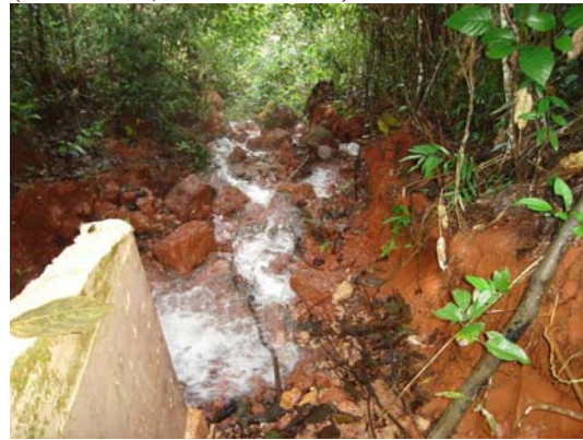
FOTO 34 – Final da descida de água em degrau e início do escoamento em terreno natural das vazões vertidas da Cava Acampamento Sul. (GOLDER, maio de 2008).
