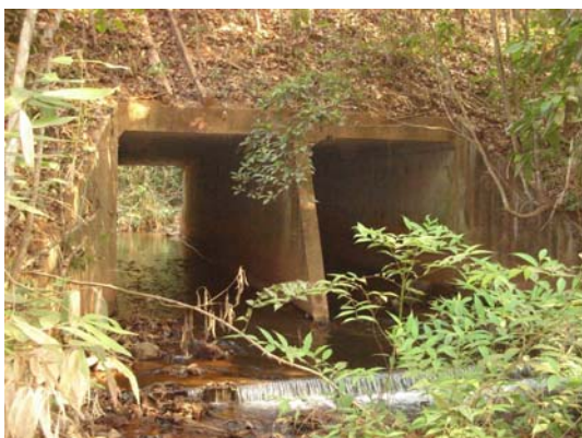
FOTO 15 – Ribeirão Águas Claras - Vista de jusante para montante do bueiro de travessia da estrada de acesso ao Projeto Alemão. (GOLDER, setembro de 2008).
