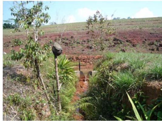
FOTO 28 – Vertedouro de monitoramento fluviométrico VT-05 que monitora as vazões percoladas pelo maciço da barragem. (GOLDER, setembro de 2008).
