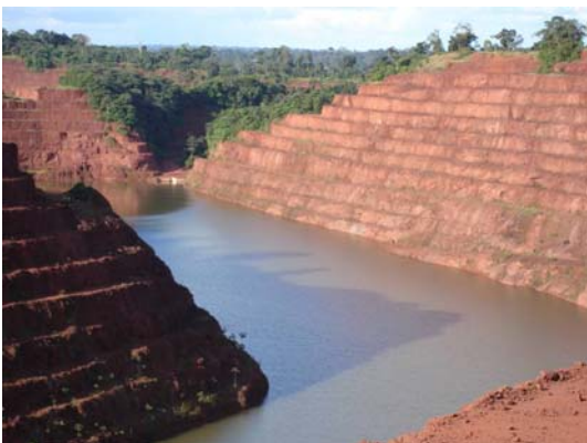
FOTO 23 – Cava Furo 30 da Mina Igarapé Bahia. Ao fundo, o sistema extravasor composto por ala de emboque e bueiro circular simples. (GOLDER, maio de 2008).
