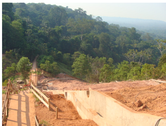
Figura 13: Escada de acesso e canaletas
