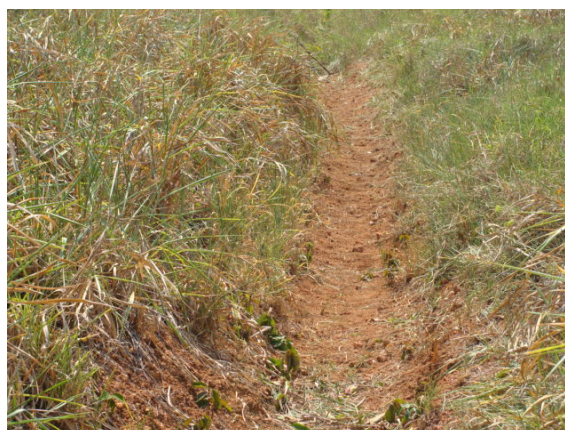
Figura 17: Canaleta natural para escoamento das águas pluviais
