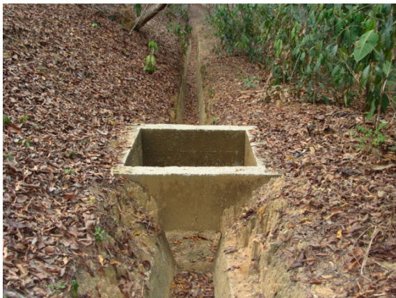
Figura 5: Caixa de drenagem e canaleta
