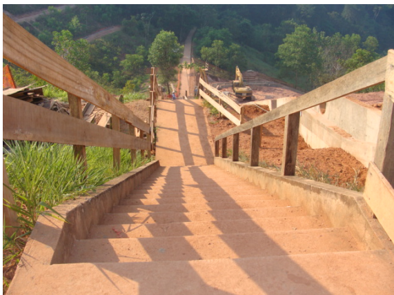
Figura 10: Escada de acesso ao dissipador de energia
