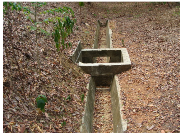
Figura 6: Caixa de drenagem e canaleta
