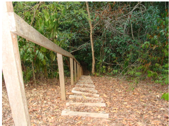
Figura 8: Escada de acesso
