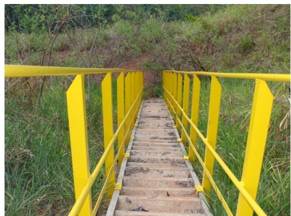
Figura 25: Escada de acesso
