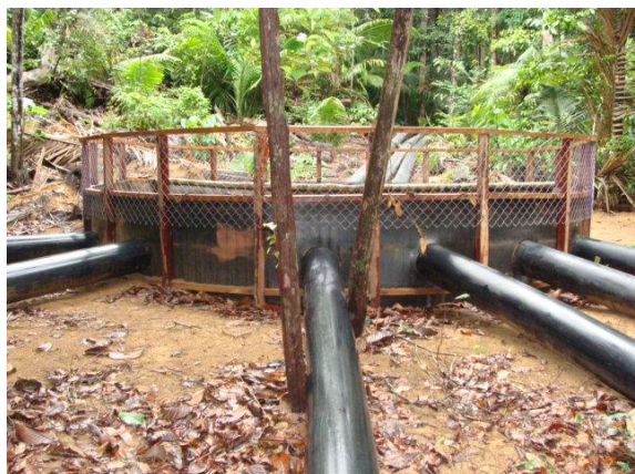
Figura 5: Novo dissipador de energia
