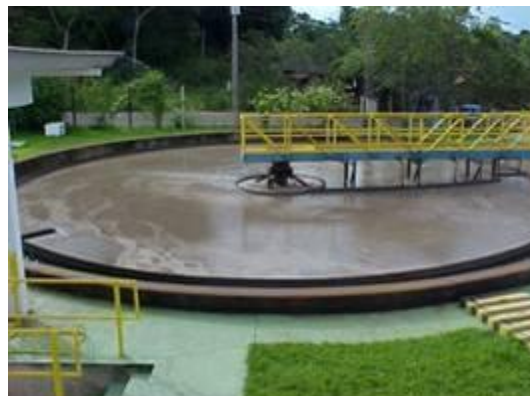
Figura 1061: Tanque de decantação
