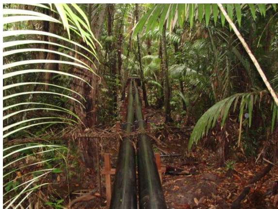
Figura 14: Prolongamento da tubulação
