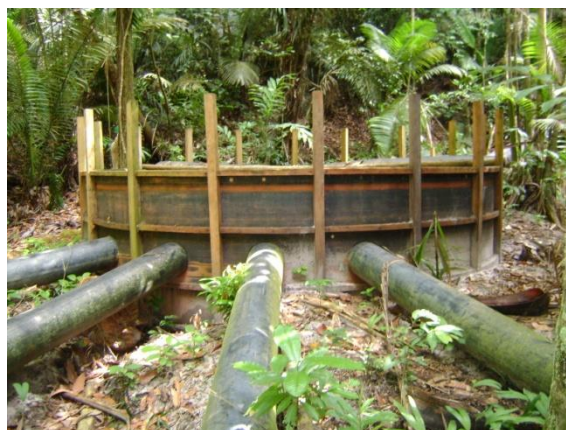
Figura 78: Construção de novo dissipador de energia
