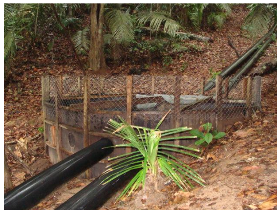
Figura 15: Prolongamento da tubulação
