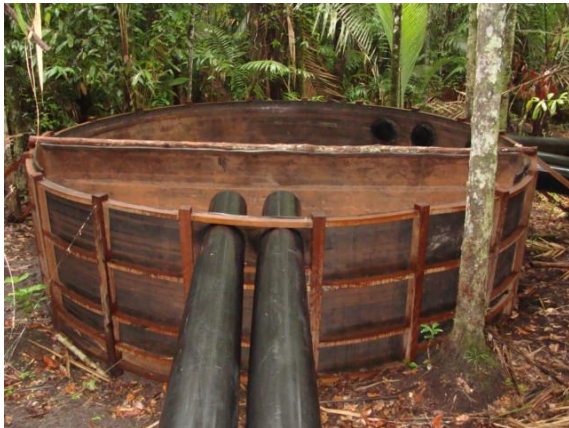
Figura 10: Novo dissipador de energia construído
