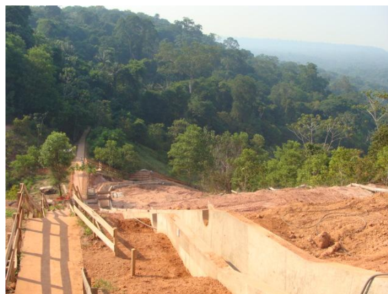
Figura 35: Escada de acesso e canaletas
