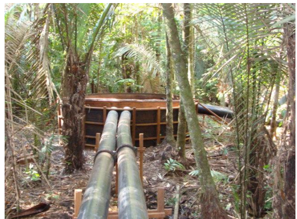
Figura 13: Prolongamento da tubulação
