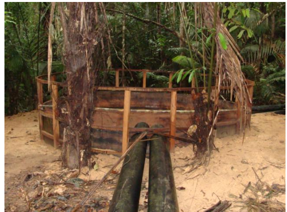
Figura 21: Novo dissipador de energia construído
