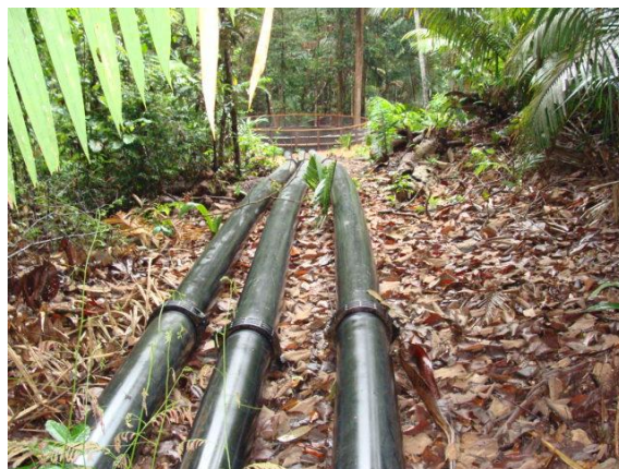
Figura 7: Prolongamento da tubulação
