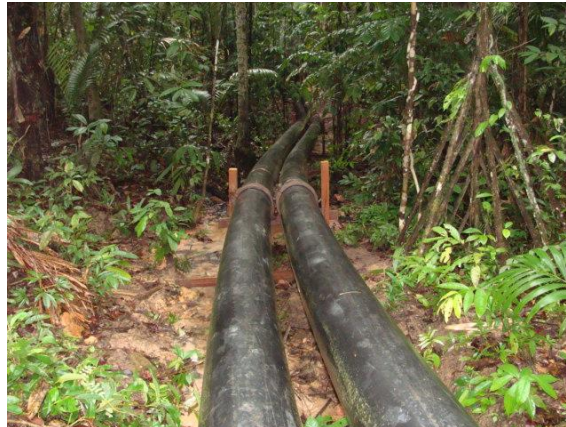
Figura 24: Prolongamento da tubulação
