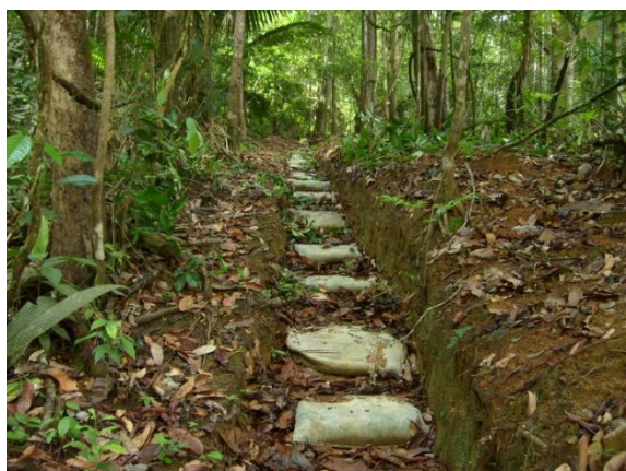
Figura 60: Erosão natural – valeta de crista
