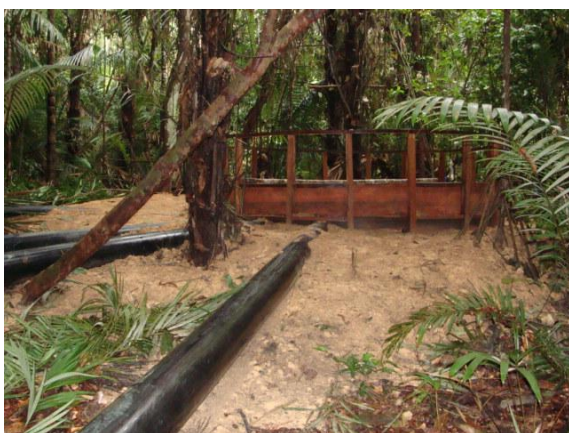
Figura 22: Dissipador de energia
