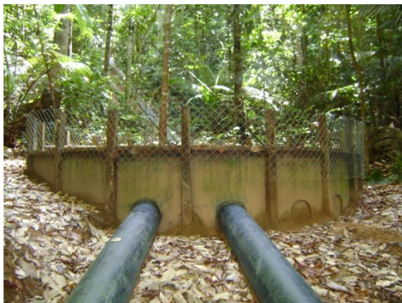
Figura 79: Dissipador de energia
