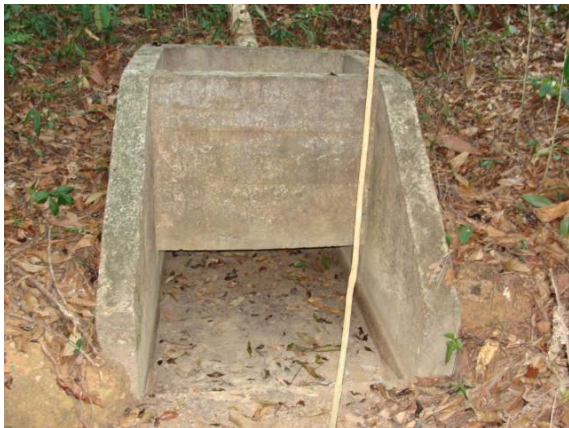
Figura 29: Dissipador de energia
