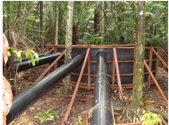
Figura 11: Dissipador de energia
