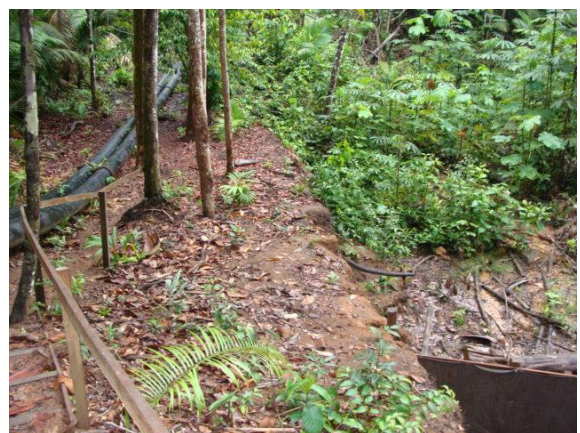
Figura 23: Prolongamento da tubulação
