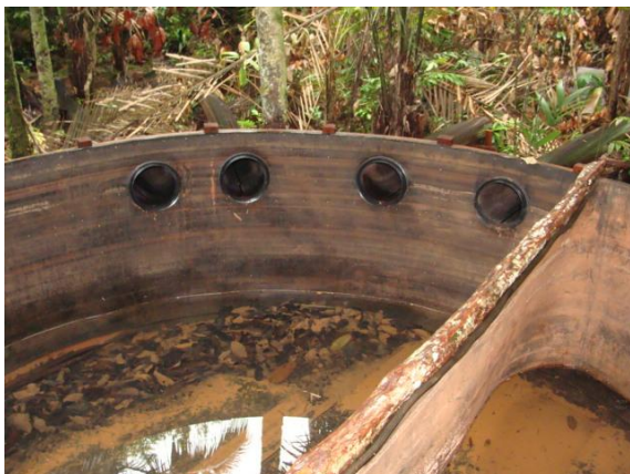
Figura 12: Dissipador de energia
