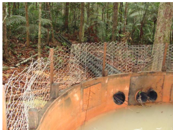
Figura 6: Prolongamento da tubulação
