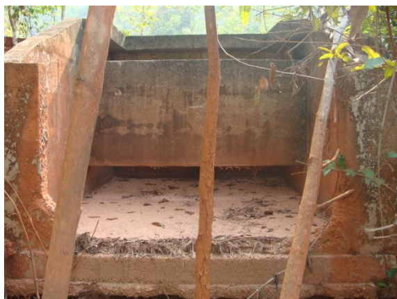
Figura 34: Dissipador de energia
