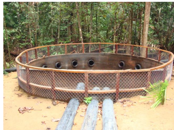
Figura 4: Novo dissipador de energia construído
