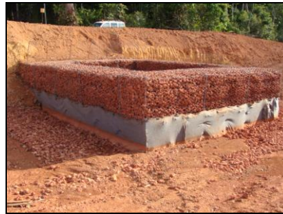
AV 03 (E 0557445 / N 9807153) - Coordenada do ponto do filtro gabião Tubulação com filtro na captação de água e dissipador de energia na ponta inferior.
