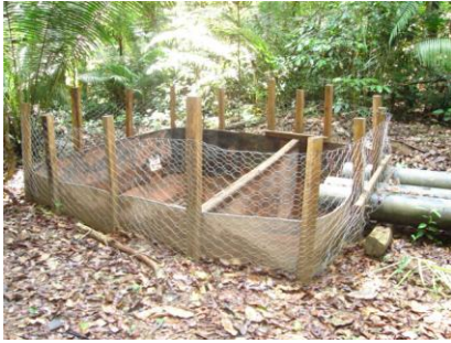
AV 09 (E 0556045 / N 9804904) - Coordenada do ponto do filtro gabião Tubulação com filtro na captação de água e dissipador de energia na ponta inferior.
