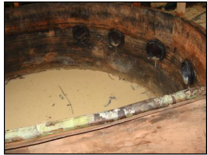
AV 12 (E 0555284 / N 9808253) - Coordenada do ponto do filtro gabião Tubulação com filtro na captação de água e dissipador de energia na ponta inferior.
