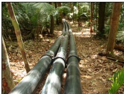
AV 14 (E 0558552 / N 9806722) - Coordenada do ponto do filtro gabião Tubulação com filtro na captação de água e dissipador de energia na ponta inferior
