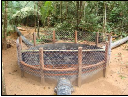
AV 13 (E 0555104 / N 9805803) - Coordenada do ponto do filtro gabião Tubulação com filtro na captação de água e dissipador de energia na ponta inferior.
