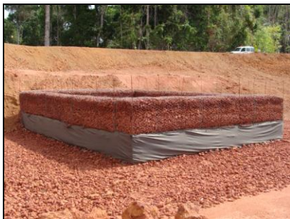
AV 21 (E 0554521 / N 9808569) - Coordenada do ponto do filtro gabião Tubulação com filtro na captação de água e dissipador de energia na ponta inferior.
