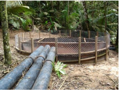
AV 14 (E 0558552 / N 9806722) - Coordenada do ponto do filtro gabião Tubulação com filtro na captação de água e dissipador de energia na ponta inferior
