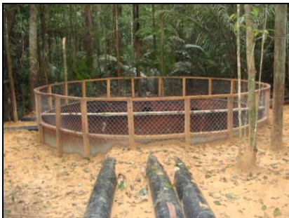
AV 21 (E 0554521 / N 9808569) - Coordenada do ponto do filtro gabião Tubulação com filtro na captação de água e dissipador de energia na ponta inferior.
