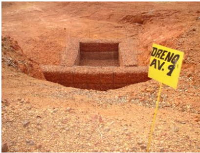
AV 09 (E 0556045 / N 9804904) - Coordenada do ponto do filtro gabião Tubulação com filtro na captação de água e dissipador de energia na ponta inferior.
