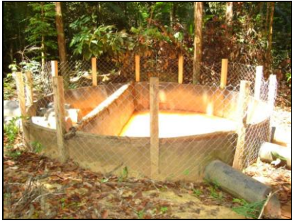
AV 03 (E 0557445 / N 9807153) - Coordenada do ponto do filtro gabião Tubulação com filtro na captação de água e dissipador de energia na ponta inferior.
