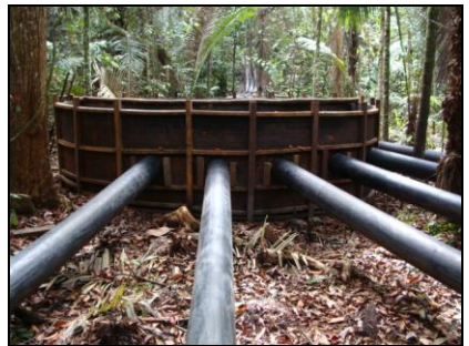
AV 18 (E 0554499 / N 9805873) - Coordenada do ponto do filtro gabião Tubulação com filtro na captação de água e dissipador de energia na ponta inferior.
