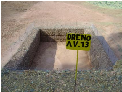
AV 13 (E 0555104 / N 9805803) - Coordenada do ponto do filtro gabião Tubulação com filtro na captação de água e dissipador de energia na ponta inferior.
