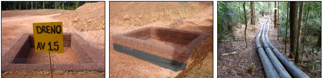
AV 15 (E 0559210 / N 9806445) - Coordenada do ponto do filtro gabião Tubulação com filtro na captação de água e dissipador de energia na ponta inferior.
