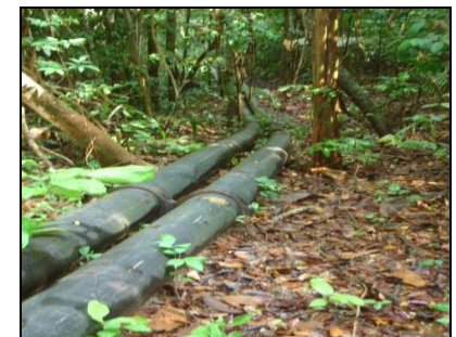
AV 10 (E 0555488 / N 9808157) - Coordenada do ponto do filtro gabião Tubulação com filtro na captação de água e dissipador de energia na ponta inferior.
