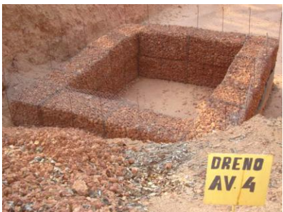
AV 04 (E 0556747 / N 9804773) - Coordenada do ponto do filtro gabião Tubulação com filtro na captação de água e dissipador de energia na ponta inferior.
