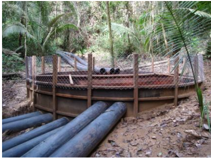
AV 14 (E 0558552 / N 9806722) - Coordenada do ponto do filtro gabião Tubulação com filtro na captação de água e dissipador de energia na ponta inferior
