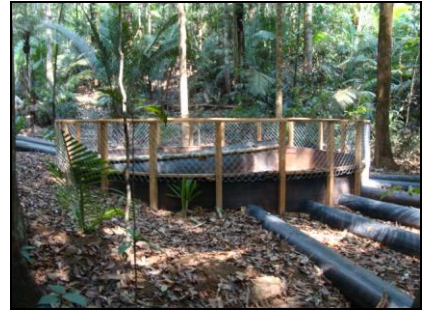
AV 17 (E 0558683 / N 9804843) - Coordenada do ponto do filtro gabião Tubulação com filtro na captação de água e dissipador de energia na ponta inferior.
