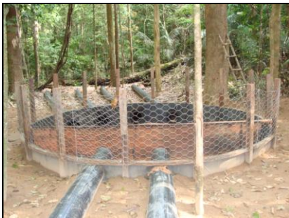
AV 04 (E 0556747 / N 9804773) - Coordenada do ponto do filtro gabião Tubulação com filtro na captação de água e dissipador de energia na ponta inferior.
