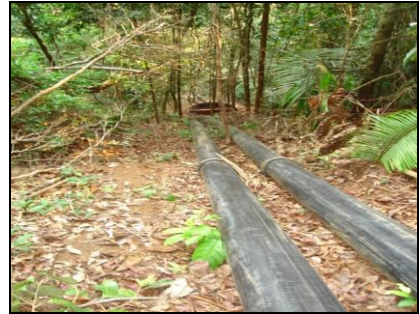
AV 11 (E 0555488 / N 9805310) - Coordenada do ponto do filtro gabião Tubulação com filtro na captação de água e dissipador de energia na ponta inferior.
