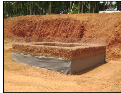
AV 11 (E 0555488 / N 9805310) - Coordenada do ponto do filtro gabião Tubulação com filtro na captação de água e dissipador de energia na ponta inferior.
