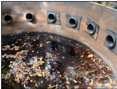
AV 18 (E 0554499 / N 9805873) - Coordenada do ponto do filtro gabião Tubulação com filtro na captação de água e dissipador de energia na ponta inferior.
