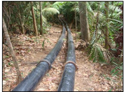
AV 03 (E 0557445 / N 9807153) - Coordenada do ponto do filtro gabião Tubulação com filtro na captação de água e dissipador de energia na ponta inferior.
