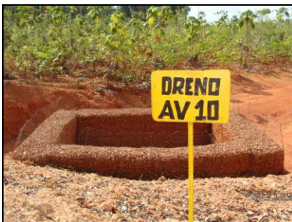
AV 10 (E 0555488 / N 9808157) - Coordenada do ponto do filtro gabião Tubulação com filtro na captação de água e dissipador de energia na ponta inferior.
