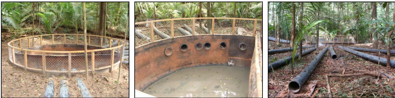
AV 16 (E 0558823 / N 9805945) - Coordenada do ponto do filtro gabião Tubulação com filtro na captação de água e dissipador de energia na ponta inferior.
