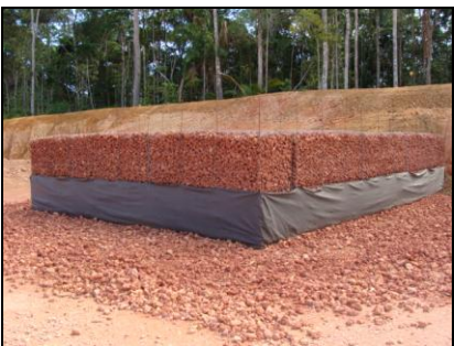
AV 14 (E 0558552 / N 9806722) - Coordenada do ponto do filtro gabião Tubulação com filtro na captação de água e dissipador de energia na ponta inferior
