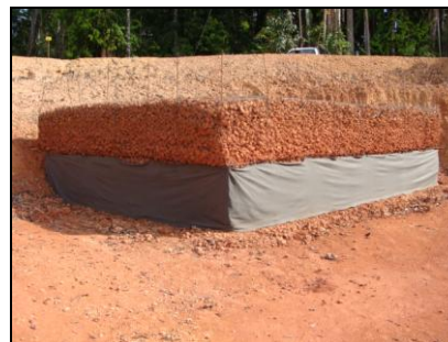
AV 10 (E 0555488 / N 9808157) - Coordenada do ponto do filtro gabião Tubulação com filtro na captação de água e dissipador de energia na ponta inferior.
