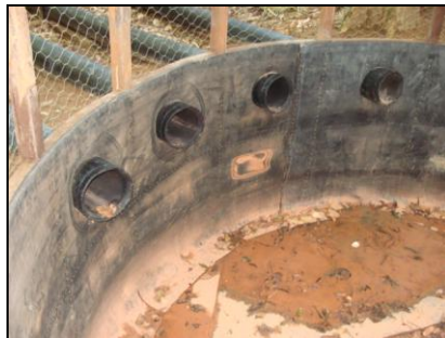
AV 04 (E 0556747 / N 9804773) - Coordenada do ponto do filtro gabião Tubulação com filtro na captação de água e dissipador de energia na ponta inferior.
