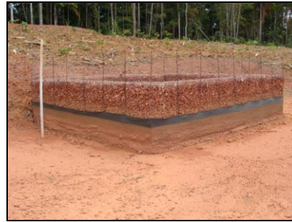
AV 05 (E 0558214 / N 9804867) - Coordenada do ponto do filtro gabião Tubulação com filtro na captação de água e dissipador de energia na ponta inferior.
