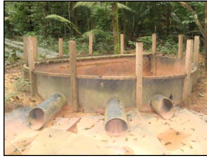
AV 03 (E 0557445 / N 9807153) - Coordenada do ponto do filtro gabião Tubulação com filtro na captação de água e dissipador de energia na ponta inferior.
