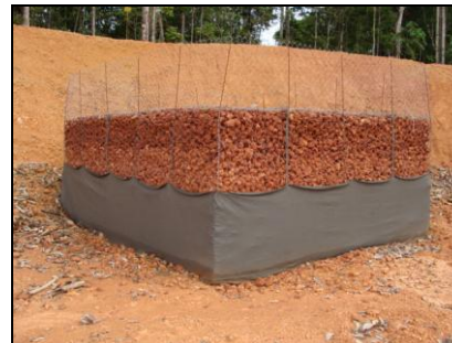
AV 12 (E 0555284 / N 9808253) - Coordenada do ponto do filtro gabião Tubulação com filtro na captação de água e dissipador de energia na ponta inferior.
