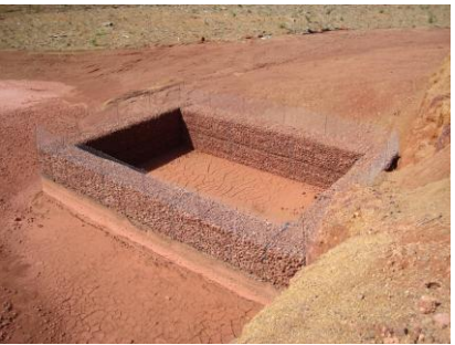
AV 13 (E 0555104 / N 9805803) - Coordenada do ponto do filtro gabião Tubulação com filtro na captação de água e dissipador de energia na ponta inferior.
