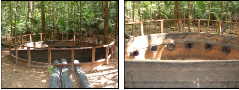
AV 15 (E 0559210 / N 9806445) - Coordenada do ponto do filtro gabião Tubulação com filtro na captação de água e dissipador de energia na ponta inferior.
