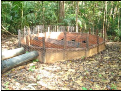
AV 11 (E 0555488 / N 9805310) - Coordenada do ponto do filtro gabião Tubulação com filtro na captação de água e dissipador de energia na ponta inferior.
