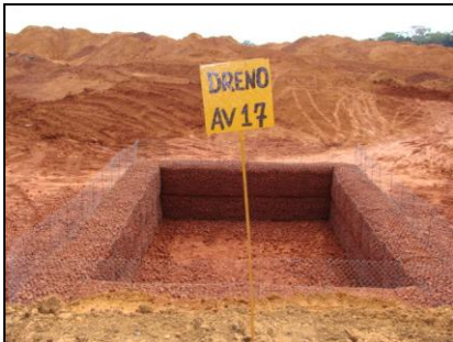
AV 17 (E 0558683 / N 9804843) - Coordenada do ponto do filtro gabião Tubulação com filtro na captação de água e dissipador de energia na ponta inferior.
