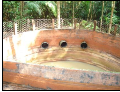
AV 11 (E 0555488 / N 9805310) - Coordenada do ponto do filtro gabião Tubulação com filtro na captação de água e dissipador de energia na ponta inferior.
