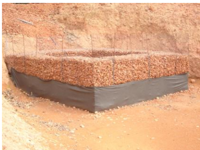
AV 04 (E 0556747 / N 9804773) - Coordenada do ponto do filtro gabião Tubulação com filtro na captação de água e dissipador de energia na ponta inferior.
