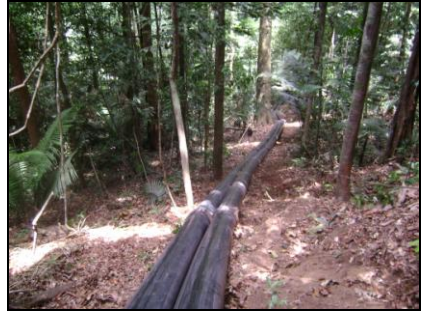
AV 05 (E 0558214 / N 9804867) - Coordenada do ponto do filtro gabião Tubulação com filtro na captação de água e dissipador de energia na ponta inferior.
