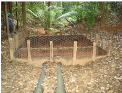
AV 10 (E 0555488 / N 9808157) - Coordenada do ponto do filtro gabião Tubulação com filtro na captação de água e dissipador de energia na ponta inferior.
