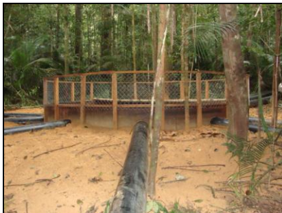
AV 21 (E 0554521 / N 9808569) - Coordenada do ponto do filtro gabião Tubulação com filtro na captação de água e dissipador de energia na ponta inferior.
