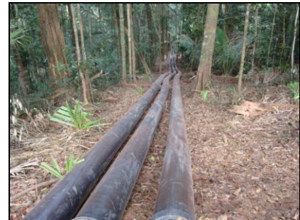
AV 17 (E 0558683 / N 9804843) - Coordenada do ponto do filtro gabião Tubulação com filtro na captação de água e dissipador de energia na ponta inferior.
