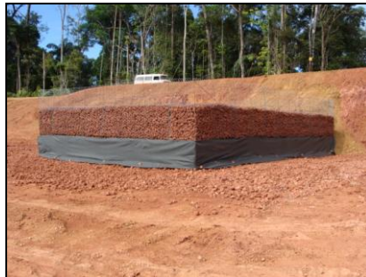
AV 17 (E 0558683 / N 9804843) - Coordenada do ponto do filtro gabião Tubulação com filtro na captação de água e dissipador de energia na ponta inferior.
