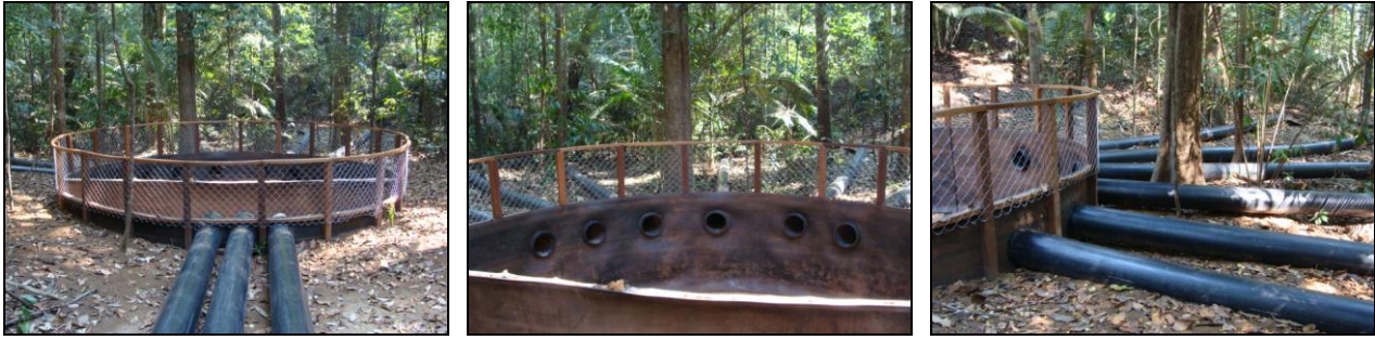
AV 23 (E 0558925 / N 9805653) - Coordenada do ponto do filtro gabião Tubulação com filtro na captação de água e dissipador de energia na ponta inferior.
