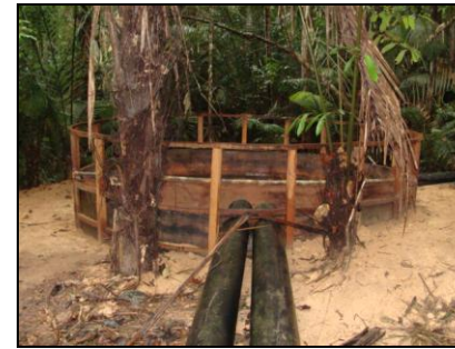
AV 12 (E 0555284 / N 9808253) - Coordenada do ponto do filtro gabião Tubulação com filtro na captação de água e dissipador de energia na ponta inferior.
