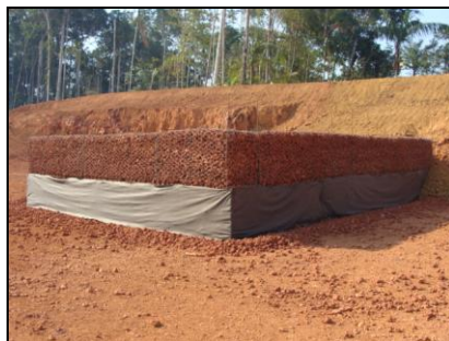
AV 18 (E 0554499 / N 9805873) - Coordenada do ponto do filtro gabião Tubulação com filtro na captação de água e dissipador de energia na ponta inferior.
