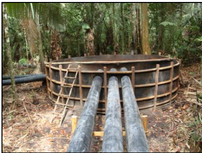
AV 18 (E 0554499 / N 9805873) - Coordenada do ponto do filtro gabião Tubulação com filtro na captação de água e dissipador de energia na ponta inferior.
