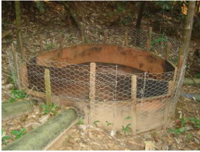
AV 05 (E 0558214 / N 9804867) - Coordenada do ponto do filtro gabião Tubulação com filtro na captação de água e dissipador de energia na ponta inferior.
