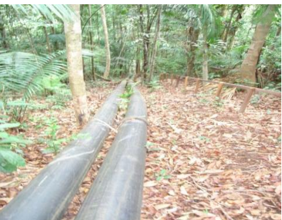
AV 04 (E 0556747 / N 9804773) - Coordenada do ponto do filtro gabião Tubulação com filtro na captação de água e dissipador de energia na ponta inferior.
