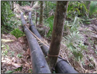
AV 12 (E 0555284 / N 9808253) - Coordenada do ponto do filtro gabião Tubulação com filtro na captação de água e dissipador de energia na ponta inferior.
