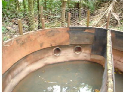
AV 05 (E 0558214 / N 9804867) - Coordenada do ponto do filtro gabião Tubulação com filtro na captação de água e dissipador de energia na ponta inferior.
