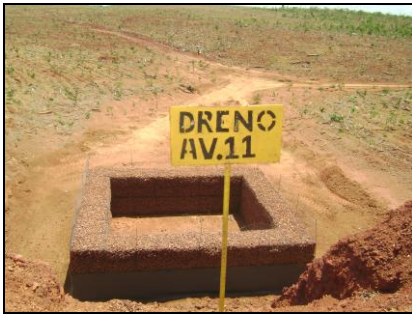
AV 11 (E 0555488 / N 9805310) - Coordenada do ponto do filtro gabião Tubulação com filtro na captação de água e dissipador de energia na ponta inferior.
