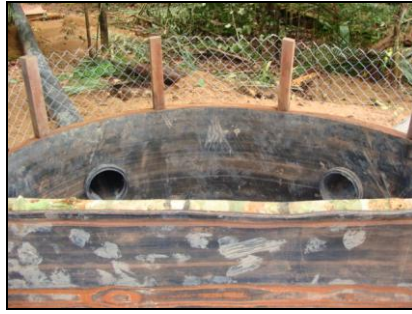
AV 13 (E 0555104 / N 9805803) - Coordenada do ponto do filtro gabião Tubulação com filtro na captação de água e dissipador de energia na ponta inferior.
