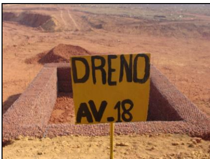
AV 18 (E 0554499 / N 9805873) - Coordenada do ponto do filtro gabião Tubulação com filtro na captação de água e dissipador de energia na ponta inferior.
