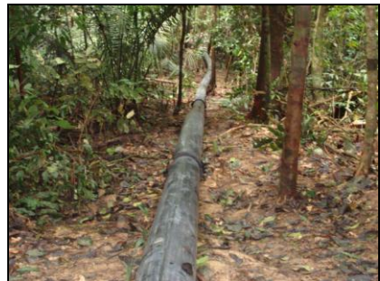
AV 12 (E 0555284 / N 9808253) - Coordenada do ponto do filtro gabião Tubulação com filtro na captação de água e dissipador de energia na ponta inferior.
