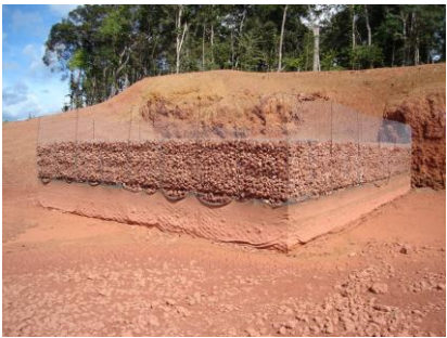
AV 13 (E 0555104 / N 9805803) - Coordenada do ponto do filtro gabião Tubulação com filtro na captação de água e dissipador de energia na ponta inferior.
