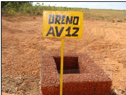
AV 12 (E 0555284 / N 9808253) - Coordenada do ponto do filtro gabião Tubulação com filtro na captação de água e dissipador de energia na ponta inferior.
