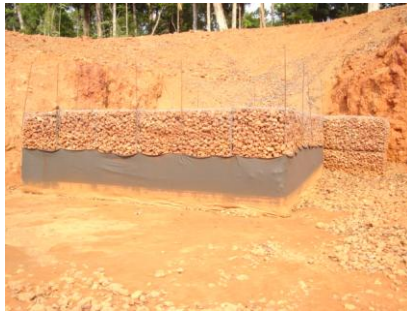
AV 09 (E 0556045 / N 9804904) - Coordenada do ponto do filtro gabião Tubulação com filtro na captação de água e dissipador de energia na ponta inferior.
