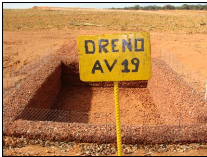
AV 19 (E 0 554915 / N 9808469) - Coordenada do ponto do filtro gabião Tubulação com filtro na captação de água e dissipador de energia na ponta inferior.
