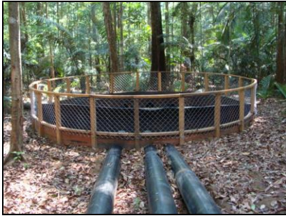
AV 17 (E 0558683 / N 9804843) - Coordenada do ponto do filtro gabião Tubulação com filtro na captação de água e dissipador de energia na ponta inferior.
