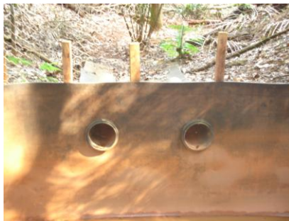
AV 10 (E 0555488 / N 9808157) - Coordenada do ponto do filtro gabião Tubulação com filtro na captação de água e dissipador de energia na ponta inferior.
