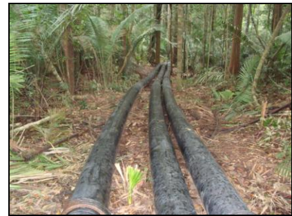
AV 19 (E 0 554915 / N 9808469) - Coordenada do ponto do filtro gabião Tubulação com filtro na captação de água e dissipador de energia na ponta inferior.
