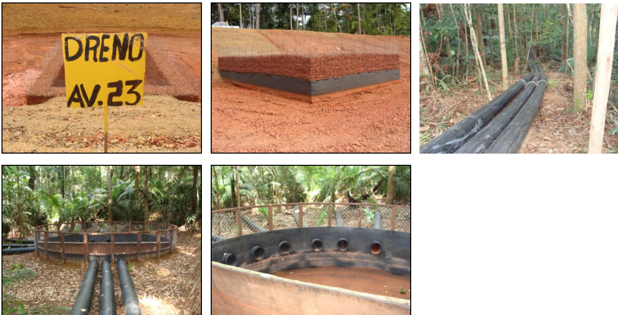
AV 23 (E 0558925 / N 9805653) - Coordenada do ponto do filtro gabião Tubulação com filtro na captação de água e dissipador de energia na ponta inferior.
