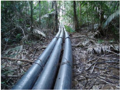
AV 14 (E 0558552 / N 9806722) - Coordenada do ponto do filtro gabião Tubulação com filtro na captação de água e dissipador de energia na ponta inferior
