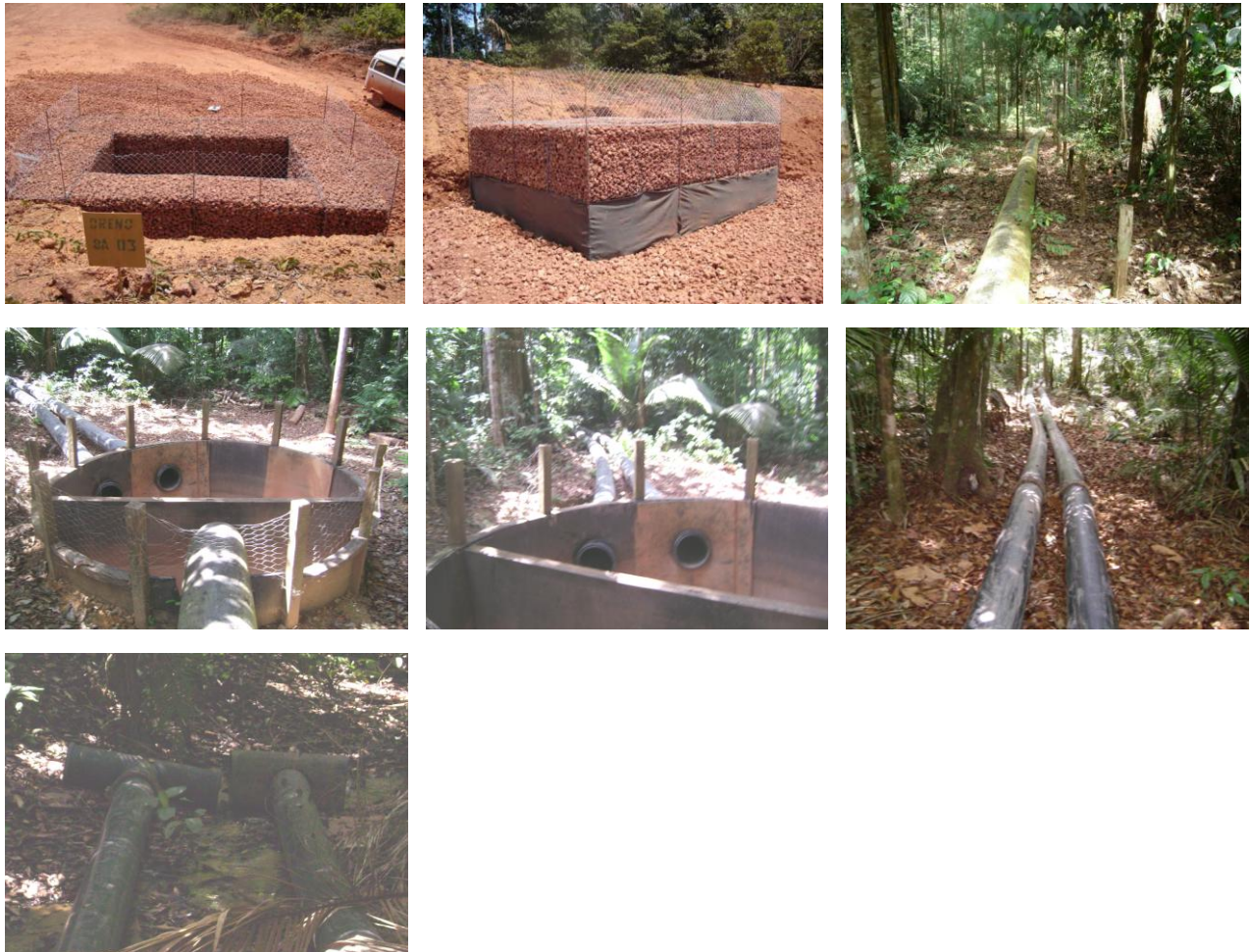
SA 03 (E 0560319 / N 9816338) – Coordenada do ponto do filtro gabião Tubulação com filtro na captação de água e dissipador de energia na ponta inferior.
