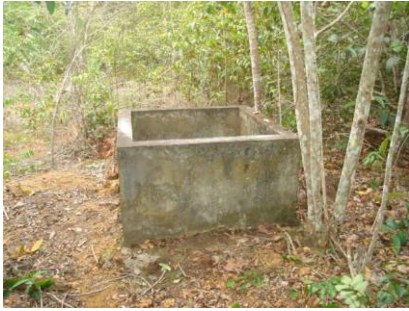
SA 13 (E 0562945 / N 9812796) - Coordenada do ponto da caixa Drenagem com caixa, tubulação e dissipador.
