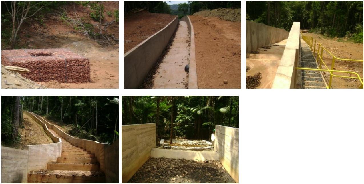
SA 03 (E 0560319 / N 9816338) – Coordenada do ponto do filtro gabião Tubulação com filtro na captação de água e dissipador de energia na ponta inferior.
