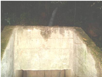
SA 14 (E 0567233 / N 9816668) - Coordenada do ponto do filtro gabião Tubulação com filtro na captação de água e dissipador de energia na ponta inferior.
