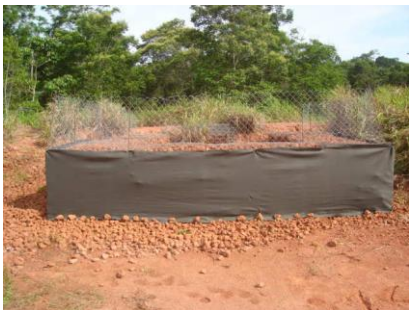
SA 14 (E 0567233 / N 9816668) - Coordenada do ponto do filtro gabião Tubulação com filtro na captação de água e dissipador de energia na ponta inferior.
