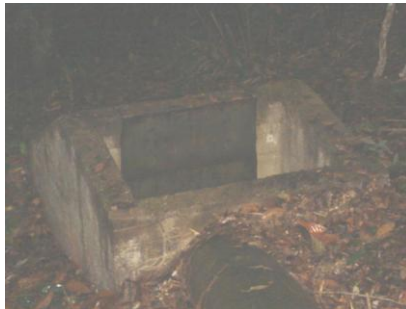
SA 14 (E 0567233 / N 9816668) - Coordenada do ponto do filtro gabião Tubulação com filtro na captação de água e dissipador de energia na ponta inferior.
