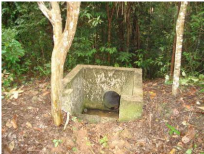
SA 13 (E 0562945 / N 9812796) - Coordenada do ponto da caixa Drenagem com caixa, tubulação e dissipador.
