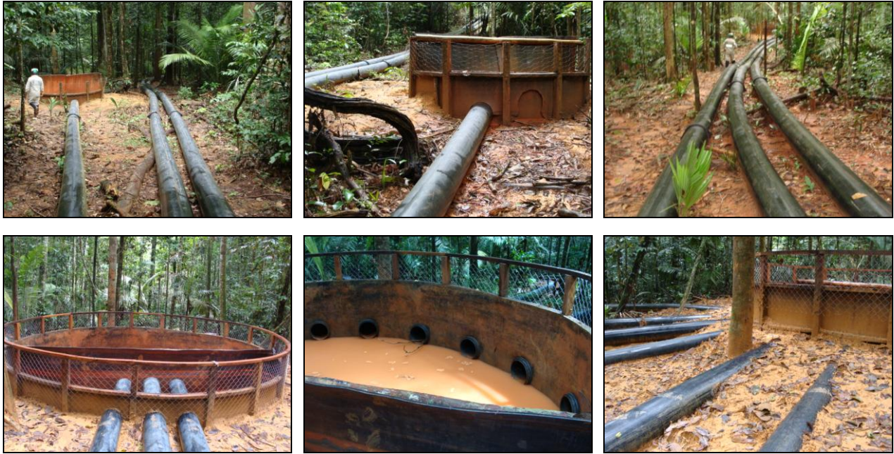
SA 08 (E 0558226 / N 9814019) - Coordenada do ponto do filtro gabião Tubulação com filtro na captação de água e dissipador de energia na ponta inferior.
