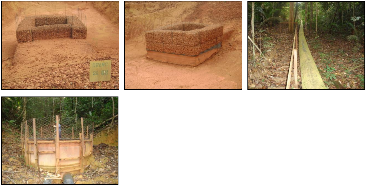
SA 08 (E 0558226 / N 9814019) - Coordenada do ponto do filtro gabião Tubulação com filtro na captação de água e dissipador de energia na ponta inferior.
