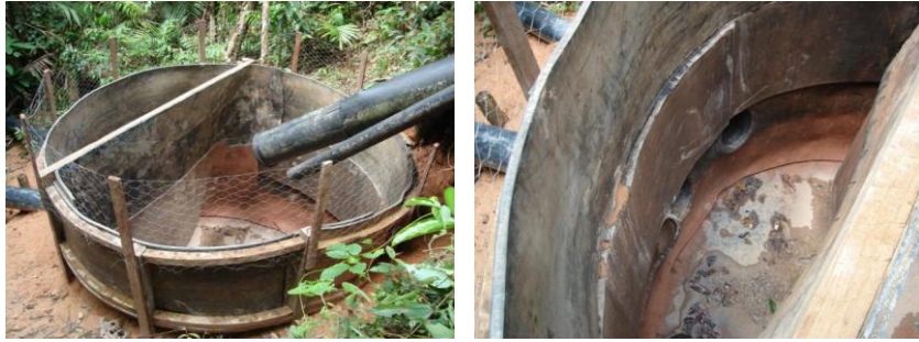
SA 15 (E 0565448 / N 9814922) - Coordenada do ponto do filtro gabião Tubulação com filtro na captação de água e dissipador de energia na ponta inferior.
