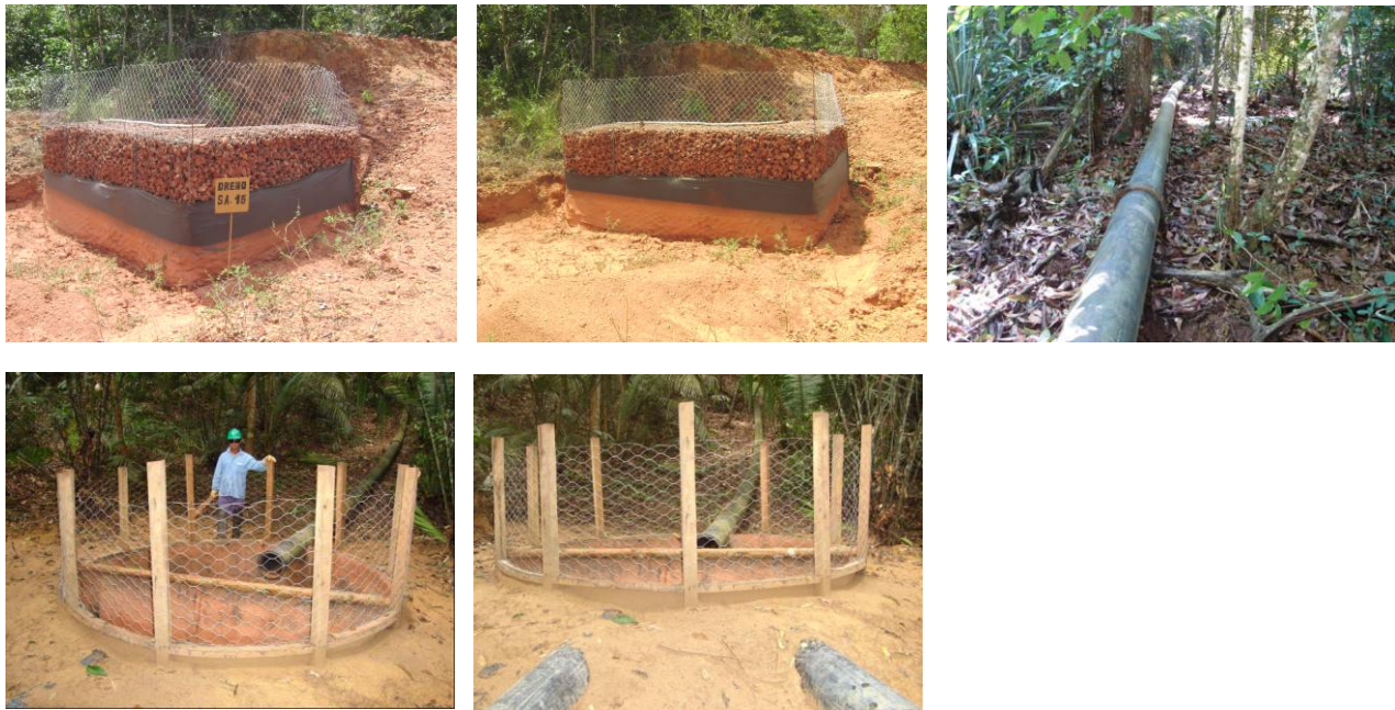
SA 15 (E 0565448 / N 9814922) - Coordenada do ponto do filtro gabião Tubulação com filtro na captação de água e dissipador de energia na ponta inferior.
