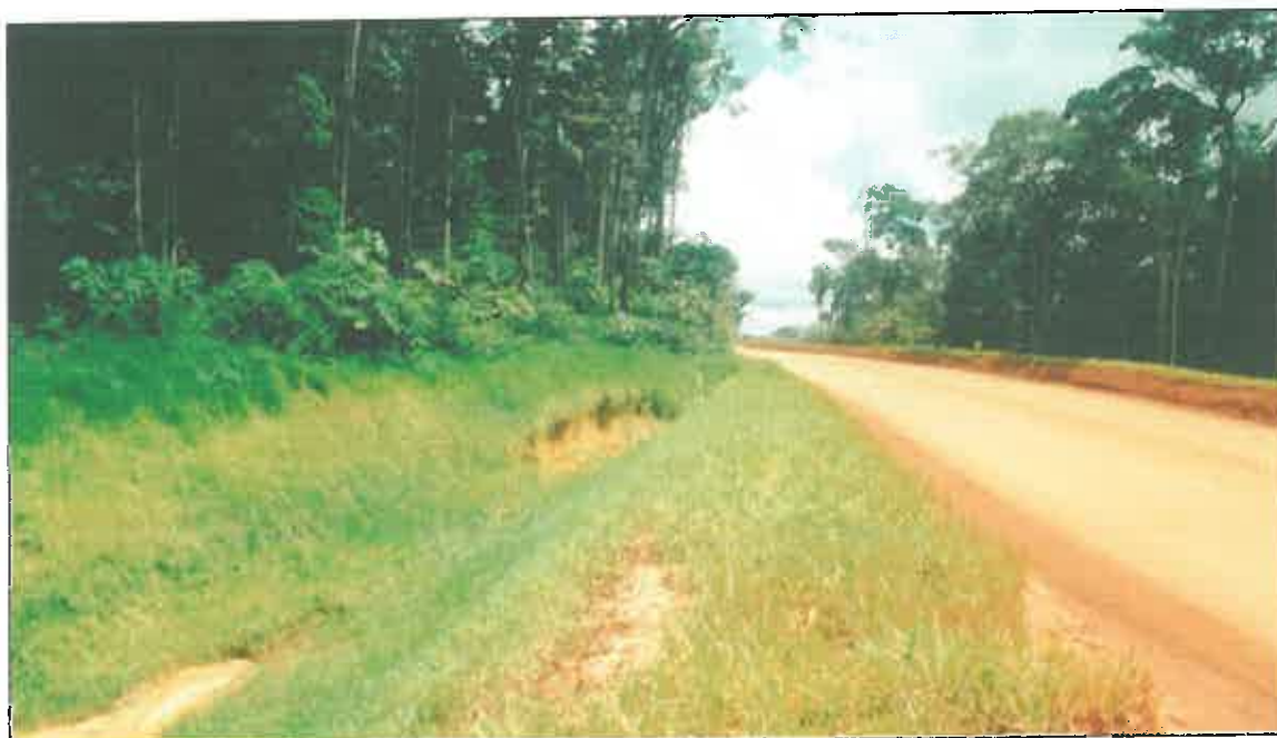
FOTOS 12 - Durante a operação da mina, as estradas de acesso representam uma fonte significativa de impacto sobre os igarapés, promovendo o assoreamento de pontos a jusante dos lançamentos.
