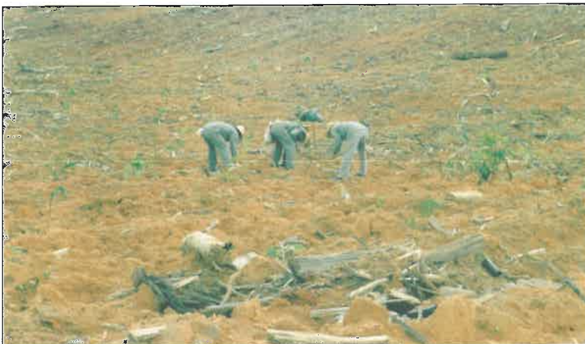
FOTO16 - Após a lavra do minério bauxítico, ocorrem os processos de regularização topográfica, retorno da camada orgânica do solo e revegetação com o plantio de espécies nativas (Mina do Papagaio).
