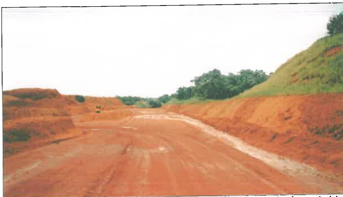
FOTO 14 - Via de acesso interna à Mina do Saracá. Notar o escoamento das águas pluviais paralelamente ao acesso e ...
