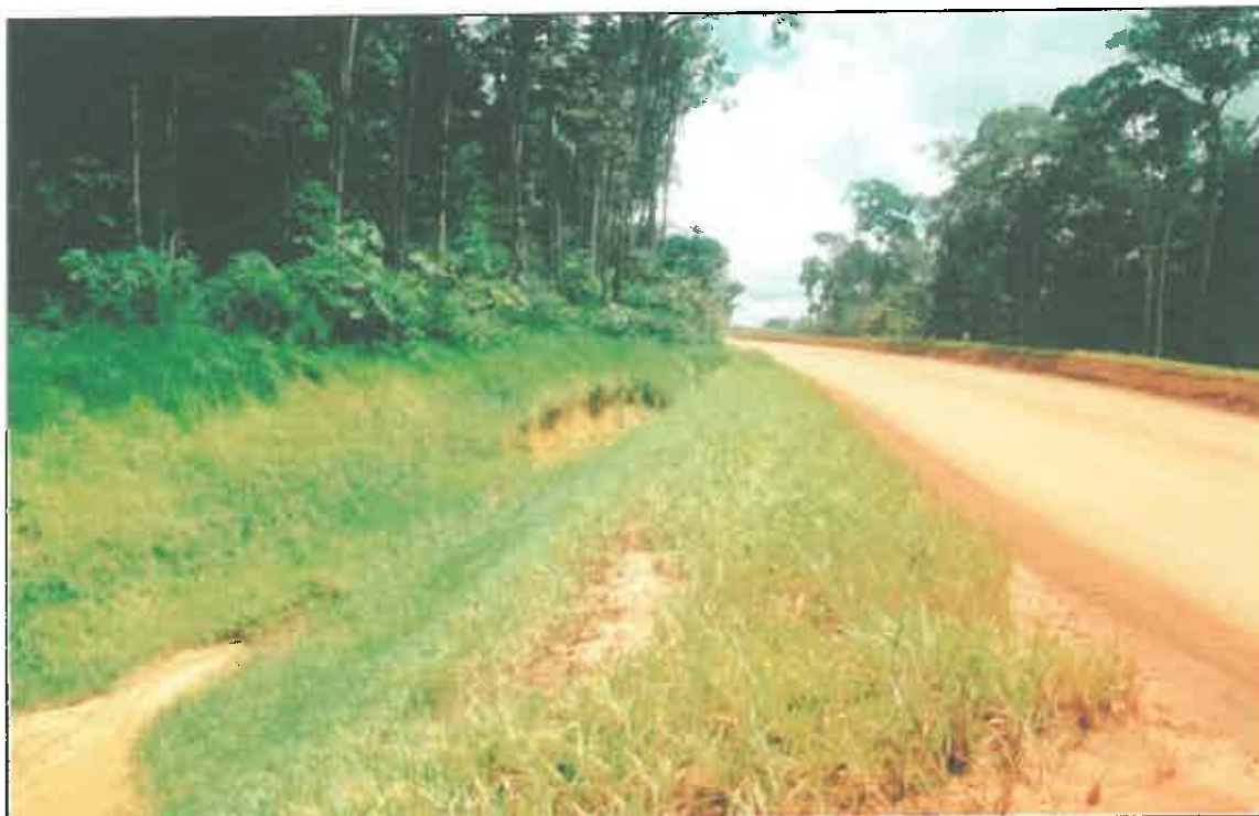
FOTOS 12 - Durante a operação da mina, as estradas de acesso representam uma fonte significativa de impacto sobre os igarapés, promovendo o assoreamento de pontos a jusante dos lançamentos.
