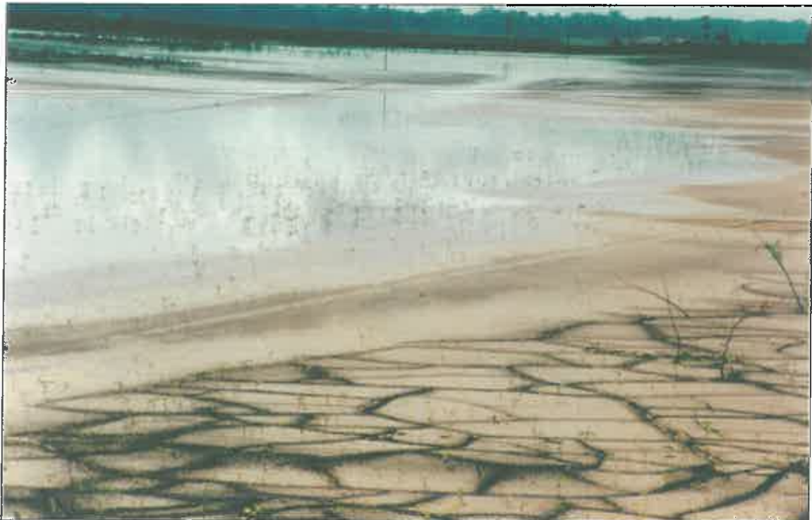
FOTO 21 - Em todo o processo minerário, o maior desafio de recuperação ambiental refere-se às barragens de contenção de rejeito. A foto apresenta um tanque de rejeito exaurido recentemente semeado.
