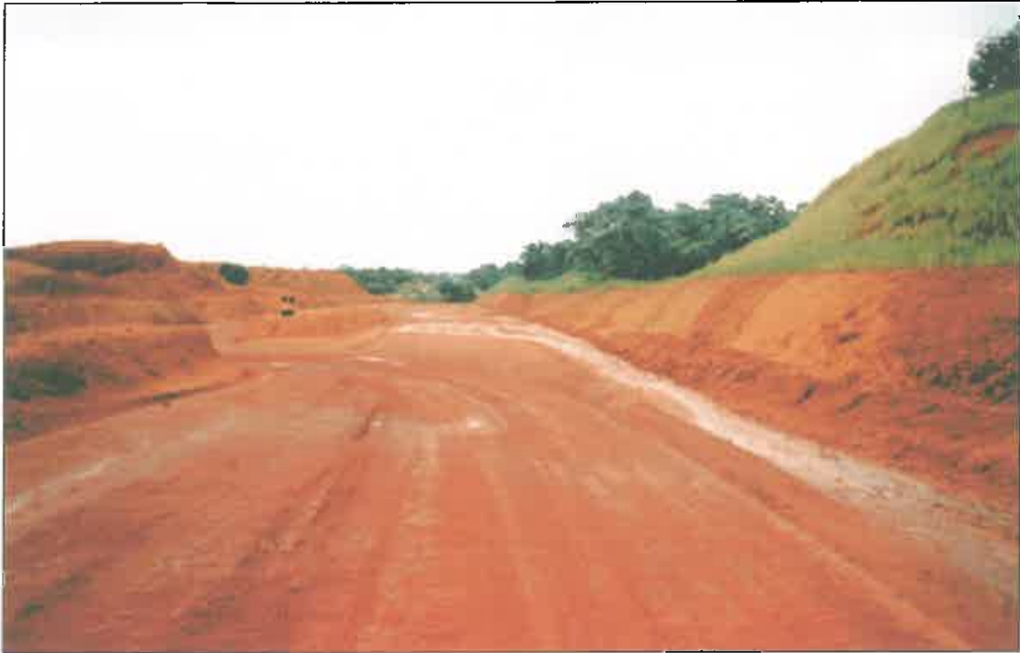
FOTO 14 - Via de acesso interna à Mina do Saracá. Notar o escoamento das águas pluviais paralelamente ao acesso e ...
