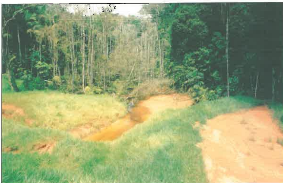
FOTOS 13 - Durante a operação da mina, as estradas de acesso representam uma fonte significativa de impacto sobre os igarapés, promovendo o assoreamento de pontos a jusante dos lançamentos.
