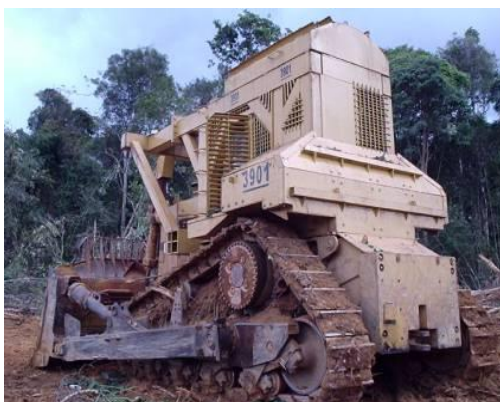
Foto 3.01 – Operação de Desmate com Trator de Esteira
