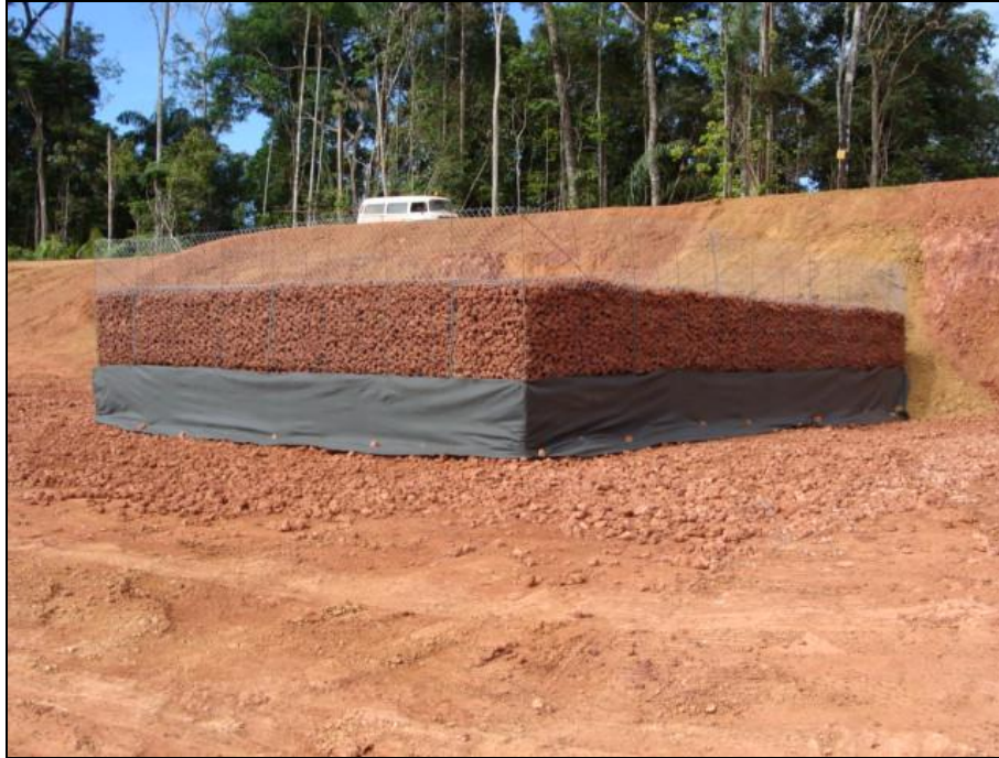
Figura 22 – Filtro de gabião instalado na borda do platô.
