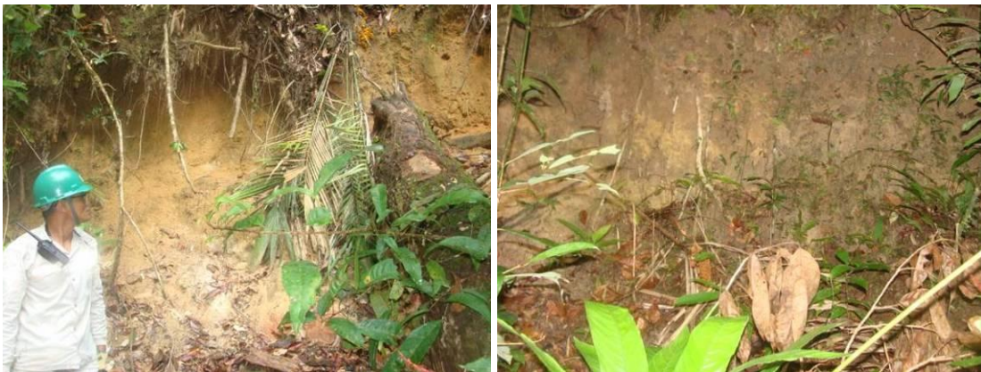
Figura 13 - Fotos da Erosão 3: Coordenada UTM N 9817119 E 0556454
