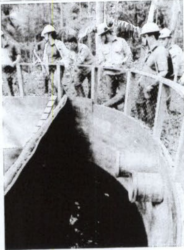
Foto 5: Entrada das linhas do dreno BC-39 no dissipador de energia.
