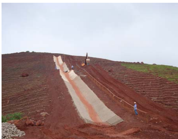
Figura 37: Implantação de sistema de drenagem com o intuito de se formar um gradiente hidráulico que conduza parte considerável da água pluvial para o interior das estruturas drenantes. Ao lado micro-terraços.
