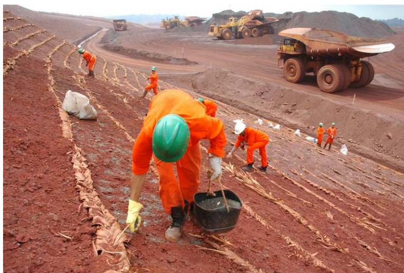
Figura 47: Exemplo de aplicação do mix através do método de semeadura manual, após a prévia implantação de micro-terraços e o microcoveamento.
