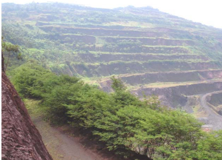
Figura 39: Detalhe de área de cava em conformação final, onde foi implantada vegetação herbácea e arbustiva, semeado em algumas ocasiões com o auxílio de microterraços.
