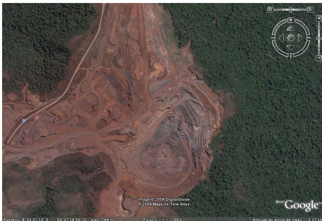
Figura 7: Área da Cava da Mina de N5E e Pilha de Estéril - Unidade de Paisagem III.
