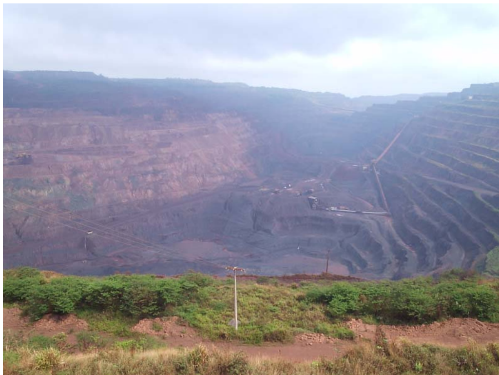
Figura 6: Mina de N4 que compõe o conjunto das estruturas da Unidade de Paisagem III
