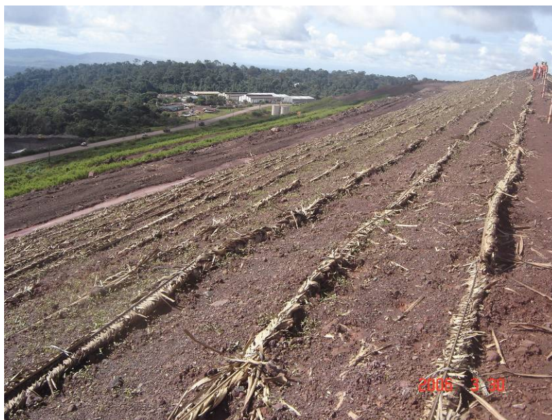
Figura 46: Talude numa PDE onde foi implantada a técnica de micro-terraços de folhas de babaçu.
