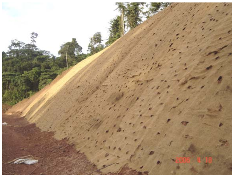
Figura 41: Exemplo de aplicação de tela vegetal em talude de corte.
