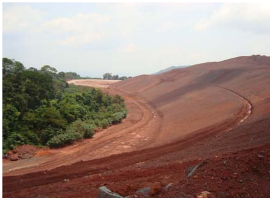
Figura 42: Vista geral da PDE Norte 1, na Mina N5, antes de receber a revegetação, sem a necessidade de microterraços.
