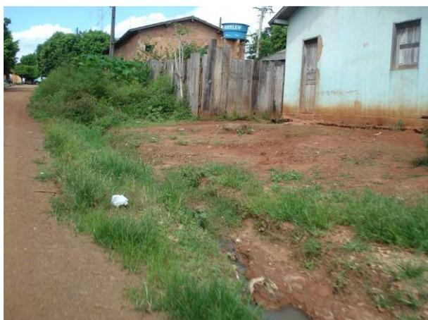
Foto 13: Esgoto doméstico lançado em via pública, Município de Curionópolis/PA.
