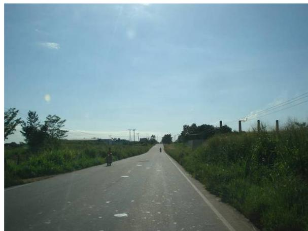
Foto 34: PA-275, Conservação Inadequada da Rodovia – Mato Alto nas Margens e Ausência de Acostamento, Município De Eldorado dos Carajás.
