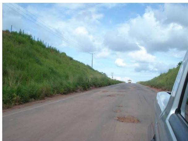
Foto 18: PA-275, Conservação Inadequada da Rodovia, Município de Curionópolis/PA. Fonte: Acervo AMPLO.
