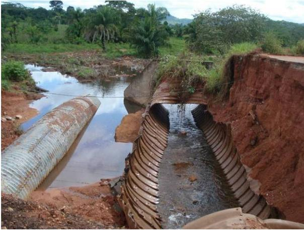
Foto 48: Queda de Ponte na Rodovia PA-275, Município de Parauapebas/PA. Fonte: Acervo AMPLO.
