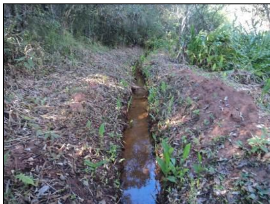
Foto 4.8 - Dreno em área de várzea (Congonhas, coordenadas 614.729 / 7.726.898)
