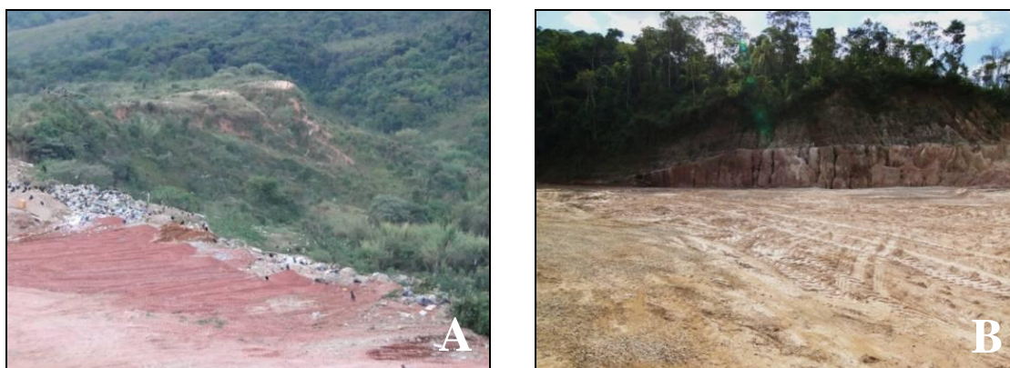
Foto 3 - Pontos destinados a estabelecimento de Áreas de Deposição de Material Excedente com trechos de solo exposto e lixo acumulado.
